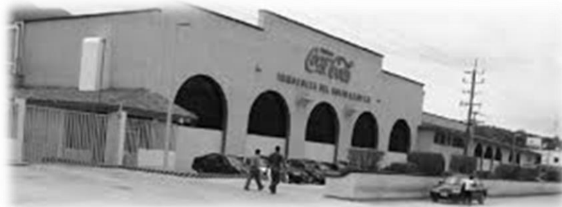
Figura 2. Infraestructura de la Planta ubicada en san Cristóbal de las Casas.
