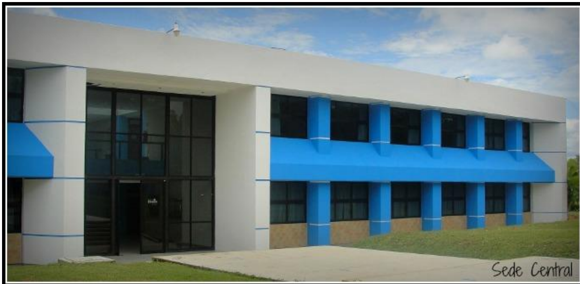
Figura 5.5 Edificio Z del ITTG.
