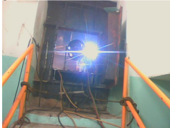
Figura 6.1 Actividad de corte y soldadura
