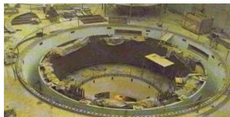
Figura anexo 1.3 Construcción de la base de la Unidad 1
