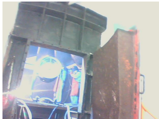
Figura 6.3 Uso de equipo de protección personal en actividad de corte y soldadura
