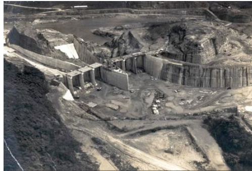
Figura anexo 1.1 Construcción del dique
