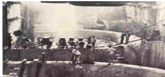
Figura 2. 1 Primeras fases de construcción
