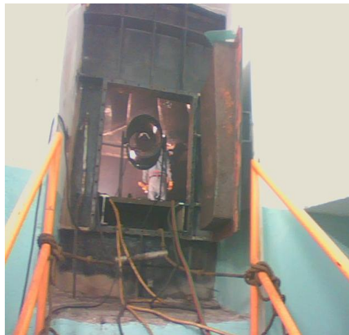
Figura 6.2 Procedimientos de corte y soldadura
