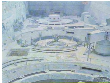
Figura anexo 1.2 Construcción de interna de Casa de Maquinas
