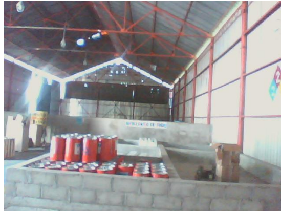
Figuras 4.1 Almacén de Casa de Maquinas
