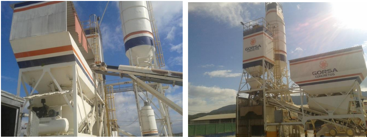
Fotografía 7.1 y 7.2 Silos donde se almacenan materiales para producir el concreto premezclado
