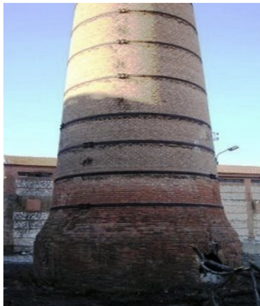
Fig.2.6 Horno para ladrillos
