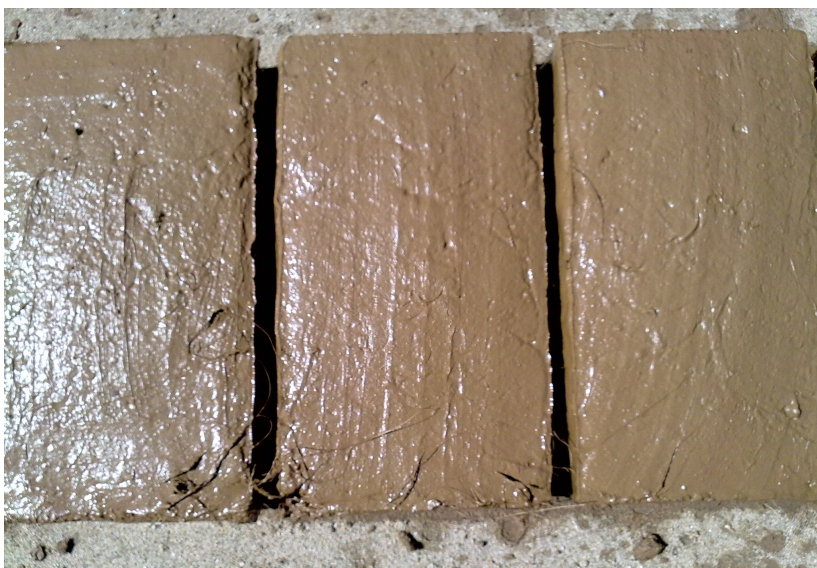
Fig.3.7 Fase de moldeado de los ladrillos hechos con fibra de coco
