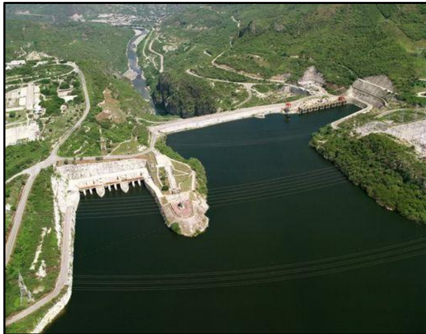
Figura 4-1. Central hidroeléctrica Manuel Moreno Torres.
