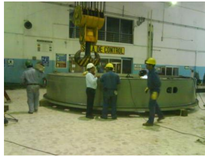
Figura 79.- Inspección de escudo superior en playa de montaje.
