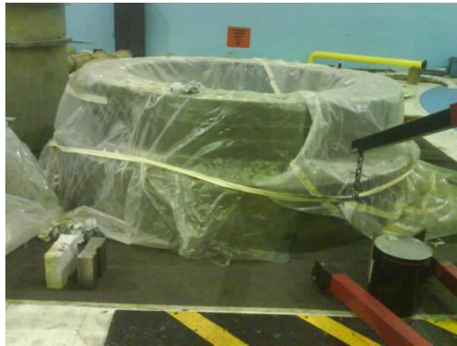
Figura 81.- Collar de carga reparado.
