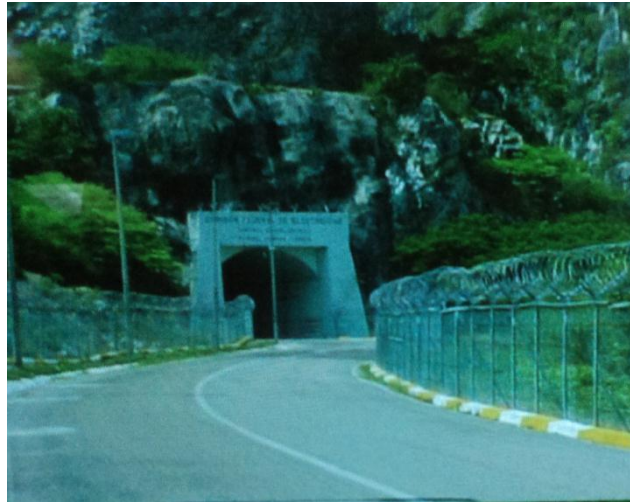
Figura 5.- Entrada a casa de máquinas chicoasén.
