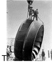
Figura 9.- Rodete de una turbina Francis, Presa Grand Coulee.
