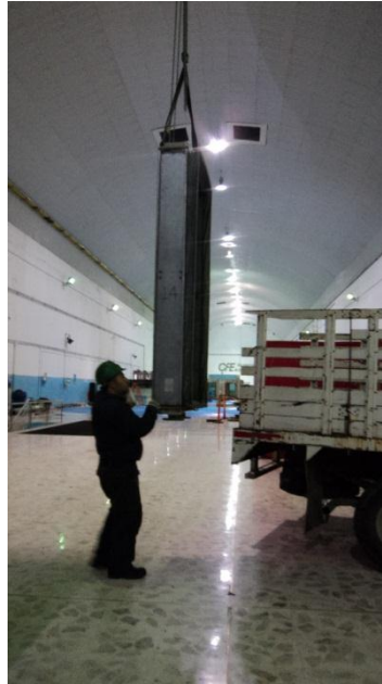
Figura 49.-desmontaje de radiadores y llevados a mantenimiento a almacén.
