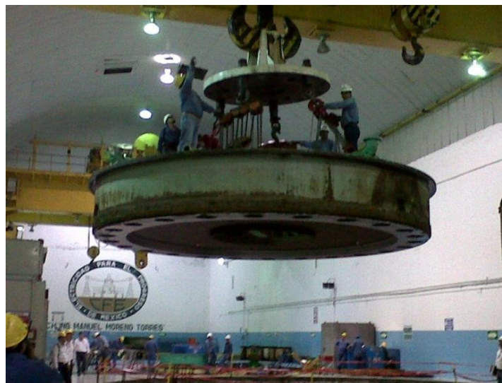
Figura 37.- Escudo superior desmontado.
