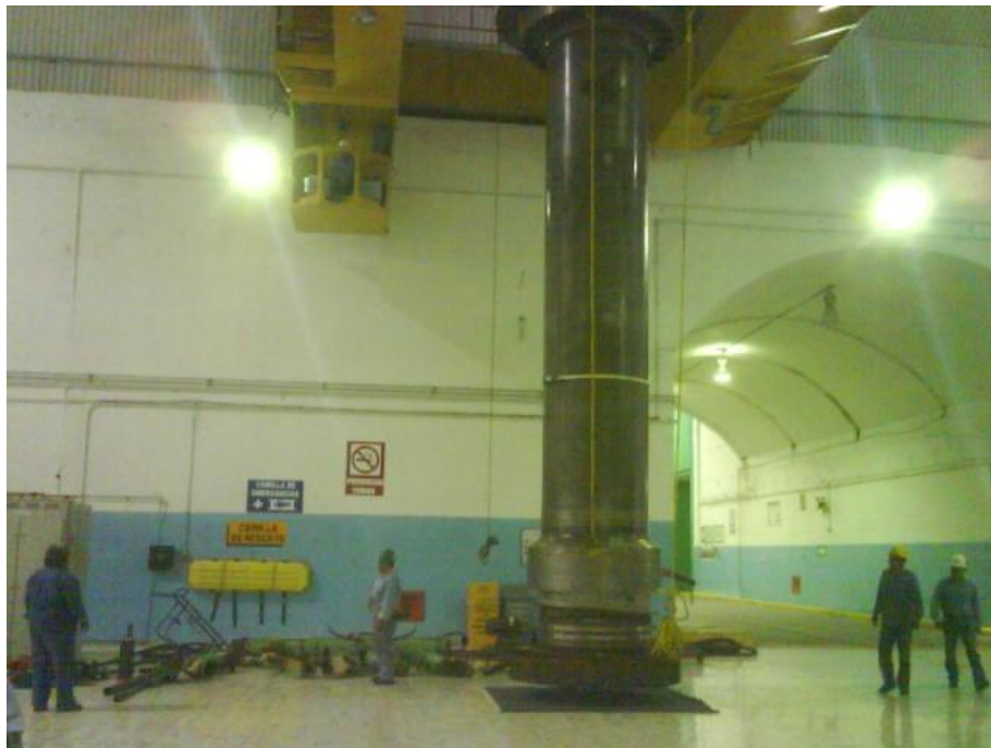
Figura 44.- Transporte de flecha a zona de mantenimiento entre las pasasolas de los pisos de playa de montaje.
