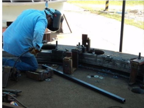
Figura 55.- Removiendo placas de desgaste del Escudo superior.
