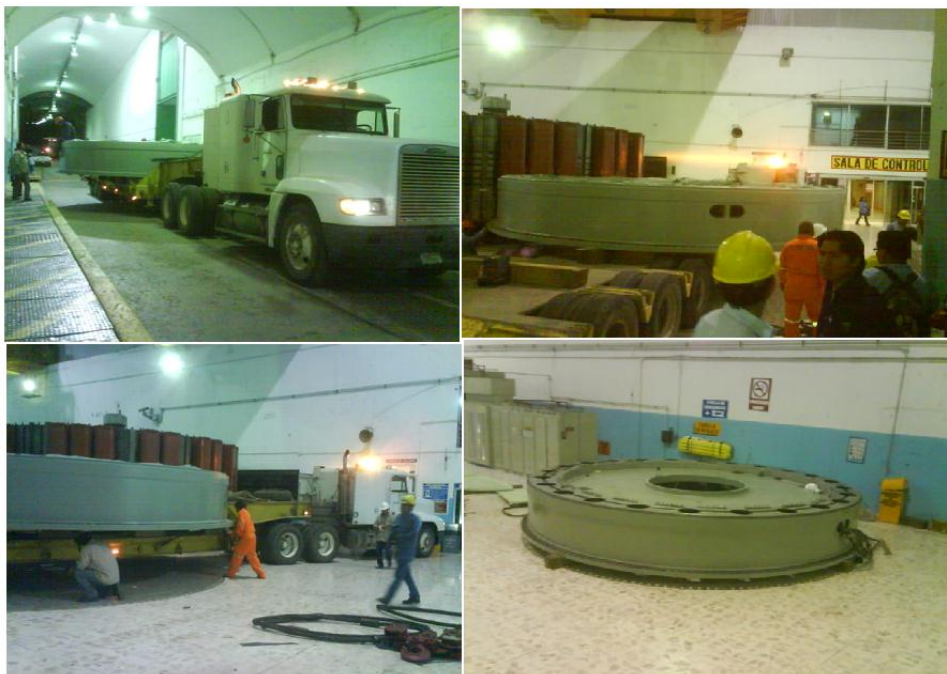
Figura 80.- Transporte de escudo superior.
