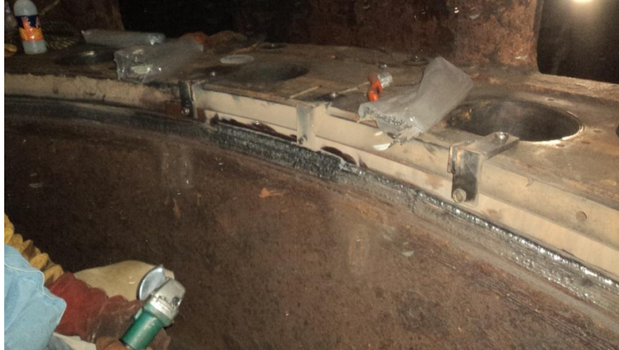
Figura 51.- Desmontaje de placas de desgaste.
