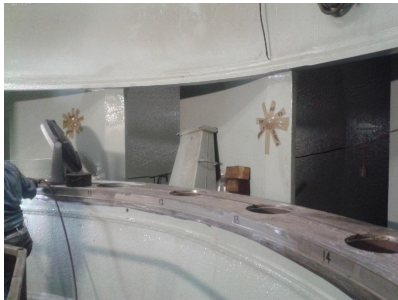
Figura 54.- Escudo inferior con placas instaladas.
