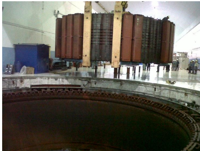
Figura 28.- Rotor y polos desmontándose
