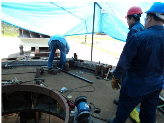
Figura 56.- Rectificado en Escudo superior.
