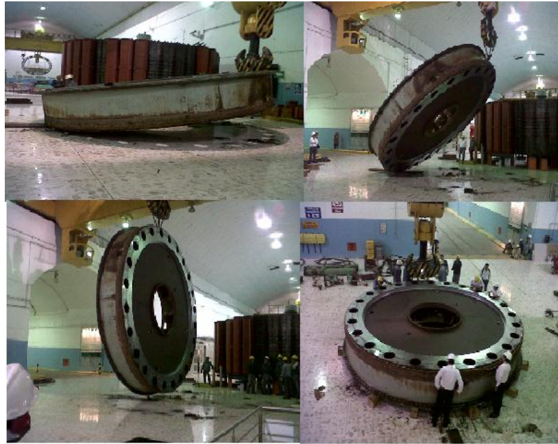
Figura 40.- Maniobras para voltear el escudo superior.
