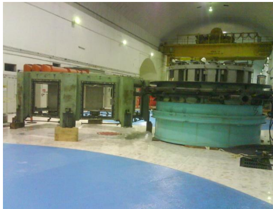
Figura 36.- Chumacera guía turbina.
