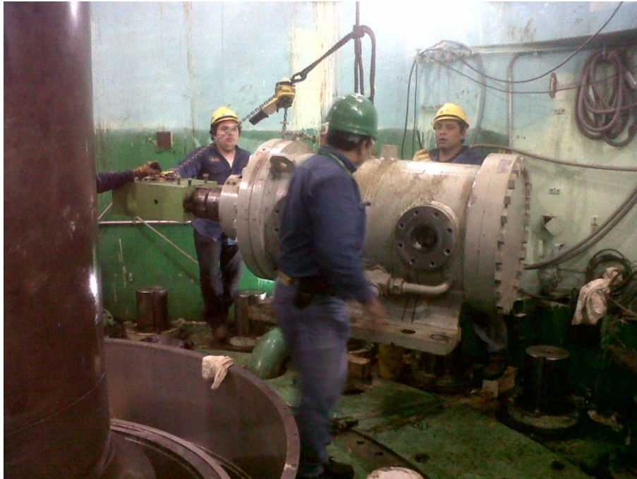
Figura 31.- Desacoplado el servomotor principal.
