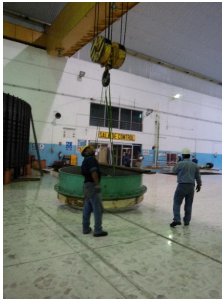
Figura 38.- Chumacera suspendida por la grúa de 40 ton-fuerza.
