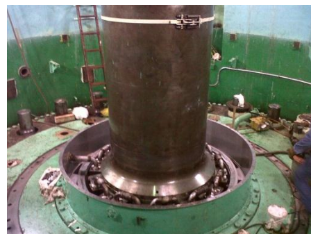
Figura 78.- Montaje conjunto flecha-rodete.
