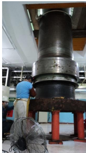
Figura 70.- mantenimiento al manguito de flecha.
