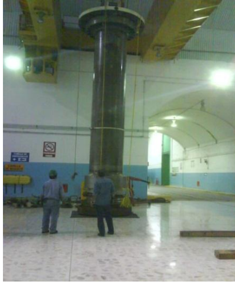
Figura 43.- Desmontaje de flecha.
