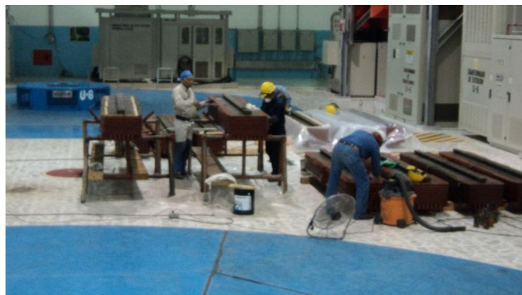
Figura 75.- Mantenimientos a los polos del rotor.
