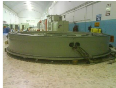
Figura 77.- Escudo superior reparado.
