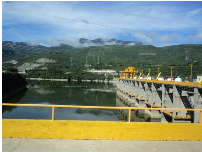
Figura 3.- Obra de toma.
