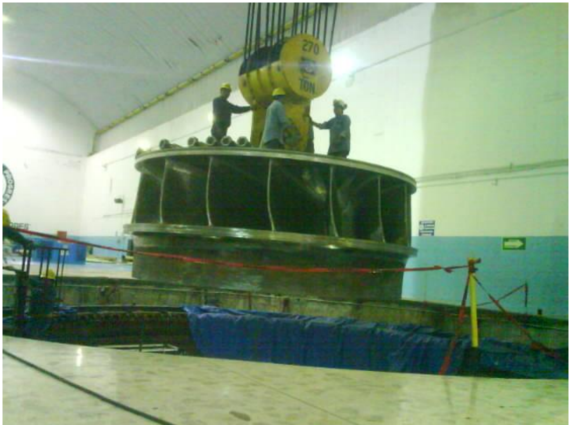
Figura 46.- desmontaje de rodete Francis.
