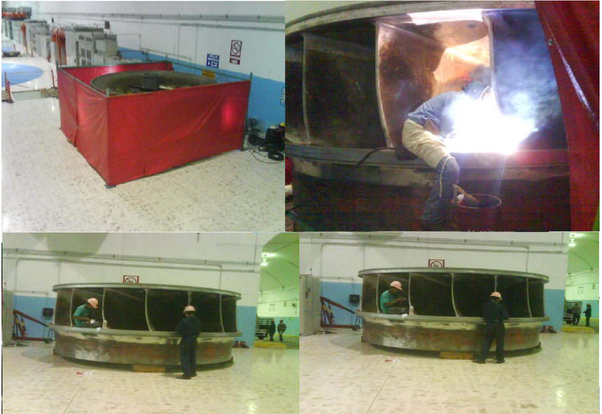
Figura 59.- Reparación en rodete
