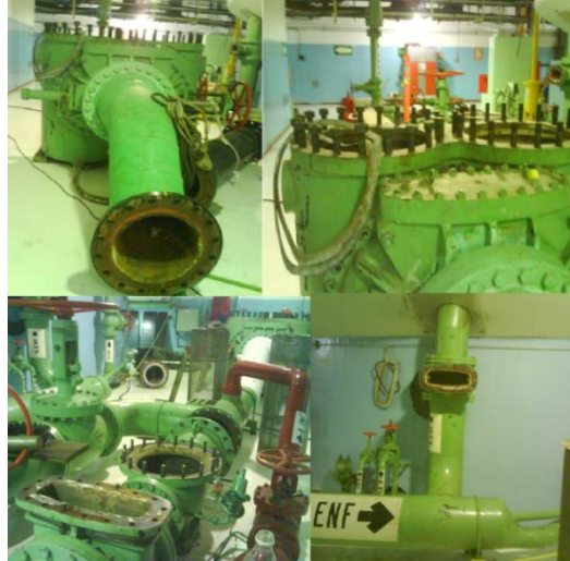
Figura 87.-Mantenimiento a sistema de agua de enfriamiento.
