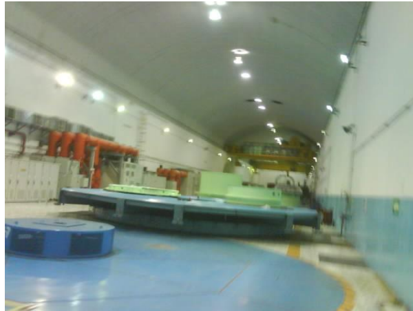
Figura 25.- Soporte de la chumacera guía generador.
