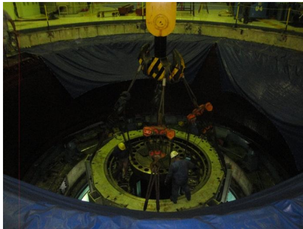
Figura 30.- sección visible de la chumacera de carga.
