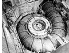
Figura 10.- Espiral de entrada de una turbina Francis, Presa Grand Coulee.
