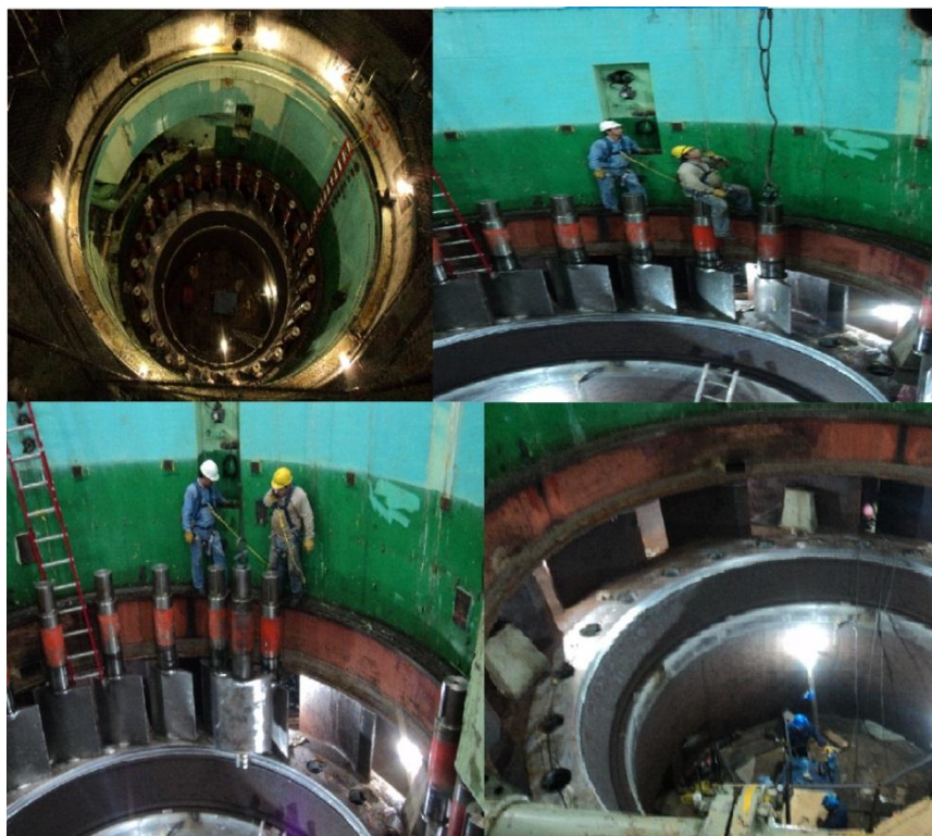
Figura 48.- Secuencia de desmontaje de álabes móviles.
