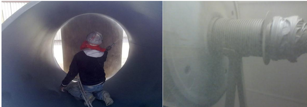
Fig.114 Limpieza SAND BLAST (arena silica)
