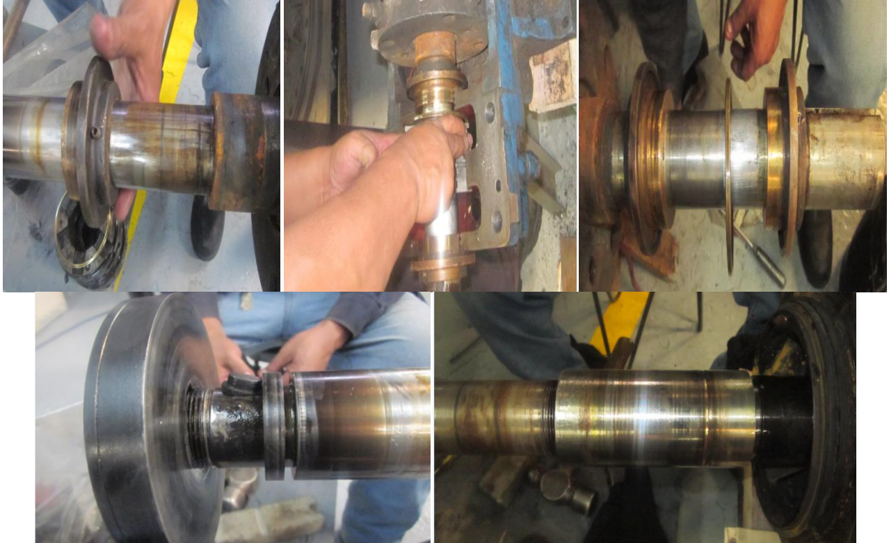
Fig. 63 Desmontaje del deflector de aceite, chumaceras radiales, disco axial y Mangas, anillos de lubricación, etc.
