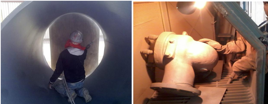
Fig.76 Limpieza SAND BLAST (arena sílica)
