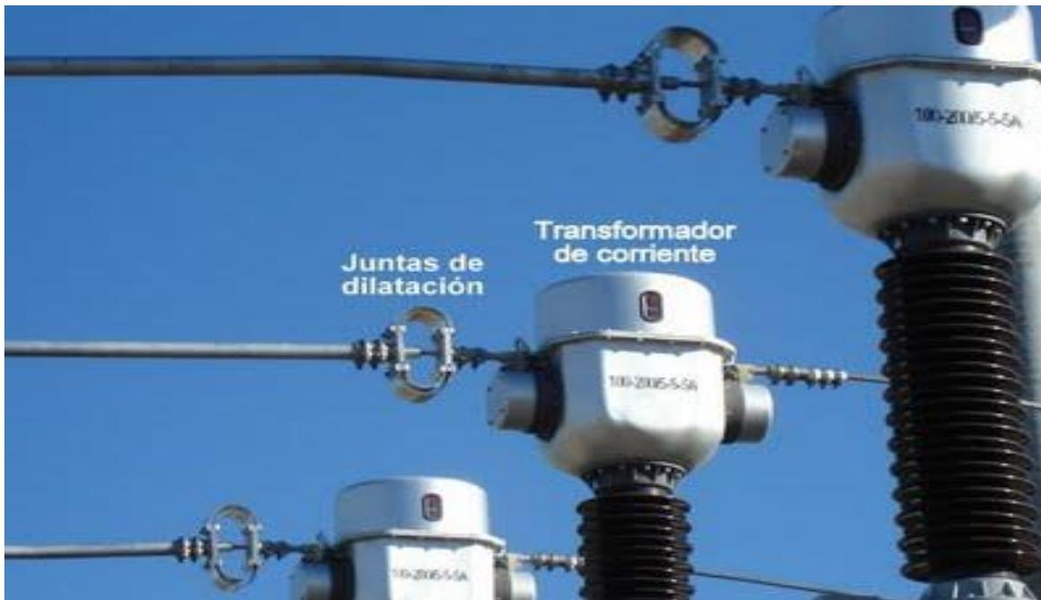
*Fig. 1.3 Transformadores de corriente*
