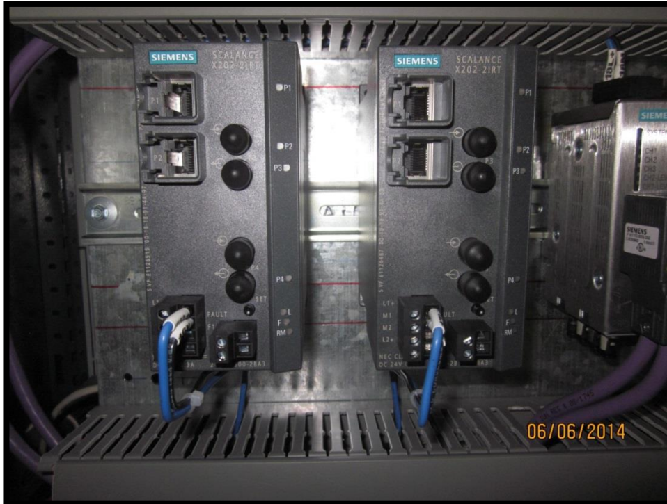
Fig. 3.39. SCALANCE X202-2IRT; Modo Redundante.
