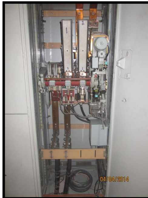
Fig. 3.14. Quebradora de campo; U-1.
