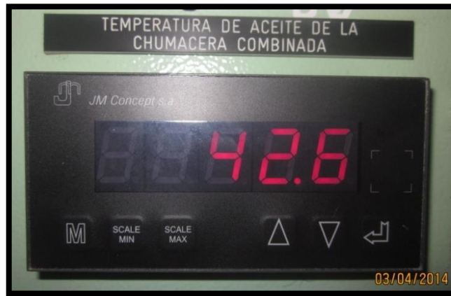
Fig. 3.30. Termómetro de temperatura digital; a base de RTD.
