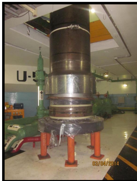
Fig. 3.8. Flecha U-1; Cortesía CFE.
