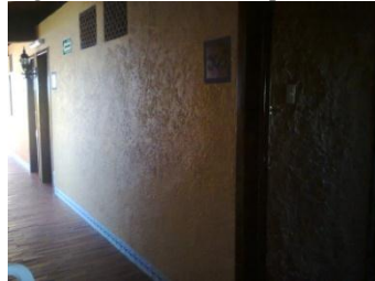
Fig. 3.19 Iluminación pasillo c)
