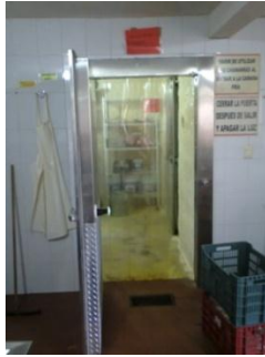
Fig. 3.5 Iluminación cocina fría
