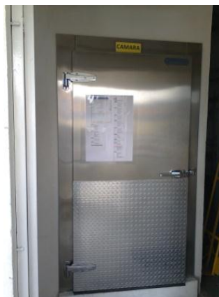
Fig. 3.12 Iluminación cocina fría
