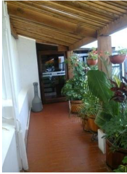
Fig. 3.14 Iluminación pasillo a)
