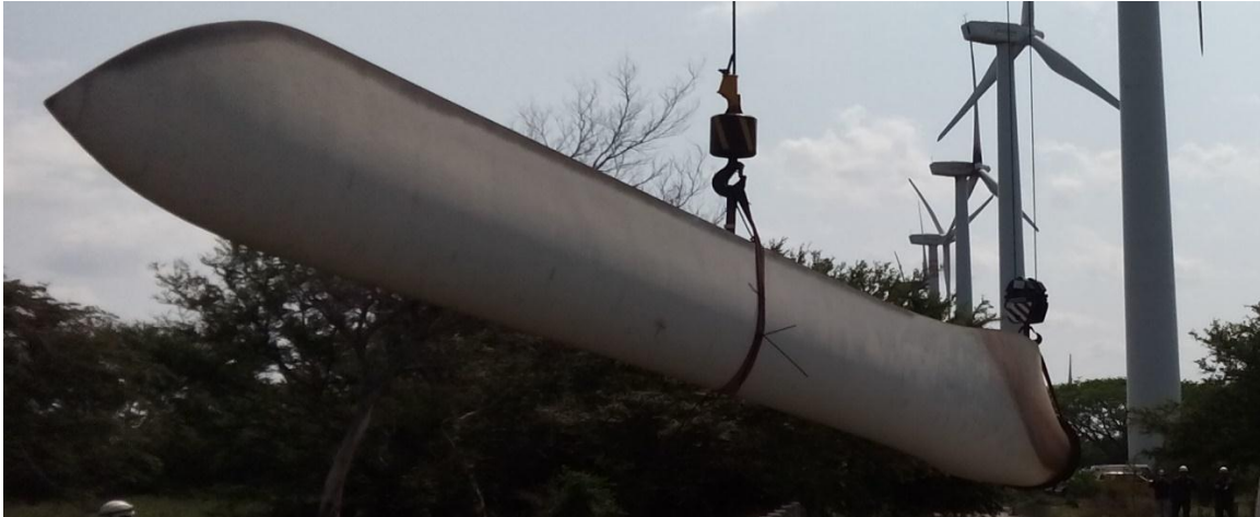
Fig. 3.4 Desmontaje de pala.
