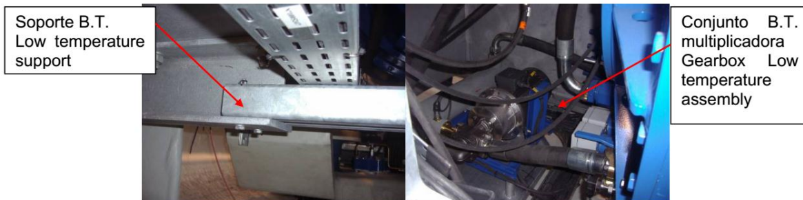
Fig. 3.70 Conjunto de bajas temperaturas de la multiplicadora.
