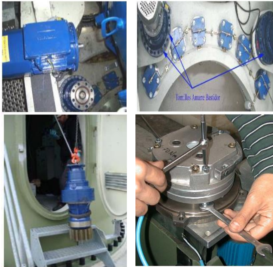
Fig. 3.54 Cambio de reductora.
