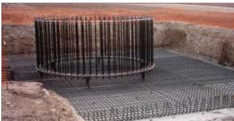
Fig. 3.9 Cimentación de la torre.
