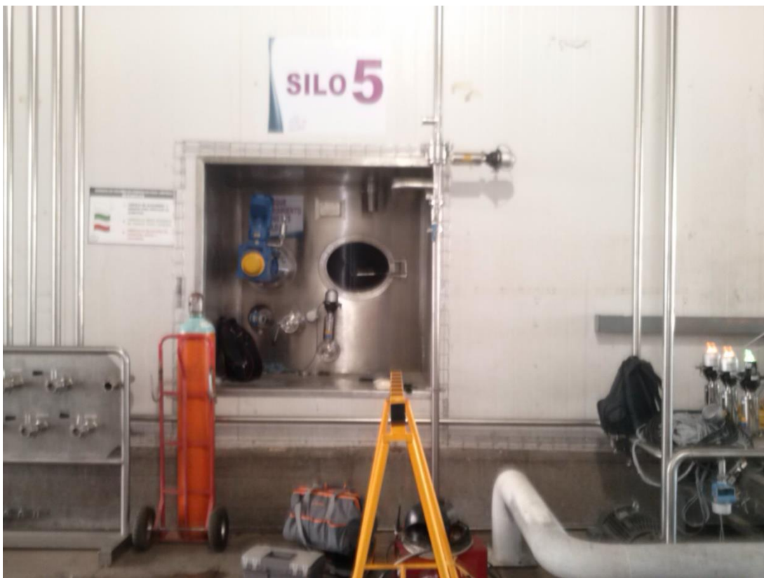
Fig.3.88.- Colocación de charola para cableado se equipos silo 5
