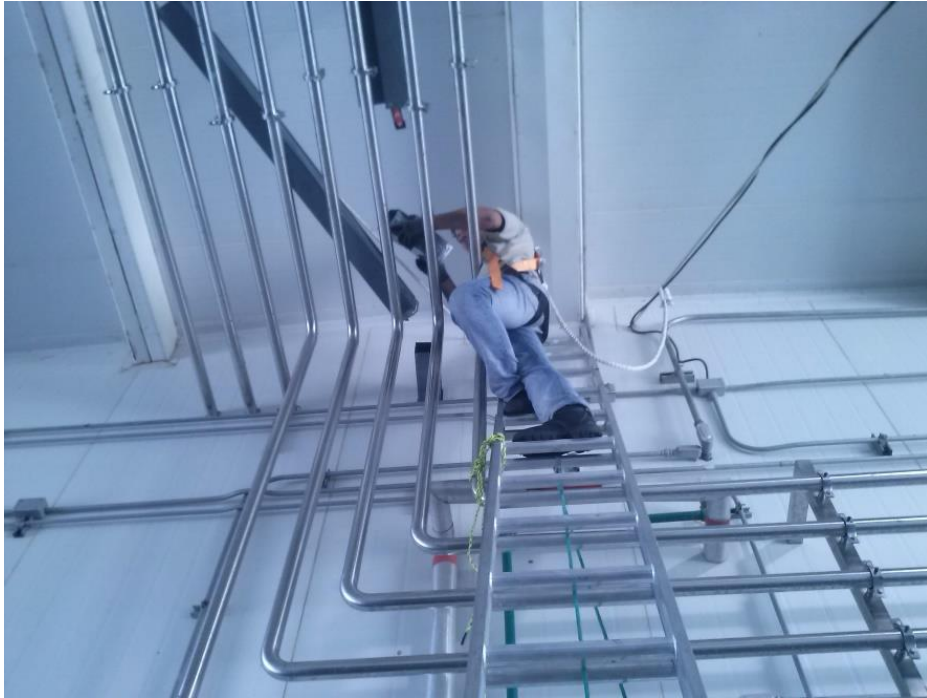
Fig.3.75.- Colocación de ducto metálico
