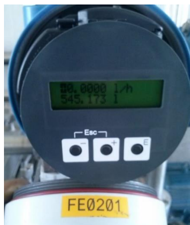
Fig.3.140.- Lectura del sensor de flujo FE.02.01
