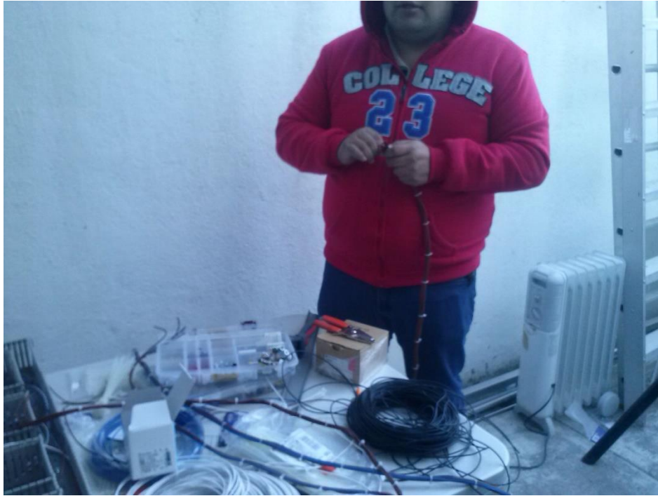
Fig.3.59.- Preparación del cableado
