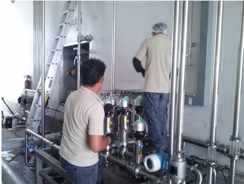
Fig.3.116.- Conexión de aire del cabezal de válvulas
