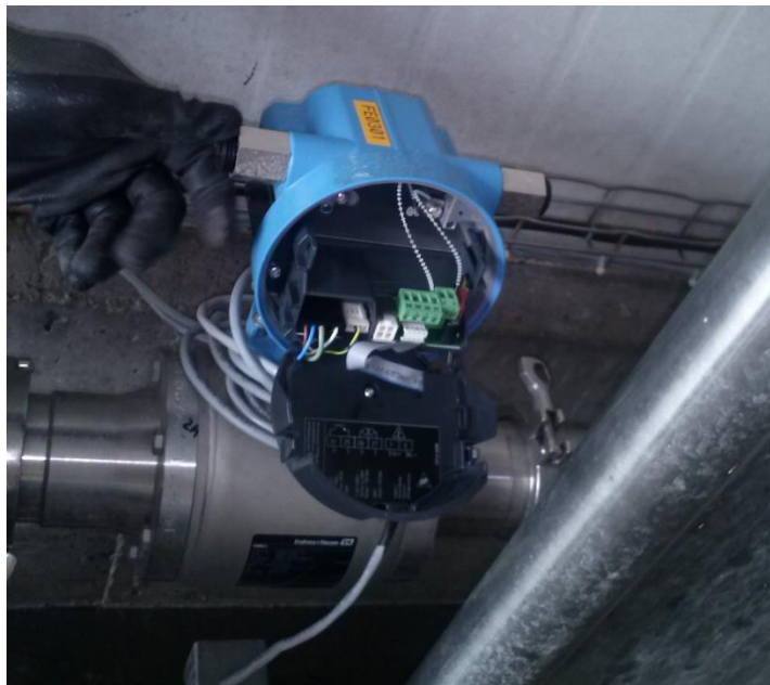
Fig.3.108.- Conexión del sensor de flujo electromagnético FE.03.01
