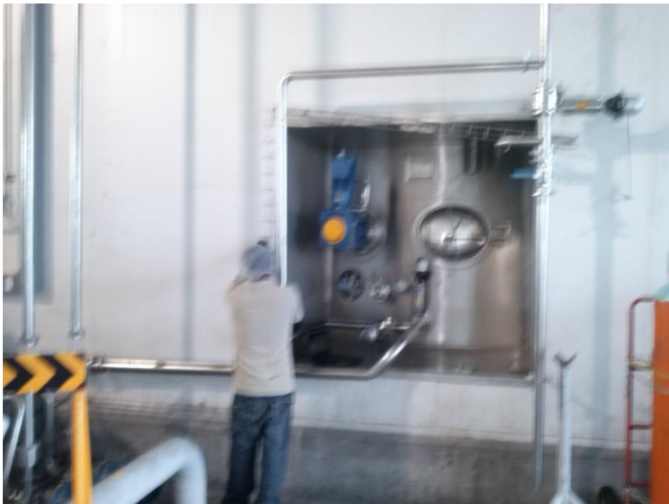
Fig.3.90.- Colocación de charola para cableado de equipos silo 6
