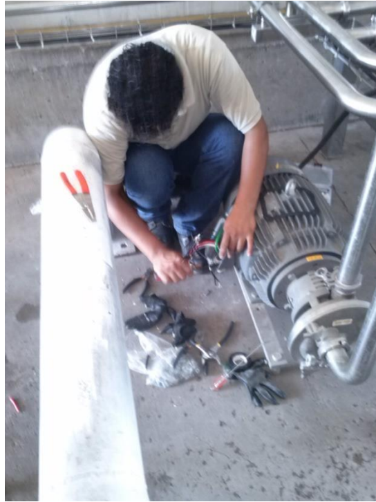
Fig.3.106.- Conexión de la bomba PC.01.03
