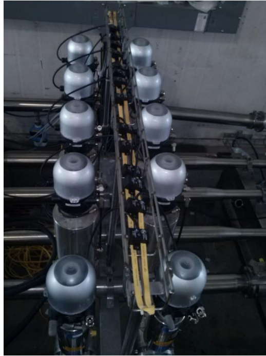
Fig.3.115.- Instalación cable ASI-bus y conexionado válvulas
