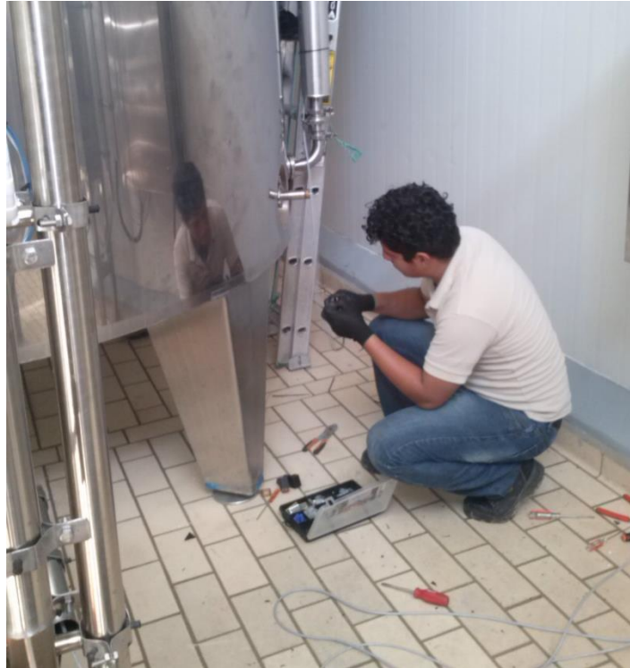
Fig.3.110.- Conexión del sensor de nivel bajo LL.02.01
