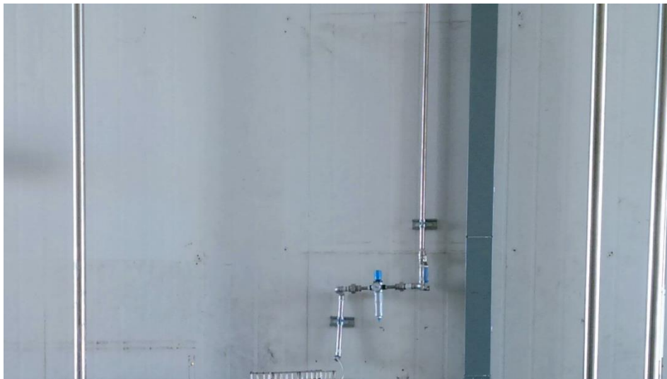
Fig.3.82.- Colocación de tubería de aire y unidad de mantenimiento
