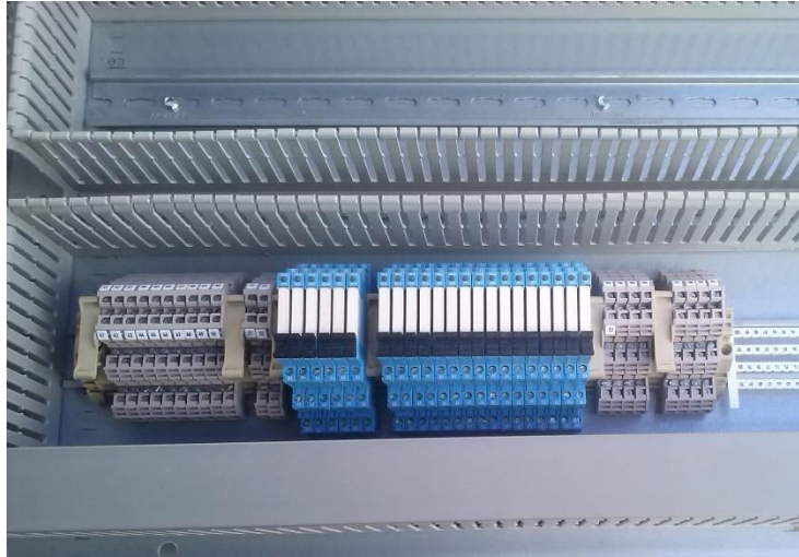
Fig.3.56.- Colocación de los equipos y elementos del tablero
