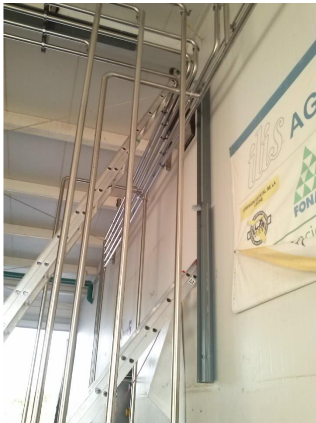
Fig.3.74.- Colocación de ducto metálico en la pared
