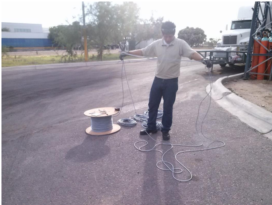
Fig.3.100.- Medición y corte de cables de control
