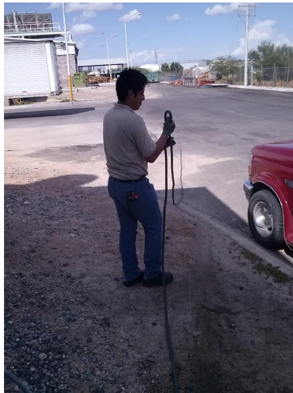
Fig.3.97.- Medición y corte de cable de fuerza
