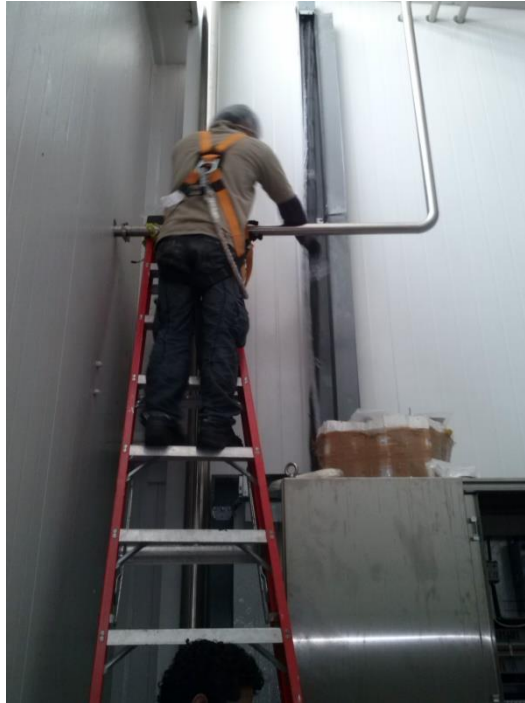
Fig.3.104.- Colocación del cableado área de descremadora
