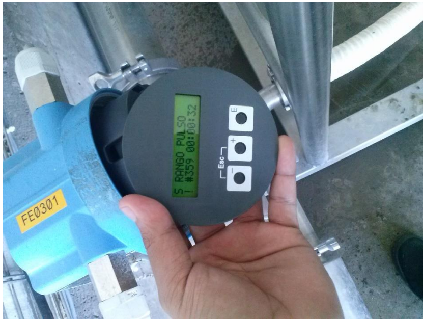
Fig.3.121.- Configuración del rango de pulso del medidor de flujo electromagnético
