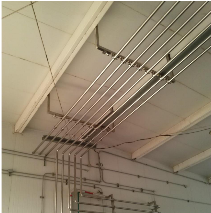
Fig.3.73.- Colocación de ducto metálico
