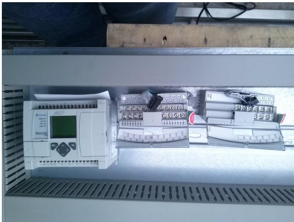
Fig.3.55.- Colocación de los equipos y elementos del tablero
