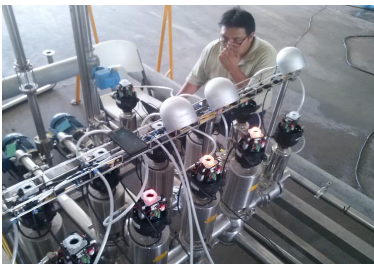
Fig.3.127.- Prueba de las válvulas del cabezal
