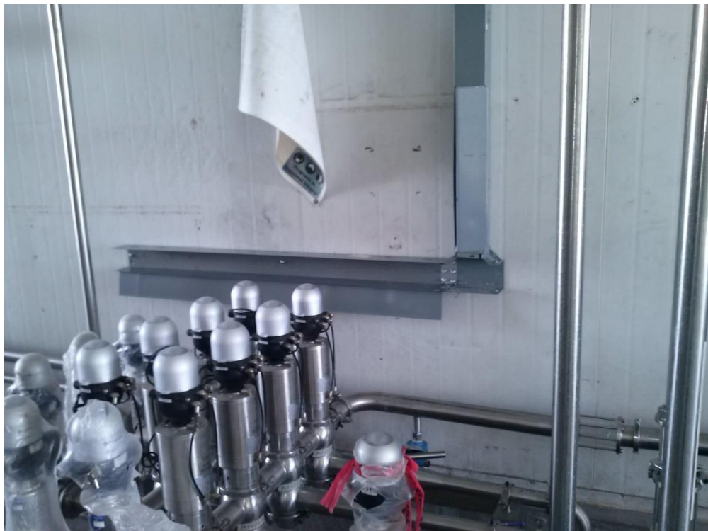
Fig.3.76.- Colocación de ducto metálico
