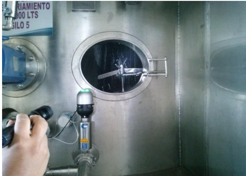
Fig.3.139.- Prueba con agua de saneamiento silo 5
