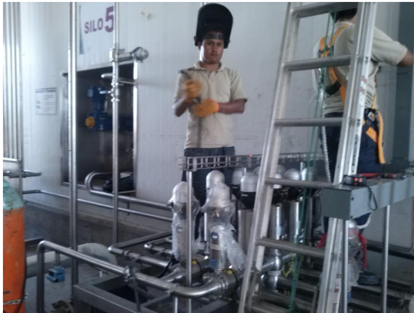
Fig.3.85.- Colocación de charola para cableado
