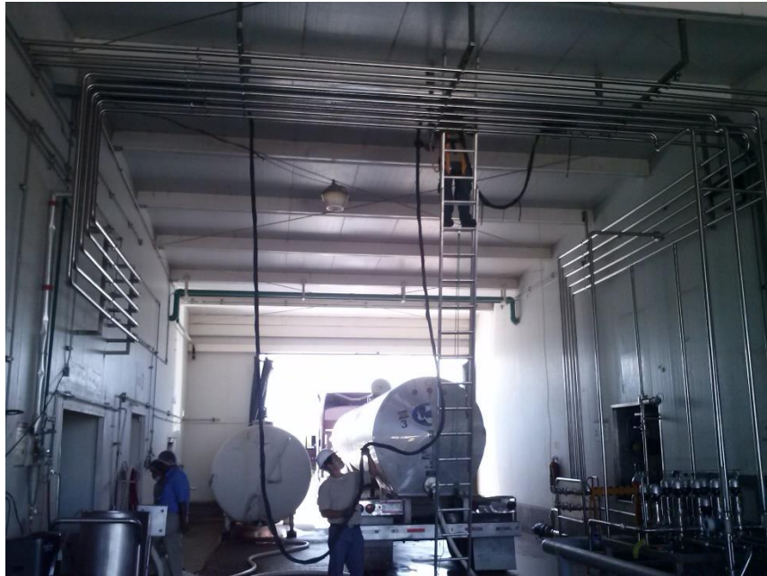
Fig.3.103.- Colocación del cableado área de recepción de leche
