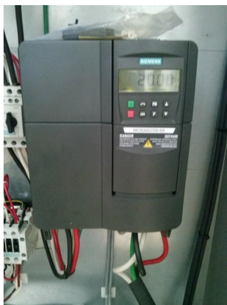
Fig.3.123.- Configuración del variador de velocidad Micromaster 420
