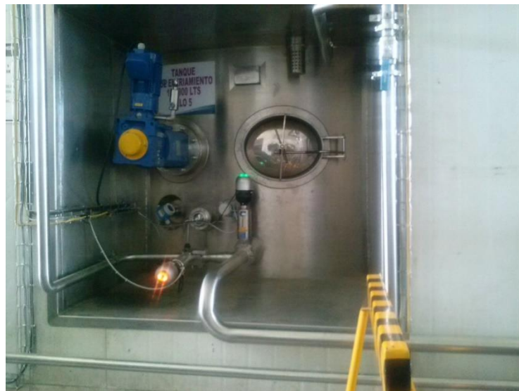
Fig.3.135.- Accionamiento de válvulas pruebas de secuencias
