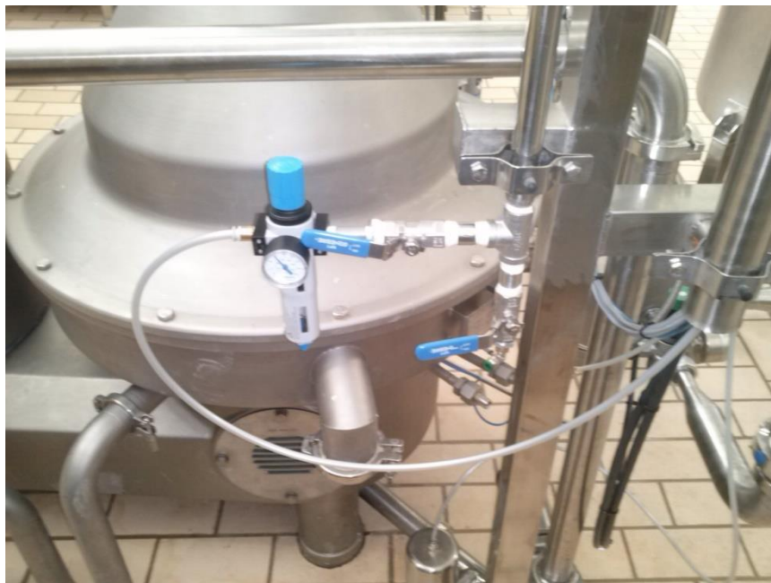
Fig.3.118.- Conexión de aire área de descremadora
