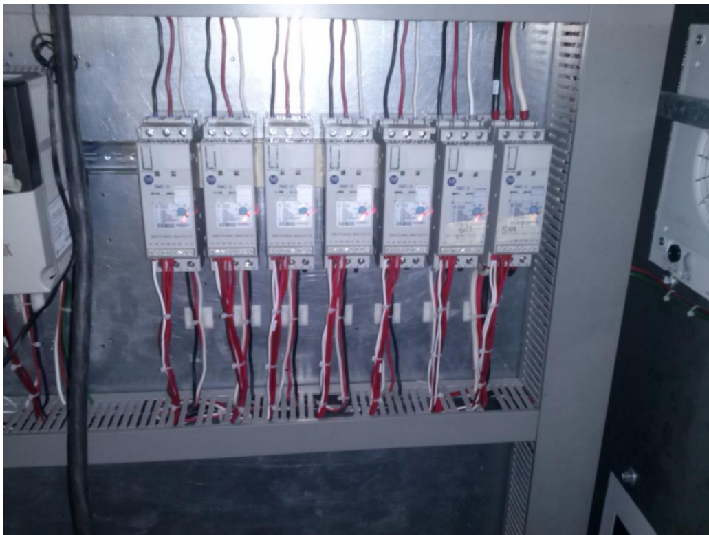
Fig.3.131.- Prueba de accionamiento de arrancadores
