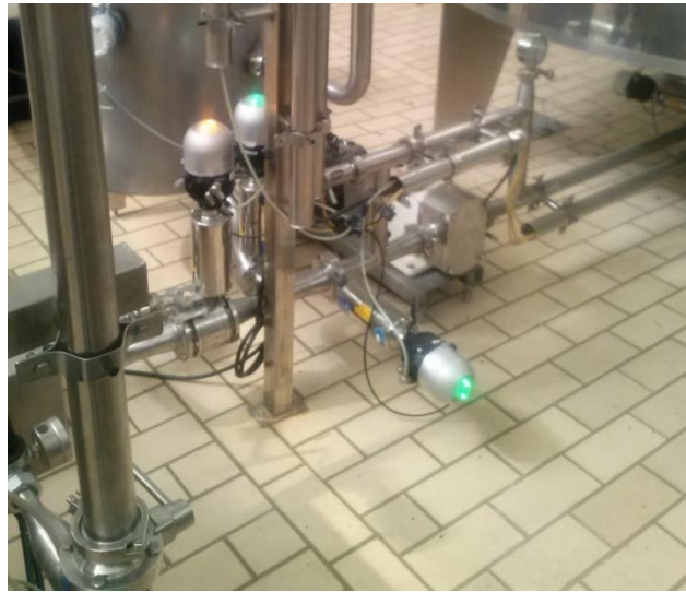
Fig.3.134.- Accionamiento de válvulas pruebas de secuencias
