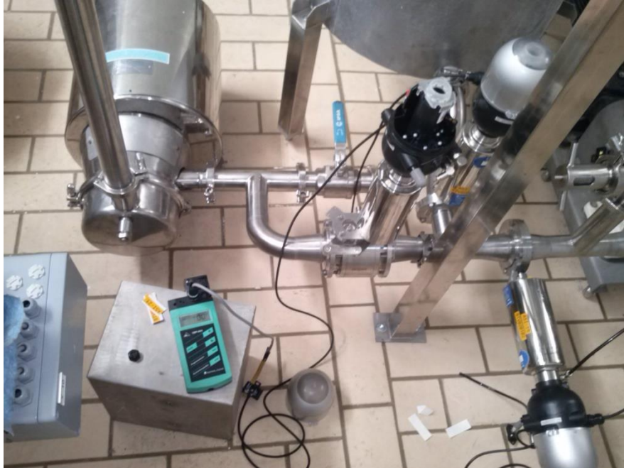
Fig.3.124.- Direccionamiento de válvulas
