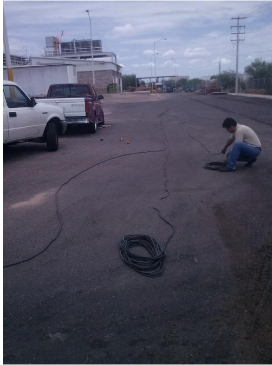
Fig.3.96.- Medición y corte de cable de fuerza
