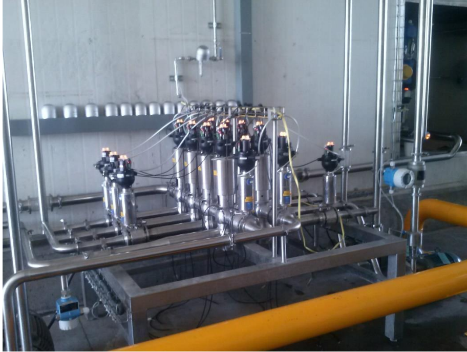
Fig.3.128.- Prueba de las válvulas del cabezal
