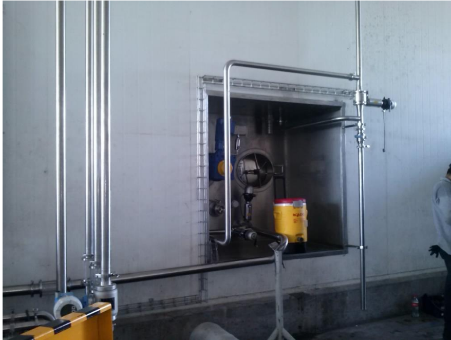
Fig.3.91.- Colocación de charola para cableado de equipos silo 6
