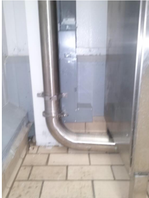
Fig.3.77.- Colocación de ducto metálico salida del tablero
