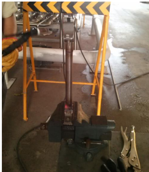
Fig.3.78.- Fabricación de soportería para tubería de aire
