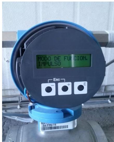
Fig.3.120.- Configuración del modo de función del medidor de flujo electromagnético
