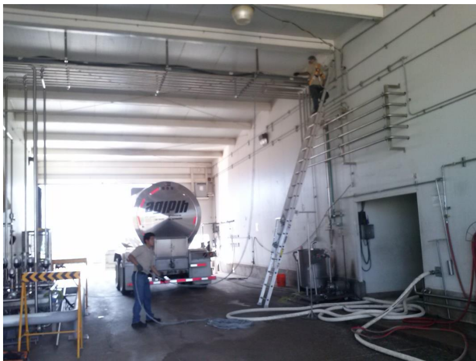
Fig.3.104.- Colocación del cableado área de recepción de leche
