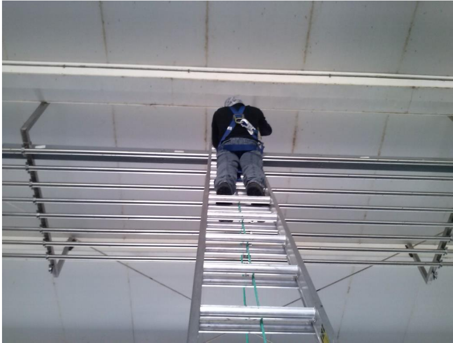
Fig.3.74.- Colocación de ducto metálico respetando normas de seguridad industrial
