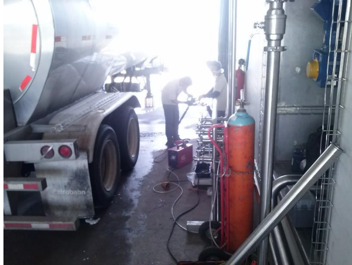
Fig.3.87.- Colocación de charola para cableado
