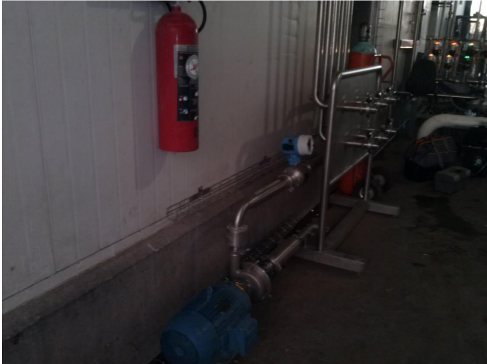
Fig.3.89.- Colocación de charola para cableado de bomba recepción de leche
