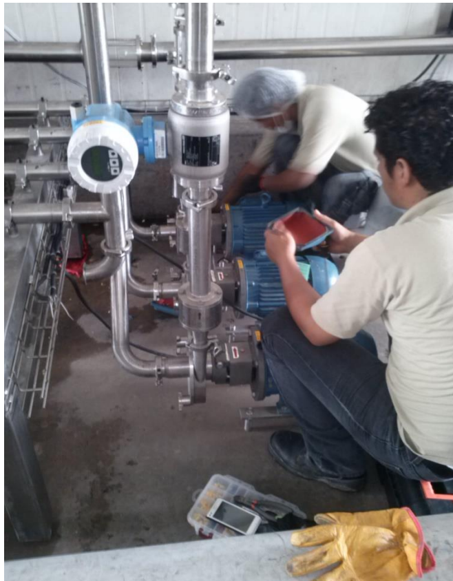
Fig.3.107.- Conexionado de bombas trifásicas
