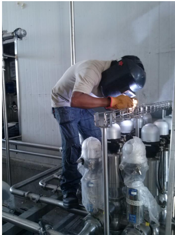
Fig.3.86.- Soldado de charola para cableado
