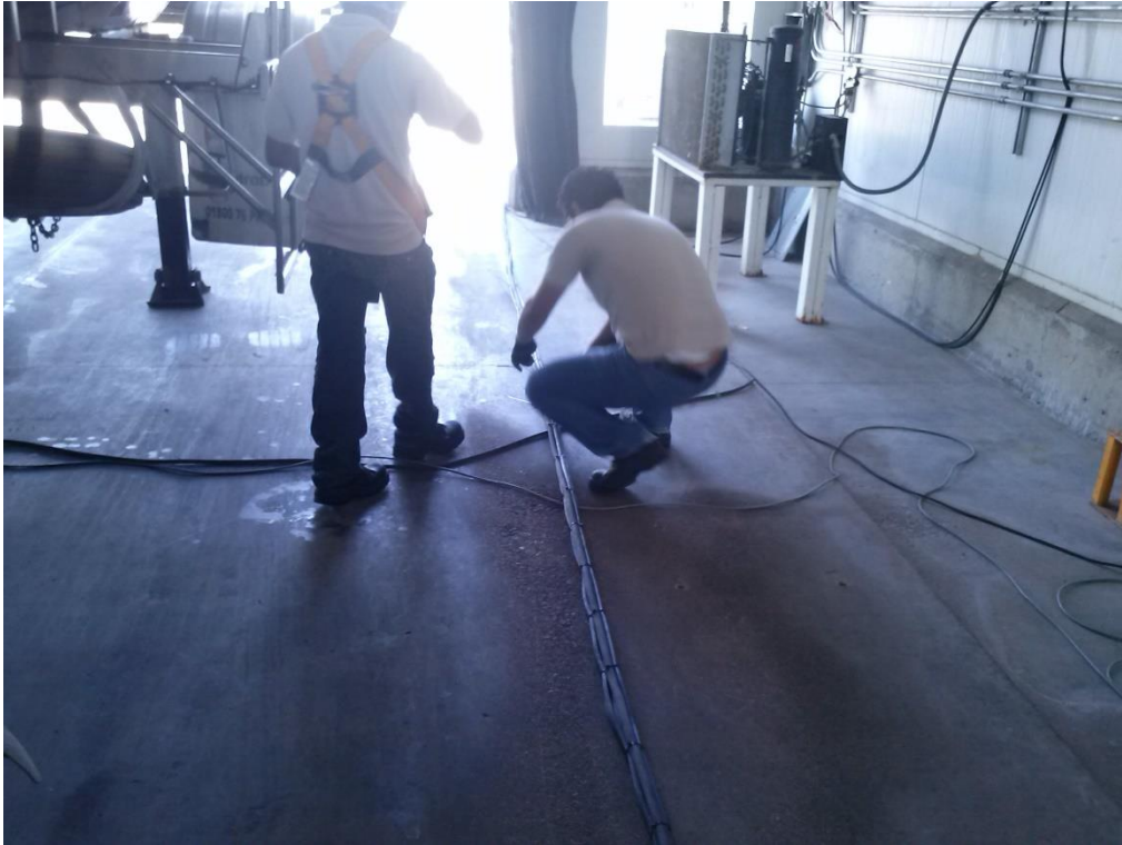
Fig.3.98.- Ensichado de cables de fuerza
