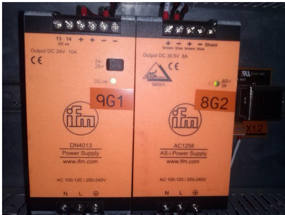
Fig.3.70.- Etiquetado de fuentes de voltaje de DC de control
