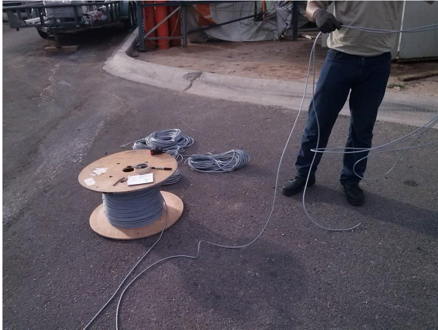
Fig.3.99.- Medición y corte de cables de control
