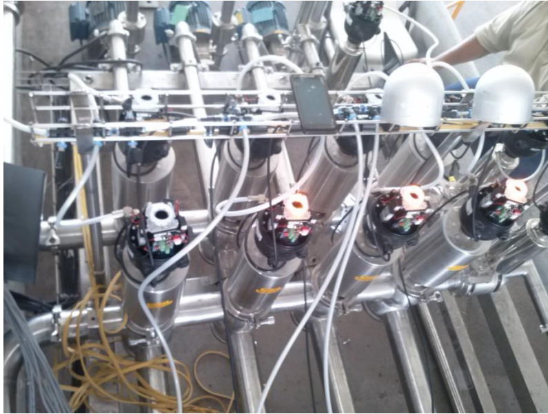
Fig.3.117.- Conexión de aire del cabezal de válvulas
