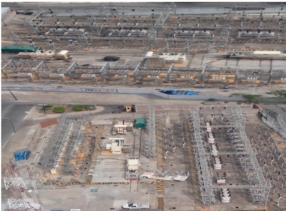
Fig. 3.3 patrullaje a subestación TXS. Y TGU. Respectivamente de manera aérea.
