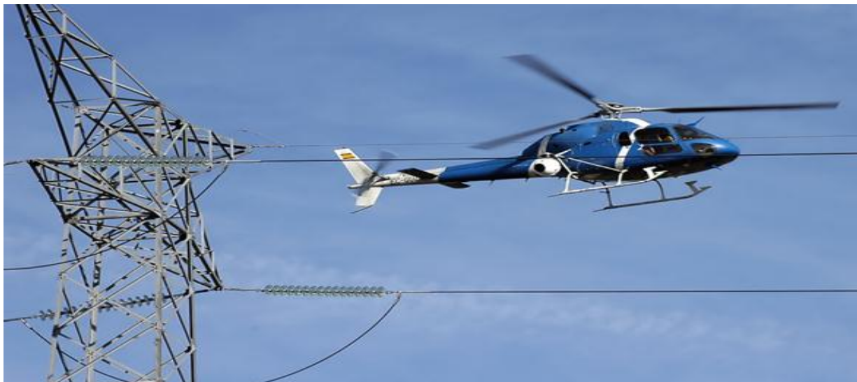
Fig. 3.9 inspección aérea efectiva para detectar aislamientos rotos o en mal estado.
