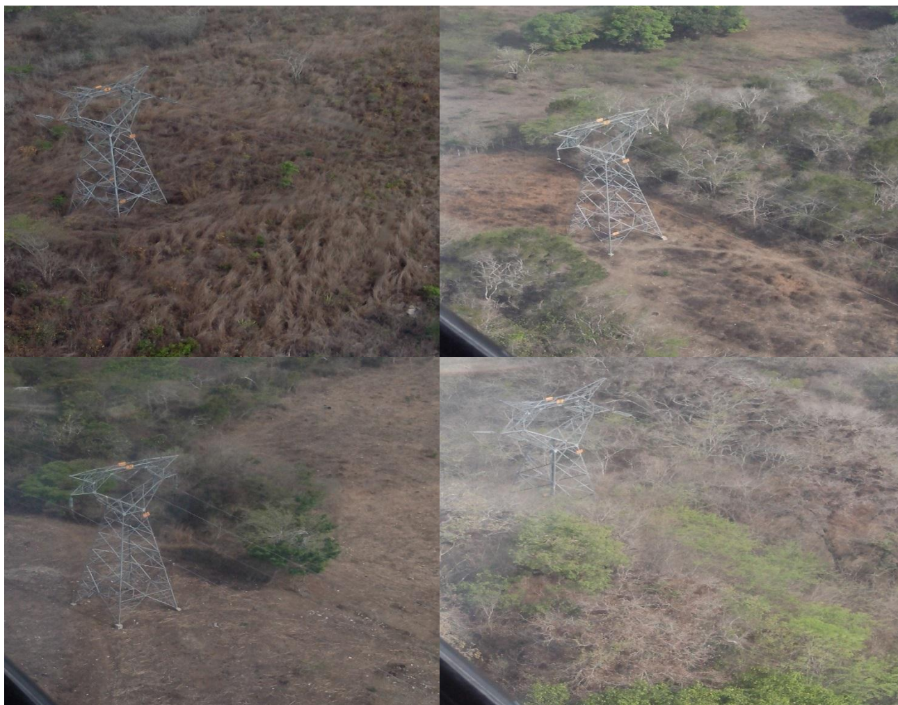
Fig. 3.2 Líneas de subtransmisión 73450 (CIT- ARR). Inspección aérea.
