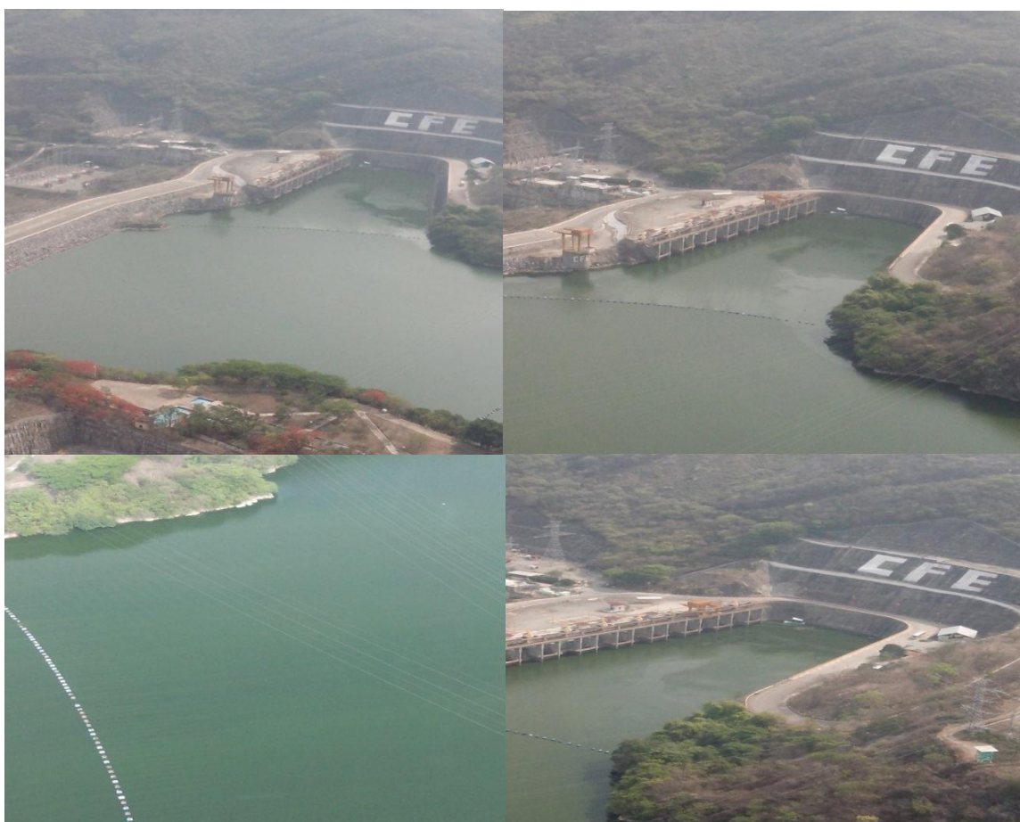
Fig. 3.4 presa hidroeléctrica de chicoasen, donde se alimentan las líneas de zona Tuxtla.
