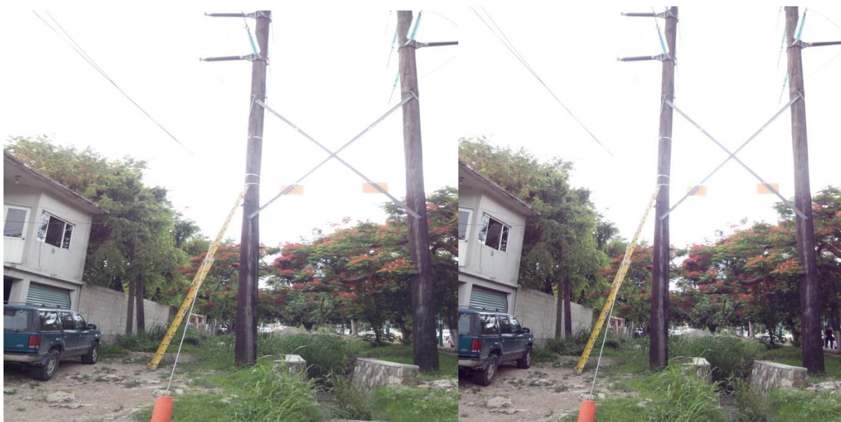
FIG 3.6 Maniobras en línea viva realizados por linieros de CFE.
