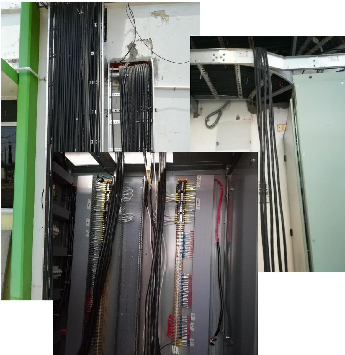
*Figura 37. Cableado de Caseta*
