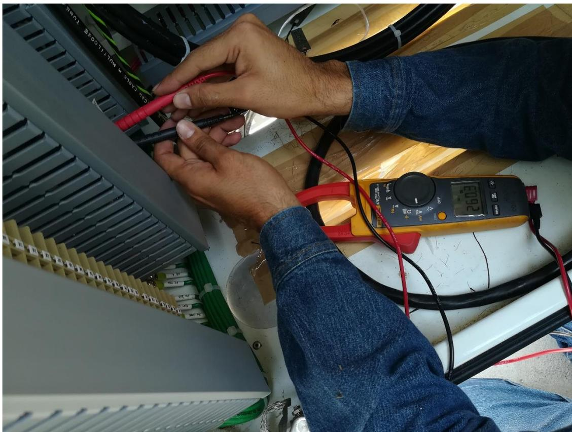
*Figura 39. Recepción de voltaje en tablero de control*
