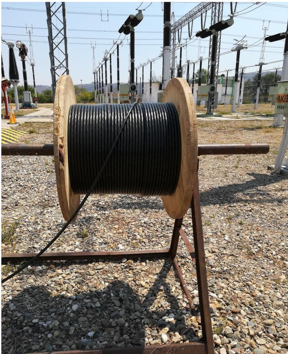
*Figura 33. Carrete de cable de señales*
