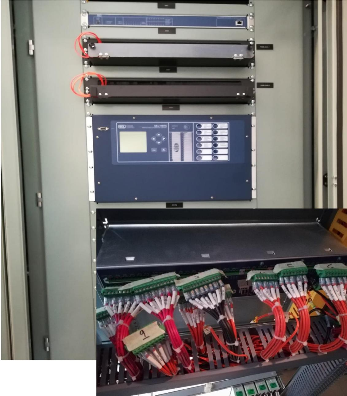
Figura 38. Cableado para el relé SEL-487E
