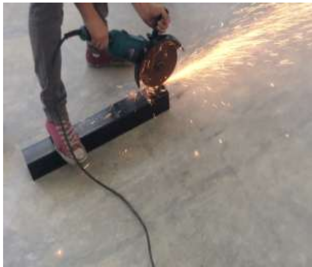
Fig 4.2.2 Elaboración de la estructura
