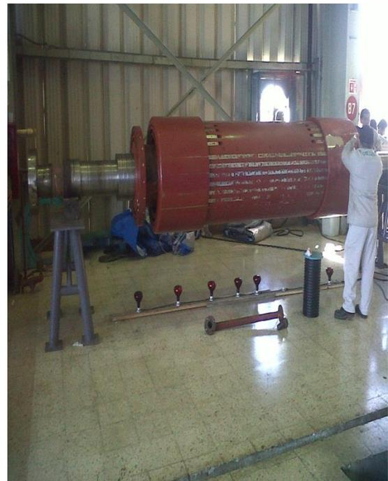
DESMONTAJE DEL ROTOR
