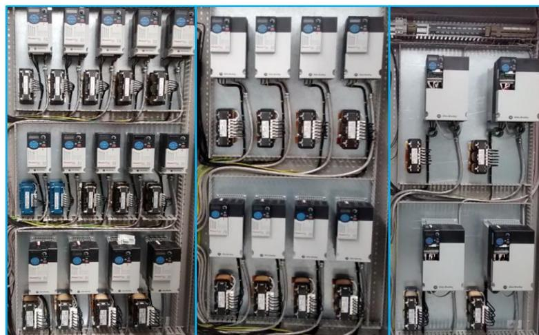
**Fig. 3.9** Montaje de variadores de frecuencia y reactor de línea.
