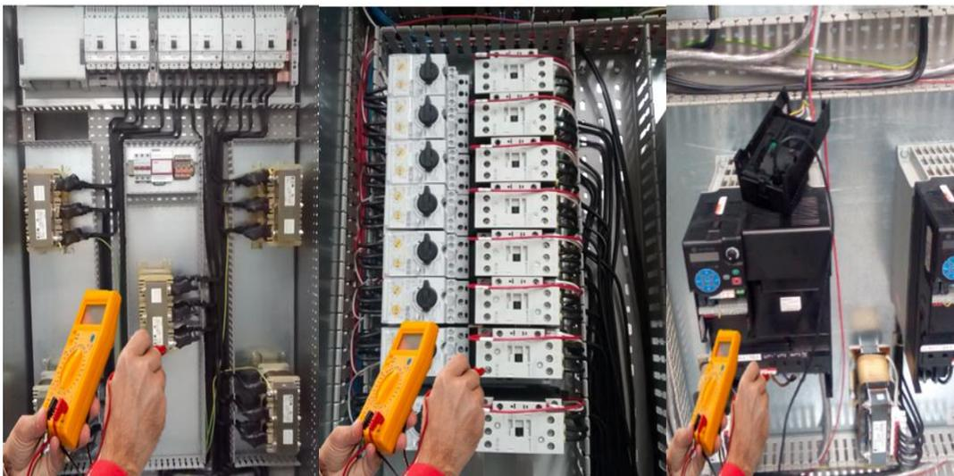
*Fig. 3.14* Prueba de voltaje en CCM.
