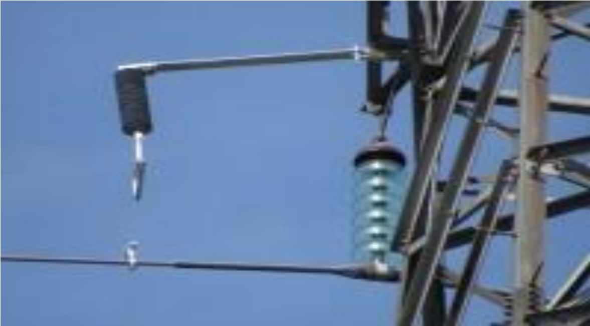
FIG. 27 MONTURA DEL APARTARRAYO TIPO ALEA EN LST IPD-VFD
