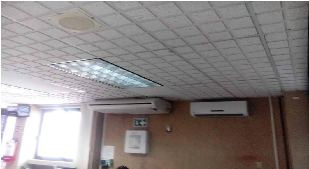
Fig.3.3 Lámpara fluorescente de 2 tubos de 35 watts, con difusor tipo rejilla y reflector convencional.
