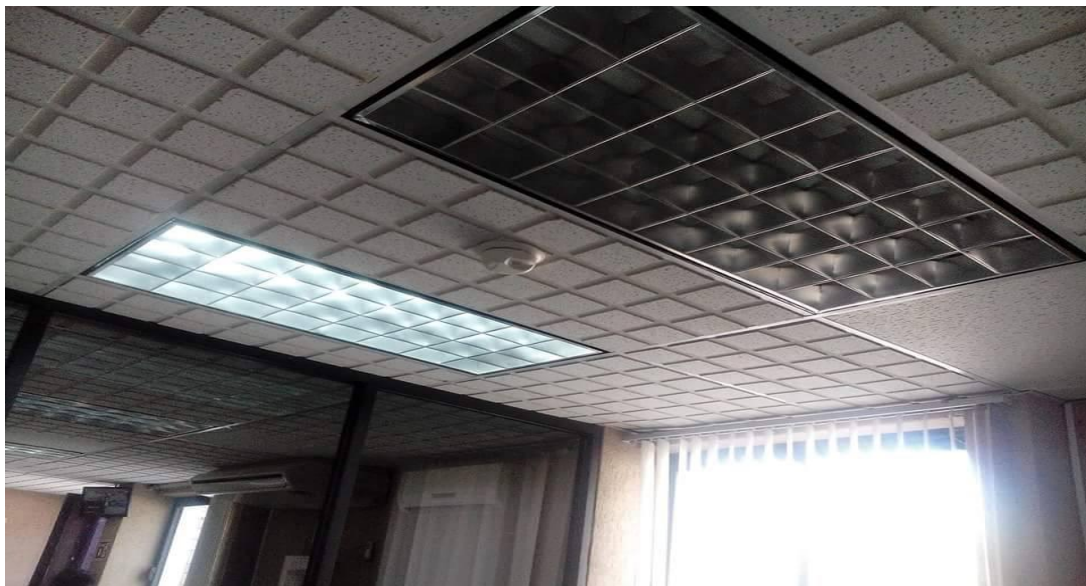
Fig.3.2 Lámpara fluorescente de 2 tubos de 35 watts, con difusor tipo rejilla y reflector convencional.
