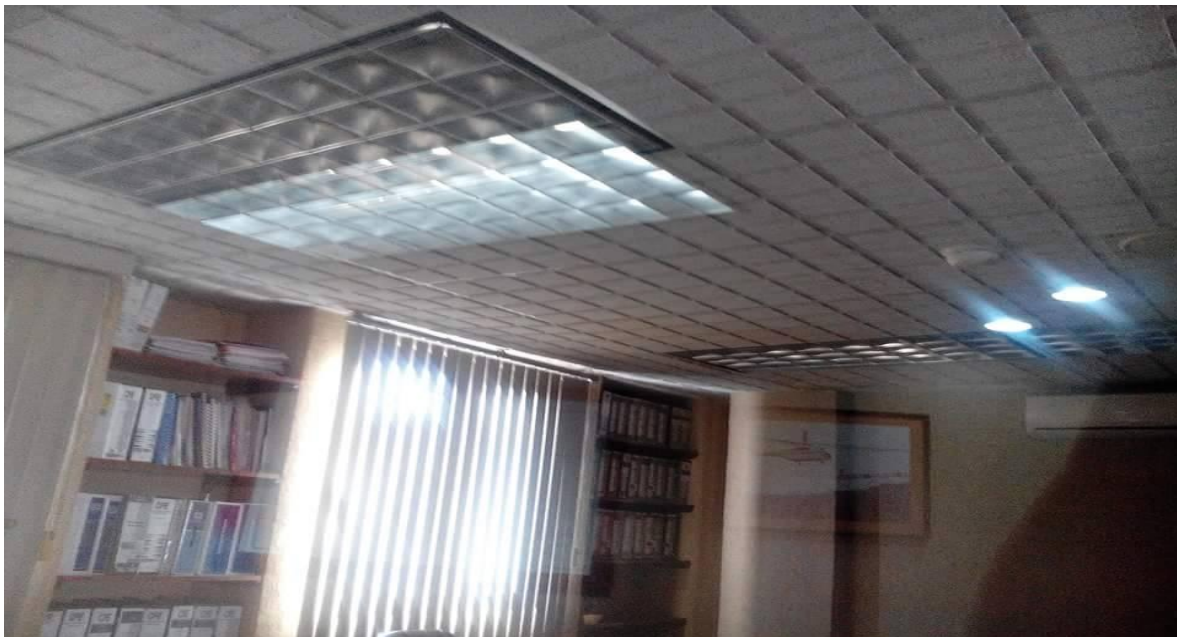
Fig.3.3 Lámpara fluorescente de 2 tubos de 35 watts, con difusor tipo rejilla y reflector convencional.
