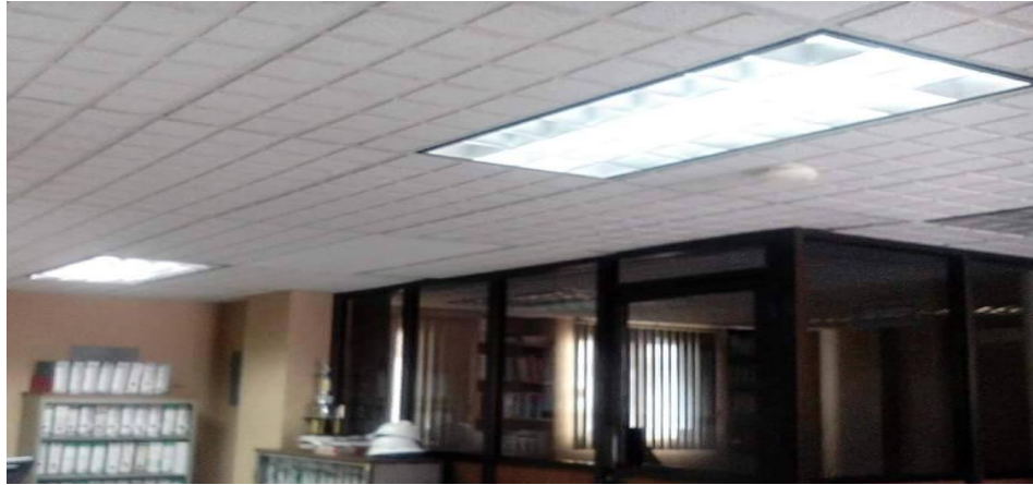
Fig.3.1 Lámpara fluorescente de 2 tubos de 35 watts, con difusor tipo rejilla y reflector convencional.
