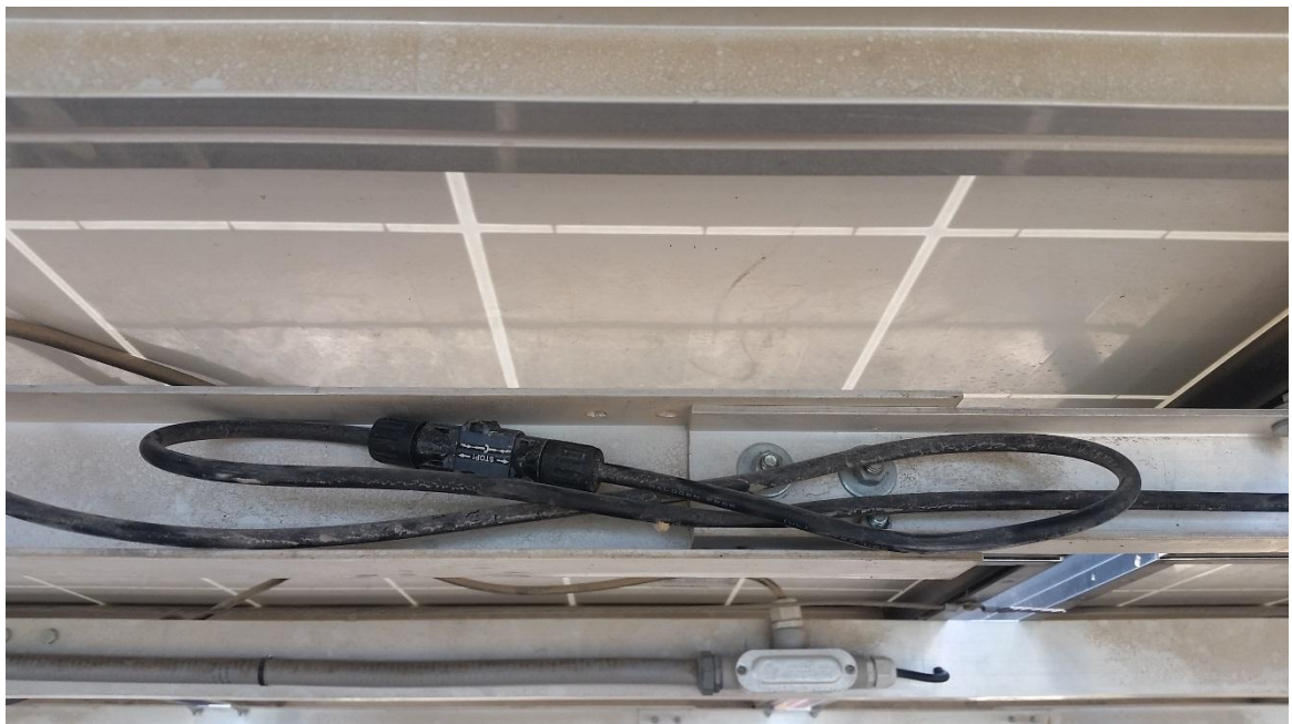
Figura 4.5 Interconexión de los paneles solares
