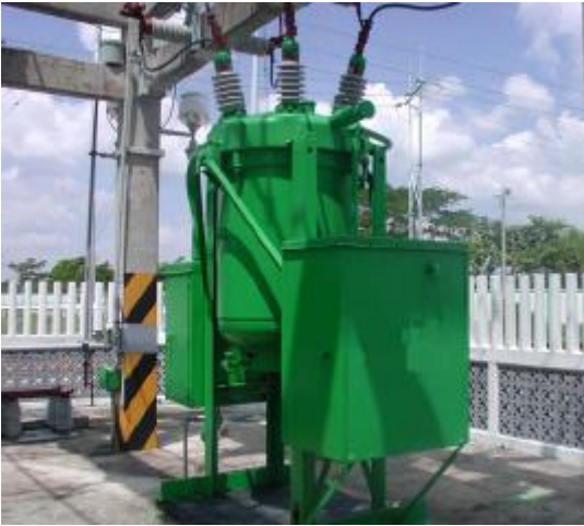
Interruptor trifásico en gran volumen de aceite con un solo tanque clase 34.5 kV.
