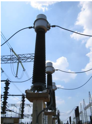
TRANSFORMADOR DE CORRIENTE (TC) 400 KV
