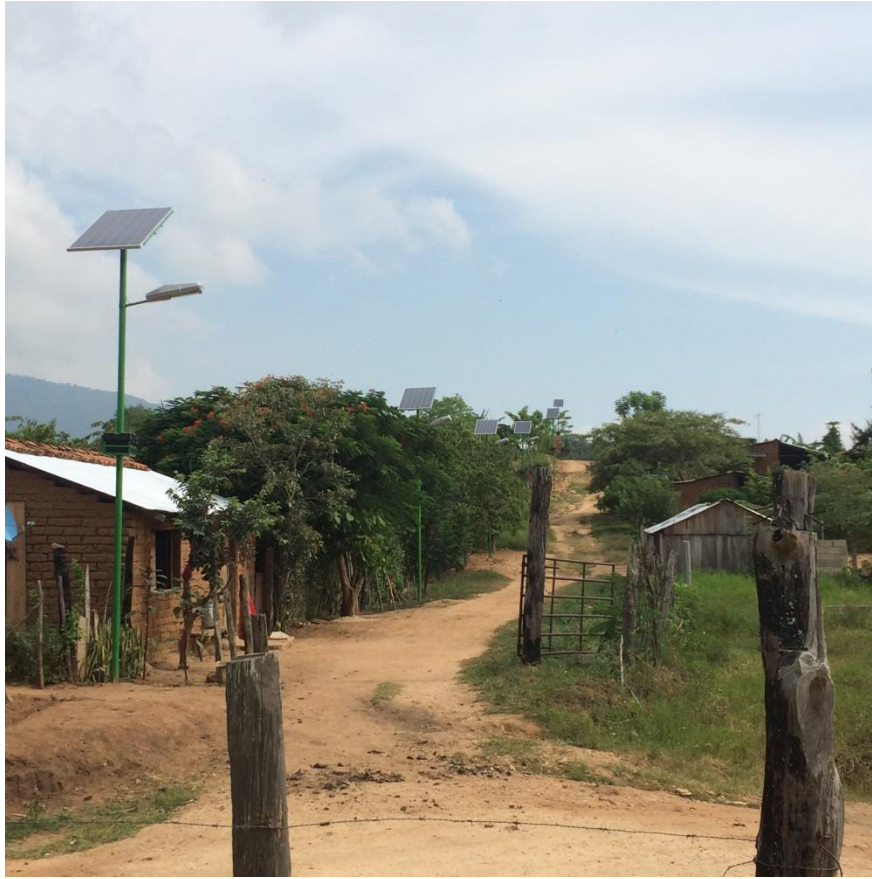
Fig.Anexo.B5 Sistema de iluminación Fotovoltaica en la actualidad, 2015.
