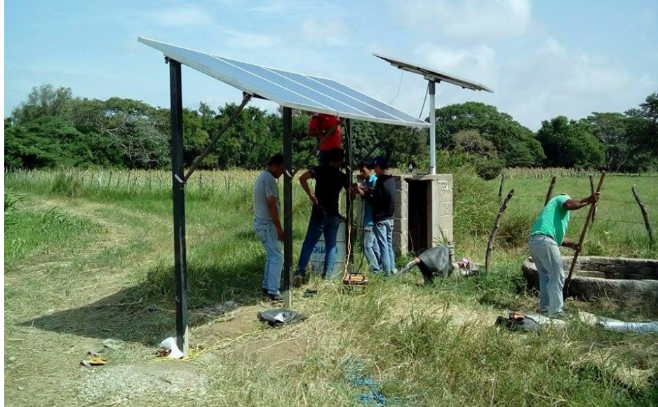
Fig.4.14 Instalación del Sistema de Bombeo Fotovoltaico –Cintalapa.
