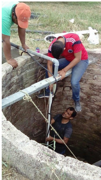
Fig.4.15 Instalación de la Bomba Solar Fotovoltaica –Cintalapa.
