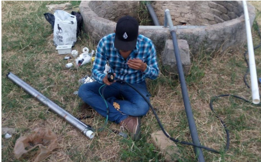
Fig. 4.2 Bomba Grundfos SQflex Bomba de rotor helicoidal MSF 3 versión estándar fabricada en acero inoxidable DIN W.-Nr. 1.4301.
