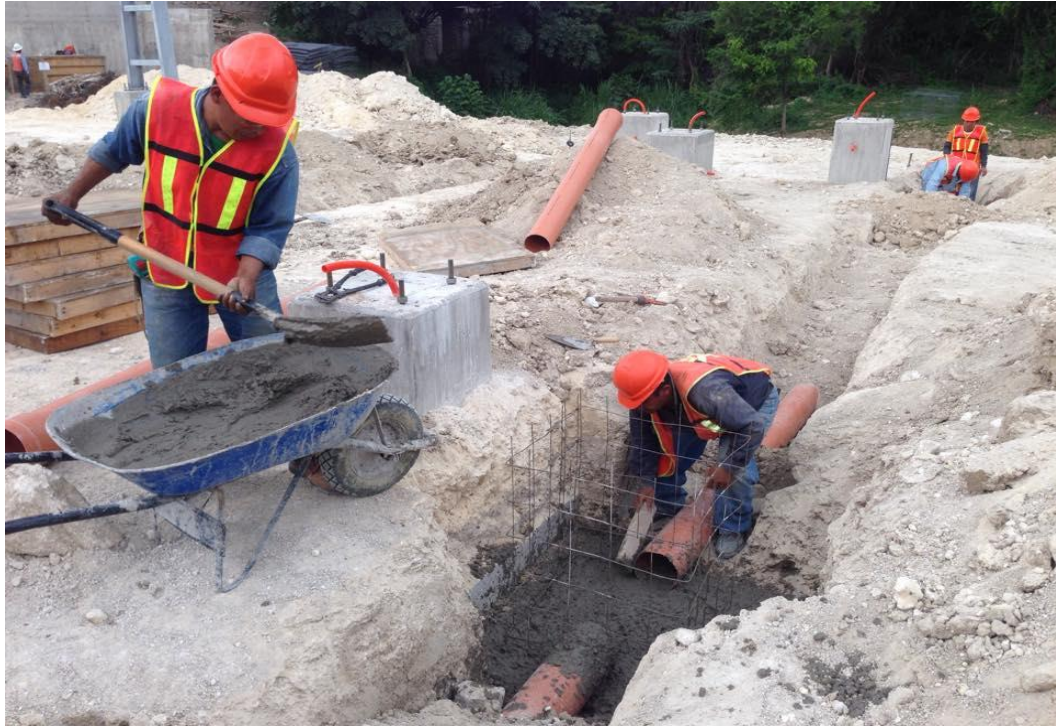
Fig.7.9 Excavación y colado de plantillas para los registros pluviales.
