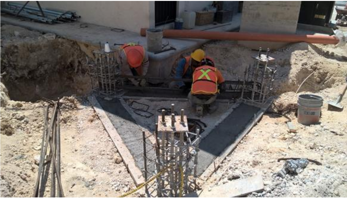
Fig. 7.25 Armado de soportes tubulares y colados de plantilla de la zapata de la torre de comunicación
