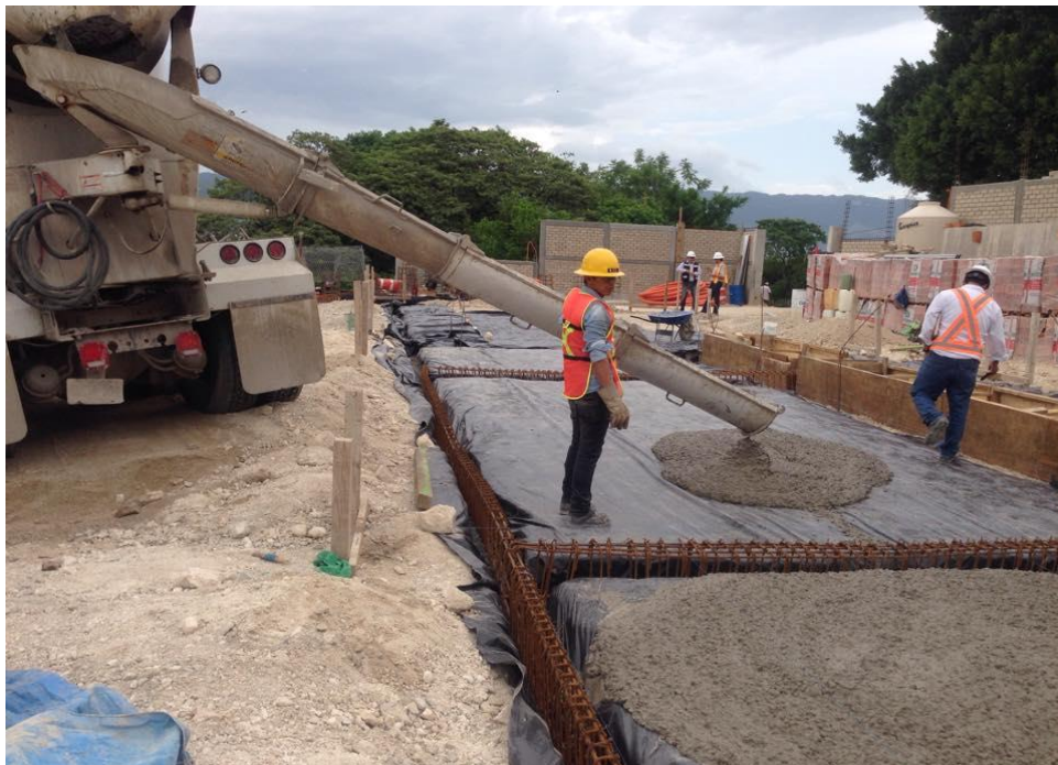
Fig. 7.4 Colado de la plantilla de la Caseta de Control.
