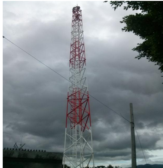
Fig. 4.13 Montaje de antenas de comunicación
