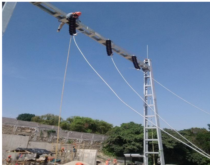
Fig. 4.2 Colocación de bus flexible
