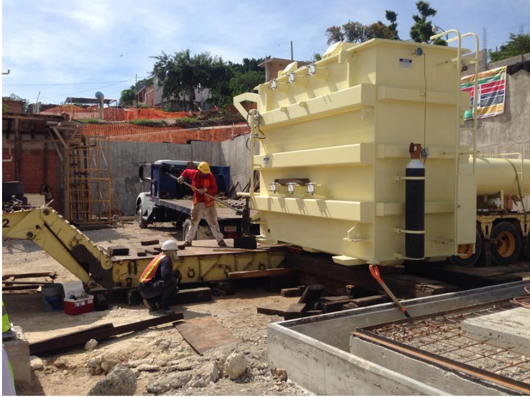
Fig. 7.18 Montaje y colocación del transformador en su base.
