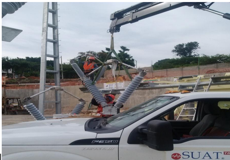
Fig. 4.7 Montaje de cuchillas seccionadoras
