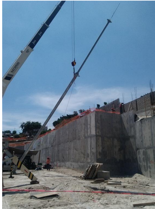
Fig. 4.5 Montaje punta pararrayos
