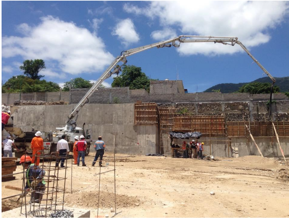
Fig. 7.3 Colando una parte del muro de contención.
