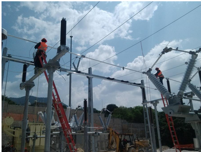
Fig. 4.3 Colocación de bus rígido
