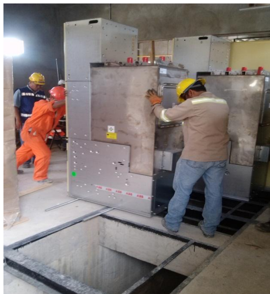
Fig. 4.6 Montaje de tableros Metal-Clad
