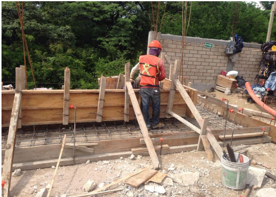
Fig. 7.14 Armado de varilla y cimbra de base de la barda perimetral.
