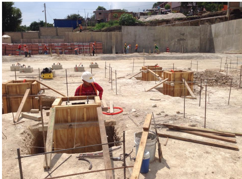
Fig. 7.2 Ubicación v trazado de soportes tubulares.
