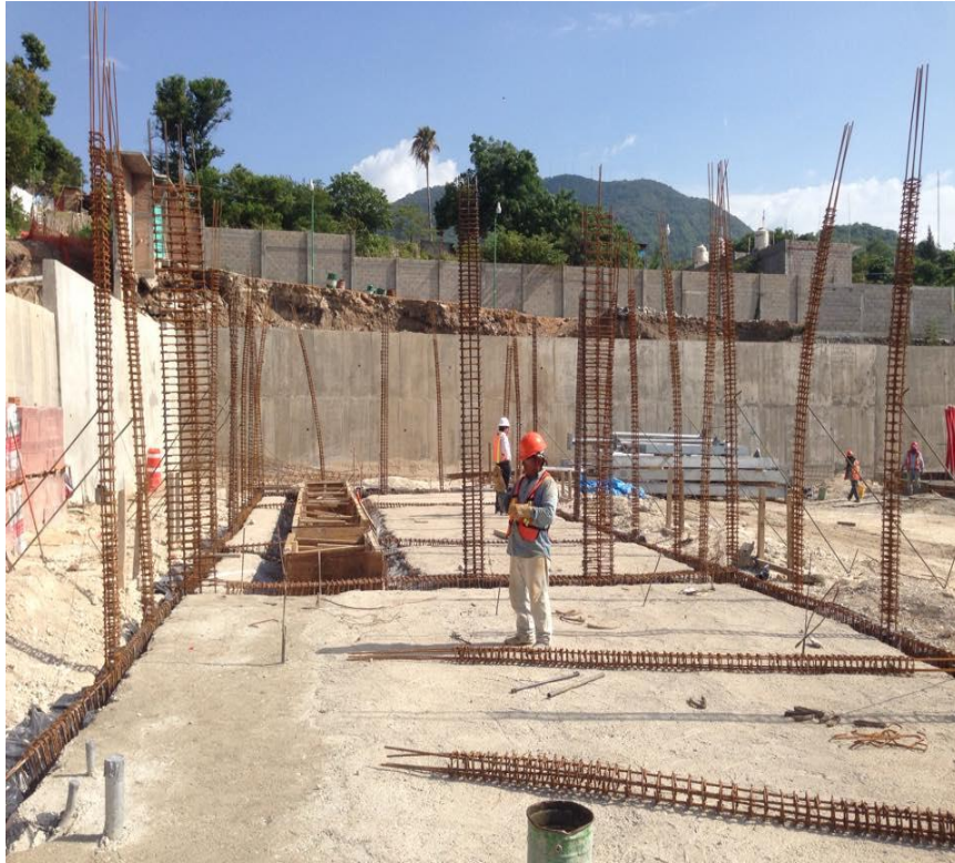
Fig. 7.5 Armado de castillos, traveses y cadenas, de la caseta de control
