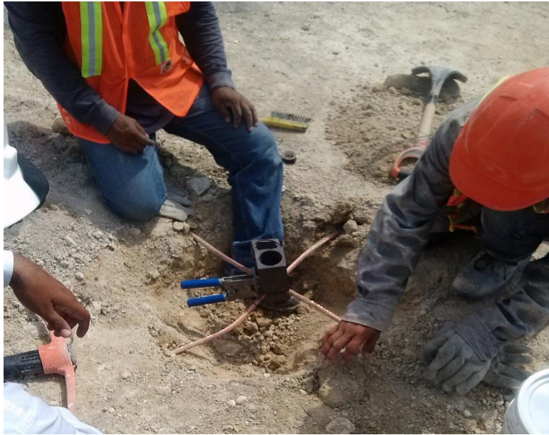
Fig. 4.4 Soldadura en el sistema de tierras
