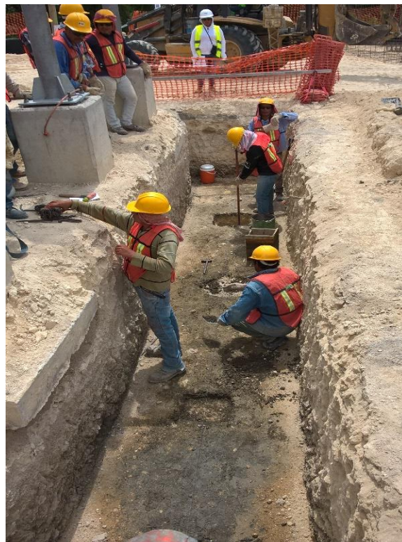
Fig. 7.21 Excavación y compactación de la trinchera donde llegara los cables de alta tensión.
