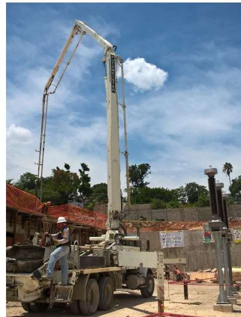
Fig. 7.19 Armado, Cimbrado y colado de la loza de la caseta de control.
