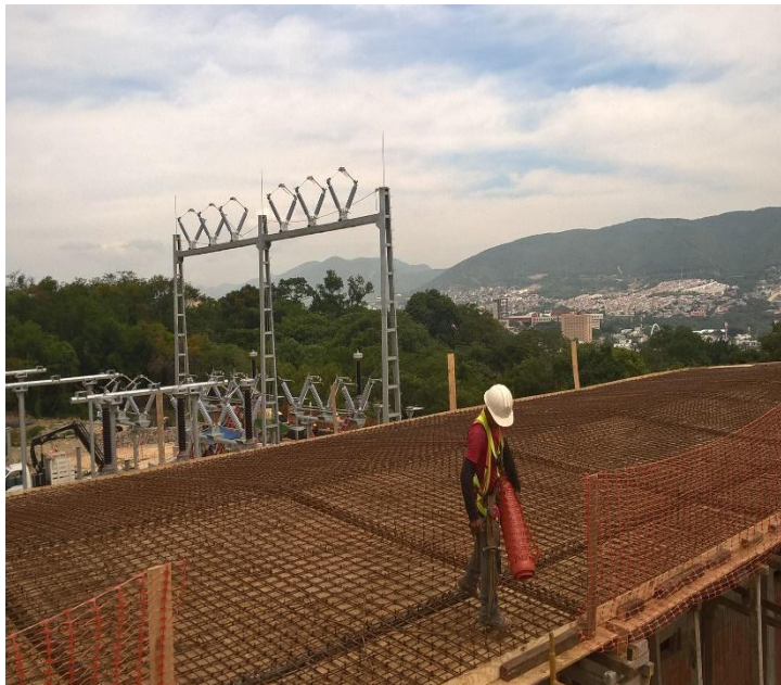
Fig. 7.19 Armado, Cimbrado y colado de la loza de la caseta de control.
