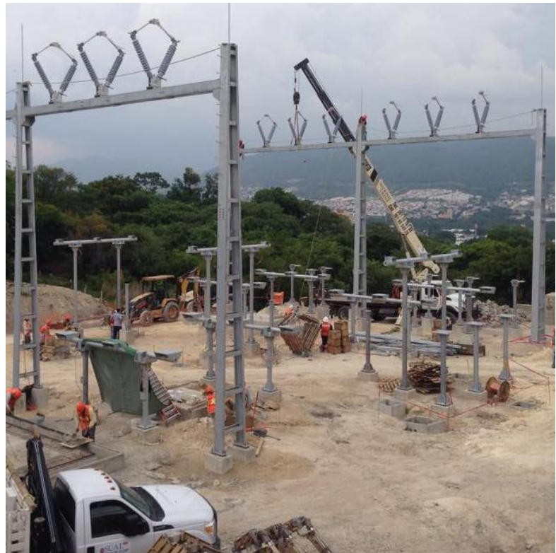
Fig. 7.16 y 7.17 Montaje de cuchillas desconectoras en la estructuras de las perchas.
