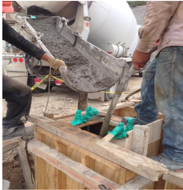
Fig. 7.7 Cimbrado y colado de los soportes tubulares.
