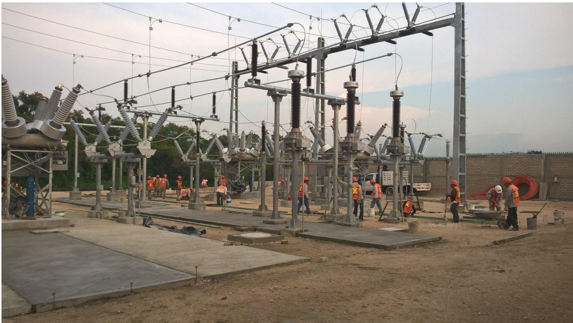
Fig. 7.23 Colado de piso de concreto, por placas o secciones.
