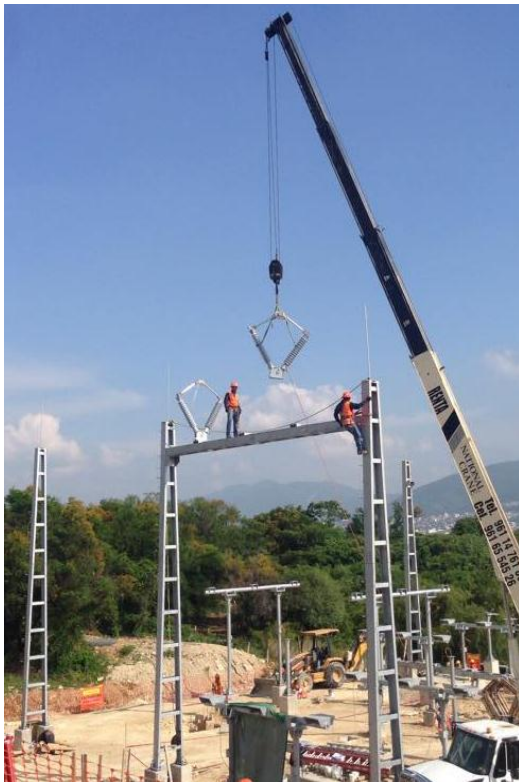
Fig. 7.16 y 7.17 Montaje de cuchillas desconectoras en la estructuras de las perchas.
