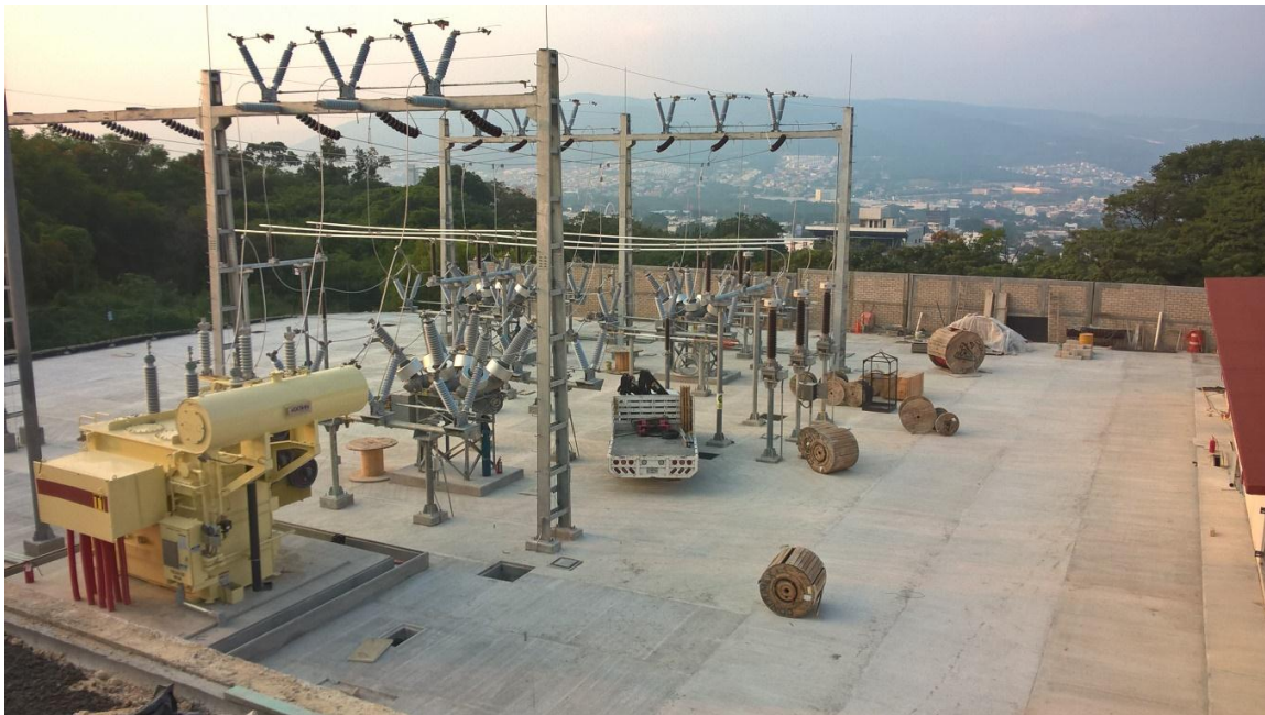
Fig. 7.26 Piso de concreto de la subestación concluido.
