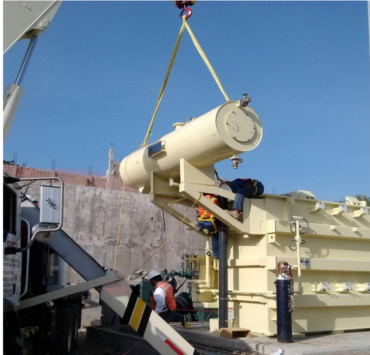
Fig. 4.8 Montaje de tanque de aceite del transformador
