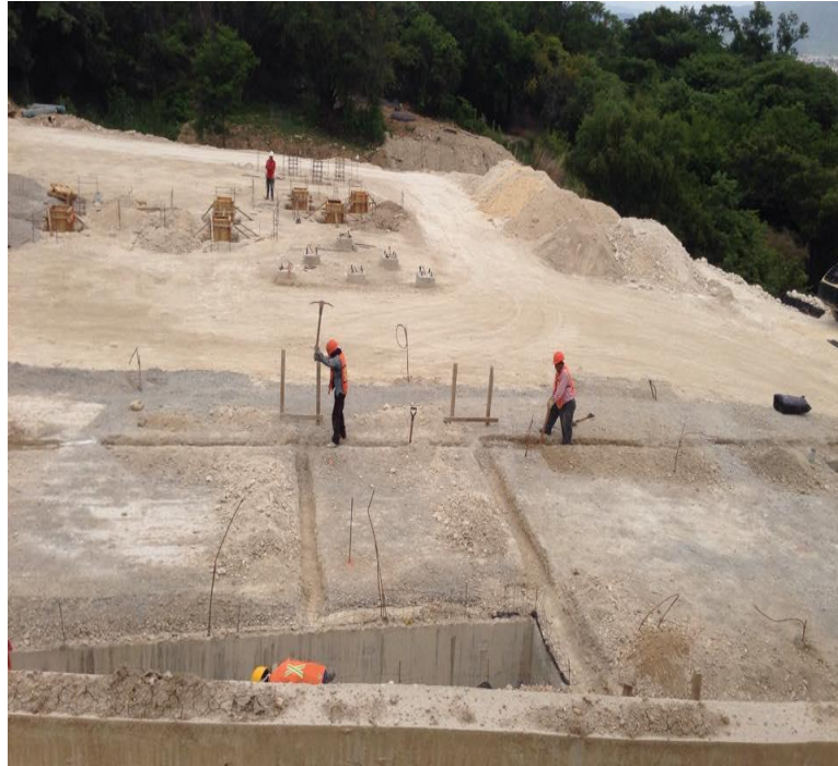
Fig. 7.1 Relleno y compactación del terreno
