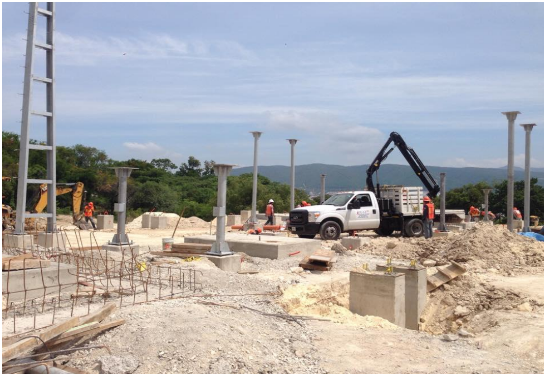
Fig. 7.10 Montaje y armado de estructuras en los soportes tubulares.
