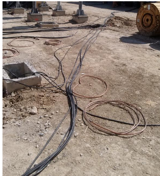
Fig. 4.12 Tendido de cables por ductos y trincheras
