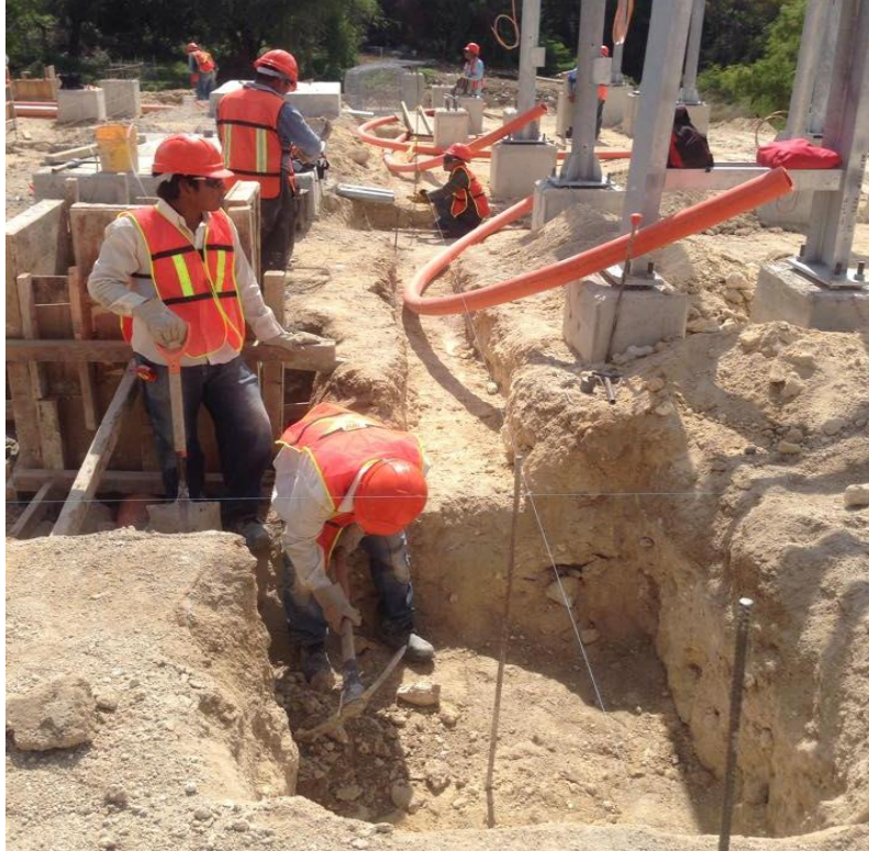
Fig.7.12 Excavación para los ductos de los registros eléctricos.
