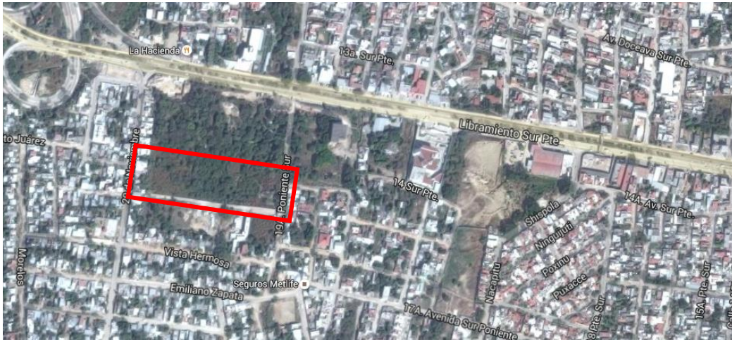
Fig. 2.3 Vista aérea vía satélite de la subestación
