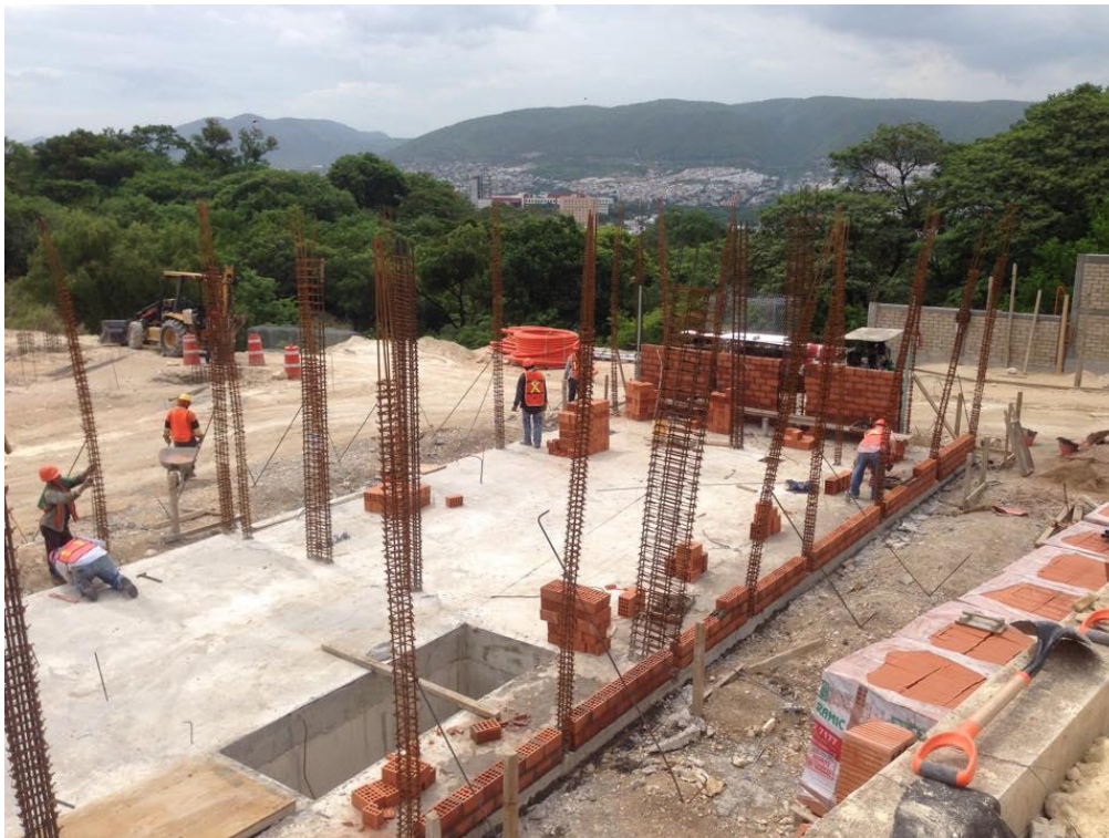
Fig. 7.6 Pegado del tabimax, paredes de la caseta de control.
