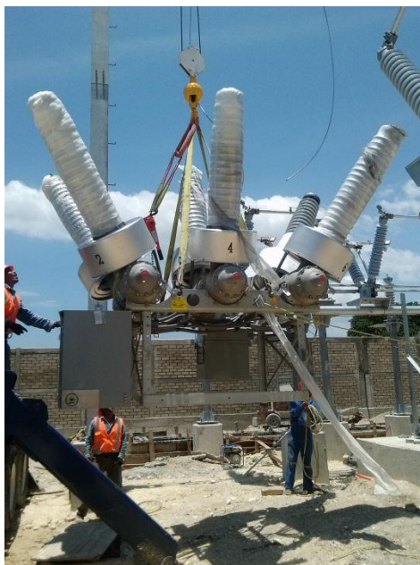
Fig. 4.9 Montaje de interruptor de potencia
