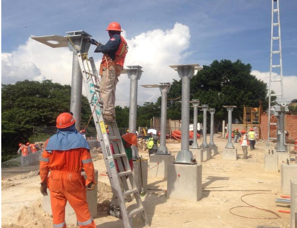
Fig. 7.11 Colocación de la tierra física en las estructuras.
