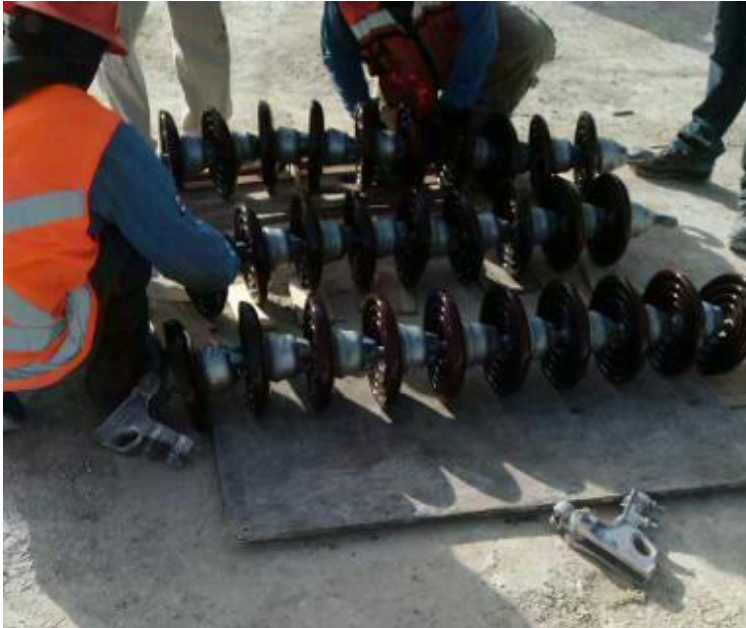
Fig. 4.1 Armado de aisladores
