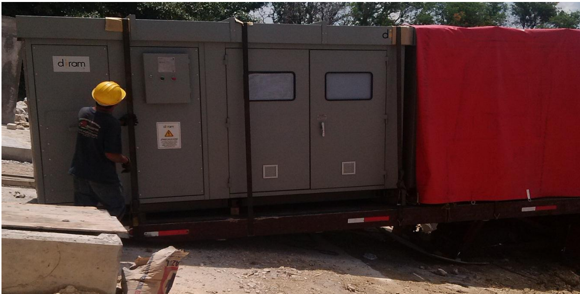
Fig. 4.14 Montaje de banco de capacitores
