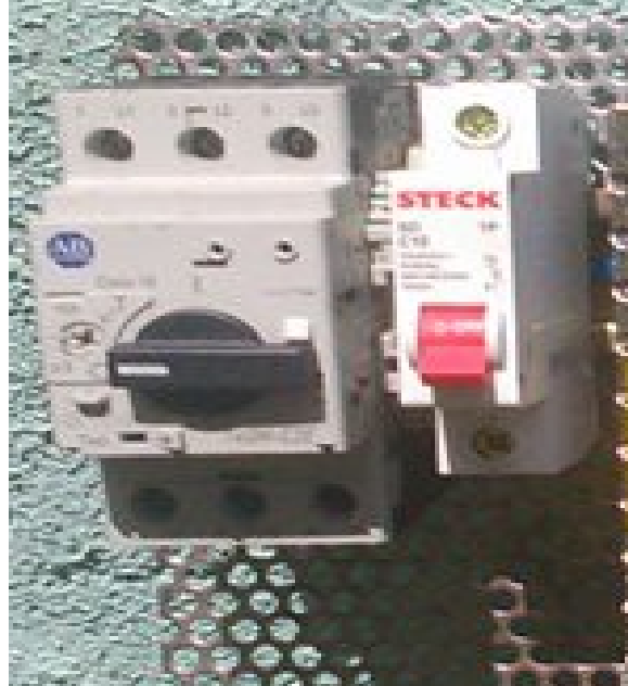
Fig. 3.6 Montaje de las protecciones
