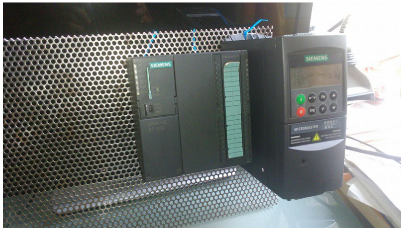
Fig. 3.3 Montaje del PLC S7 300.
