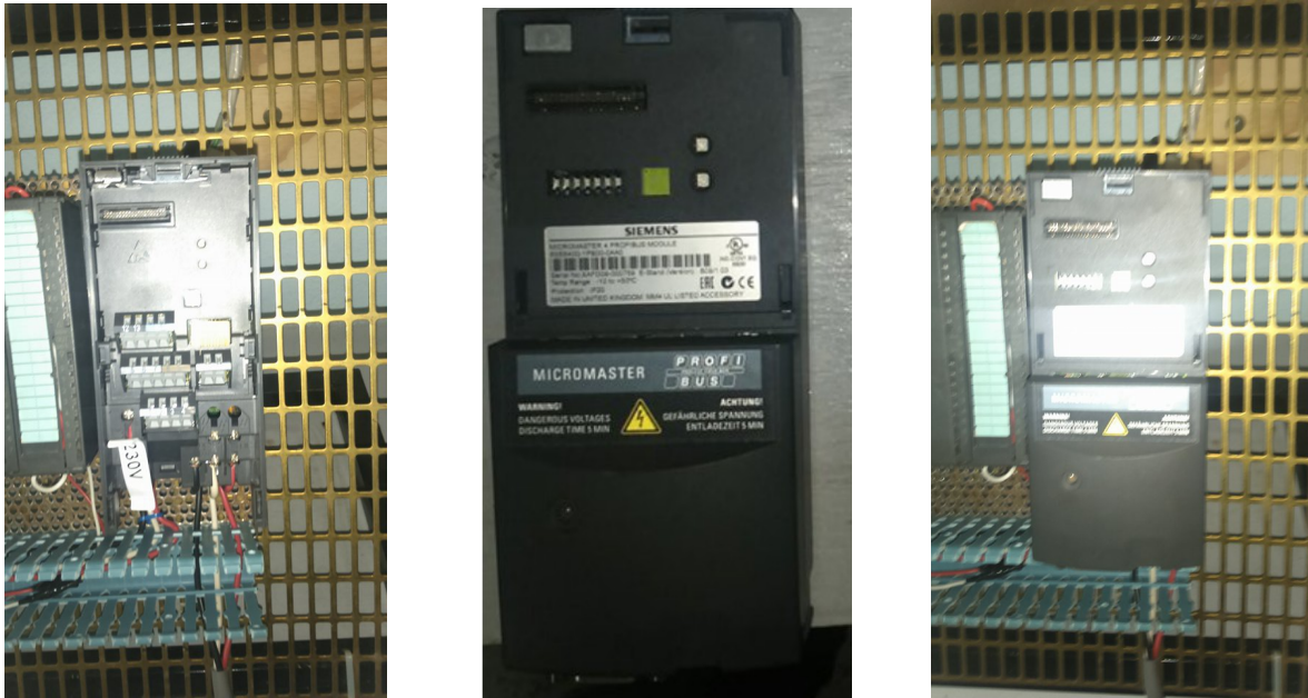
Fig. 3.14 Montaje del panel de comunicaciones Profibus
