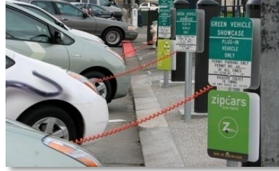
Fig.1.7 Recarga de un Vehículo Eléctrico de CA.
