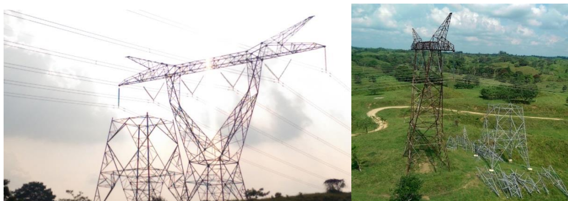
Fig. 5.6 Armado de patas y parte de cuerpo piramidal antes de libranza.
