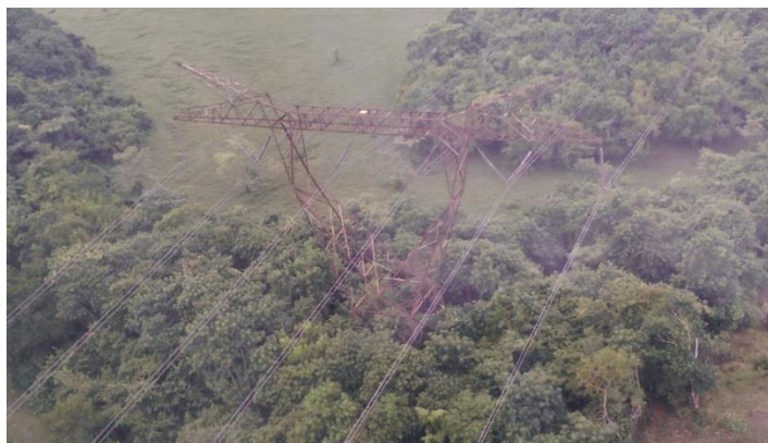
Fig. 3.15 Estructura en zona problemática.
