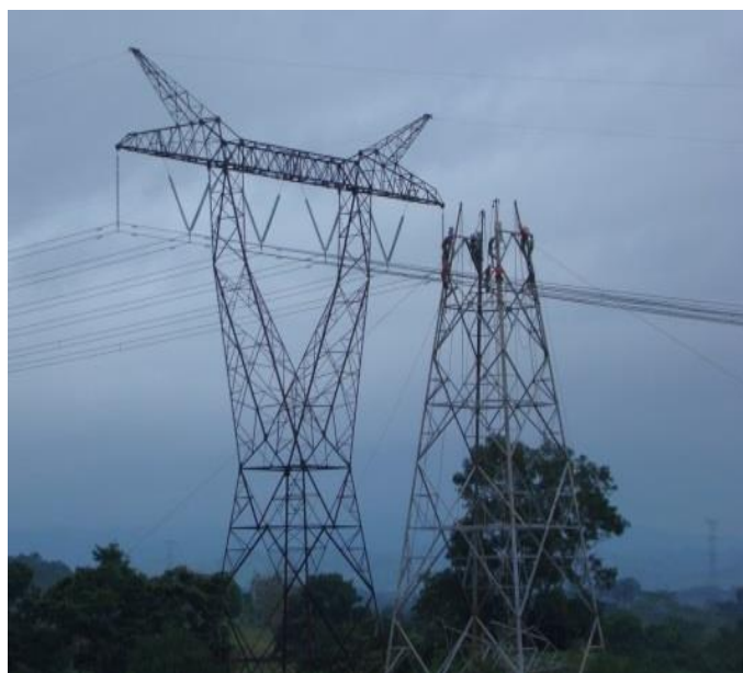
Fig. 5.7 Aterrizamiento y montaje de las torres.
