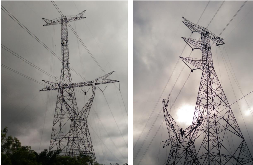
Fig. 5.8 Montaje y vestido de estructura (K9)
