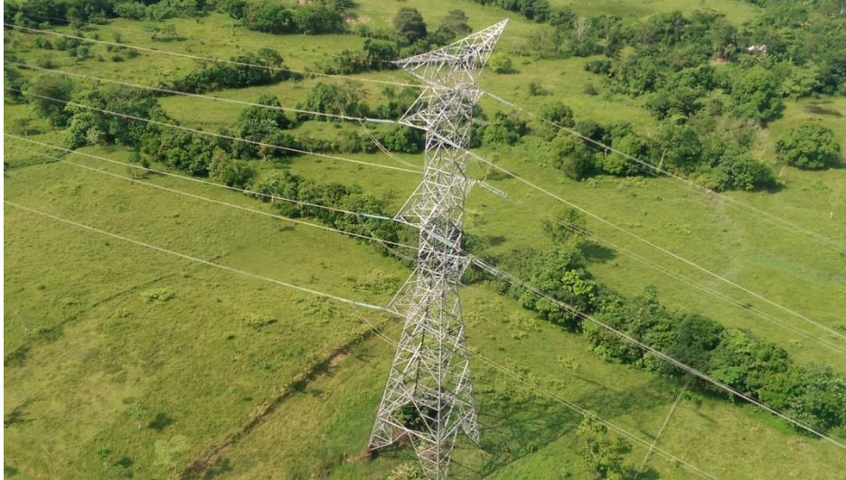
Fig. 5.11 Sustitución de estructura concluida (KC).
