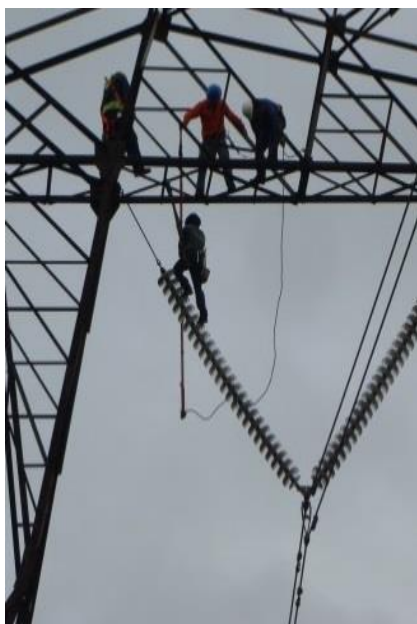
Fig. 5.7 Aterrizamiento y montaje de las torres.
