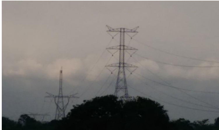
Fig. 5.9 Estructura completamente montada y vestida
