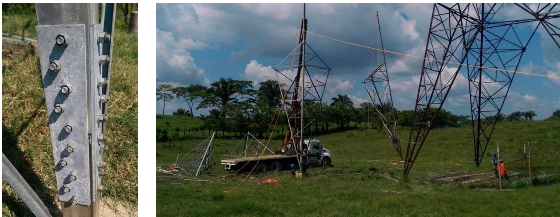
Fig. 5.5 Armado de patas con placas y tornillería.
