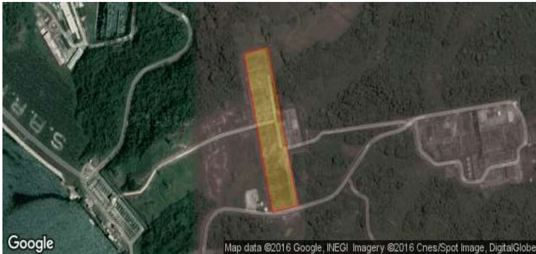
Figura 1. Subestación Malpaso Uno
