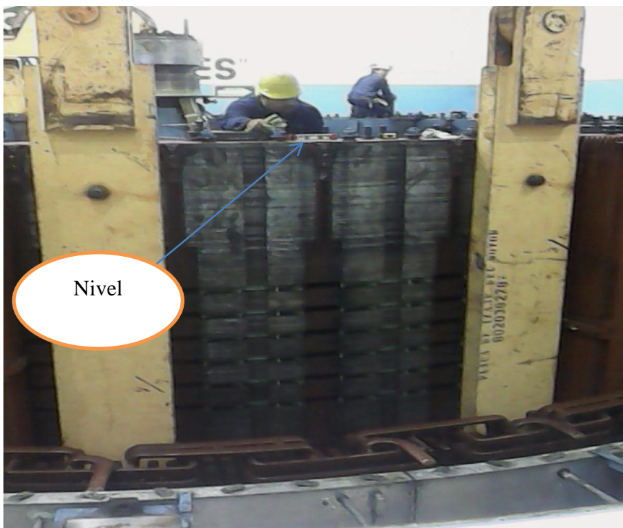
Fig. 3.17 nivel del rotor para no dañar el estator
