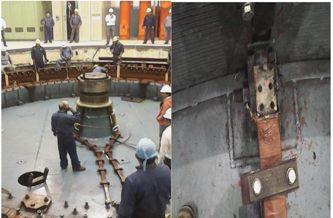
Fig.3.12 salida de barras de excitación hacia devanado de campo
