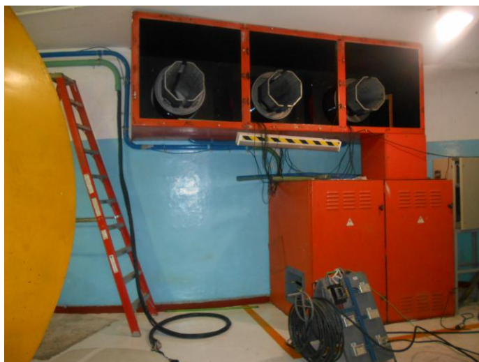
Figura 3.3 transformador neutro de generador
