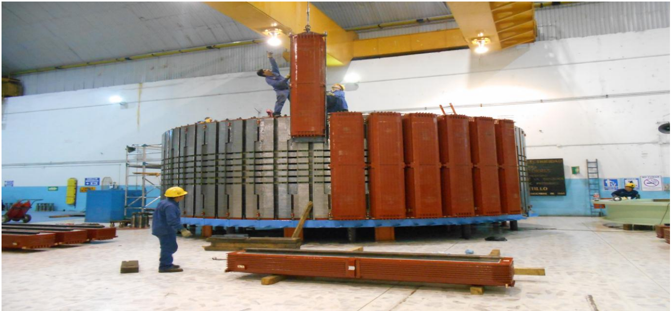
Fig. 3.45 montaje de polos
