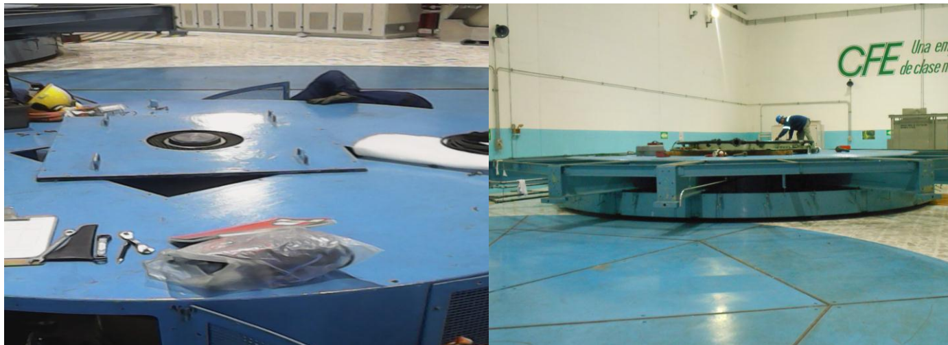
Fig.3.6 Retiro de tapas antiderrapantes y araña soporte guía superior
