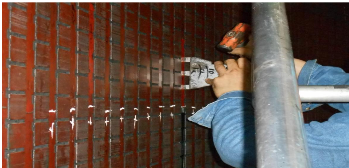
Fig.3.34 Extracción de cuñas
