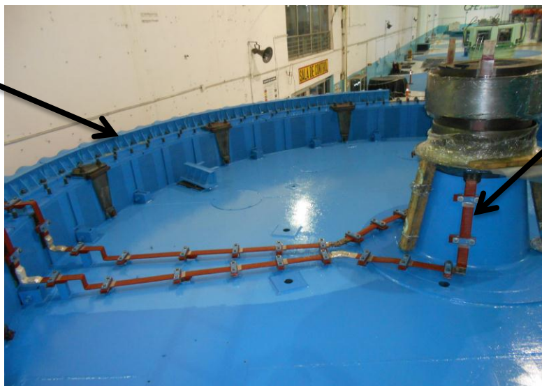
fig.3.41 rotor limpio
