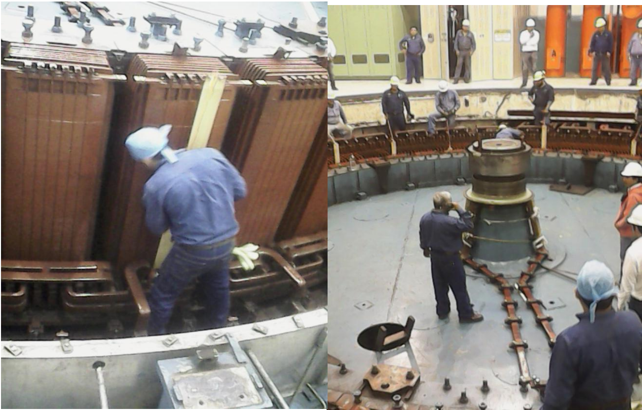
Fig.3.14 se deslizan las tablas entre el rotor y estator
