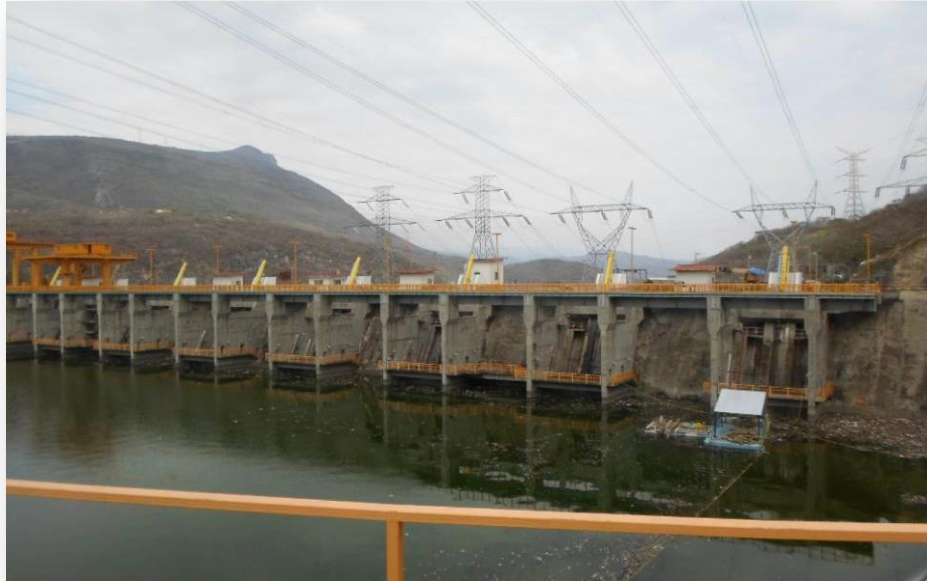
Fig.1.1. obra de toma
