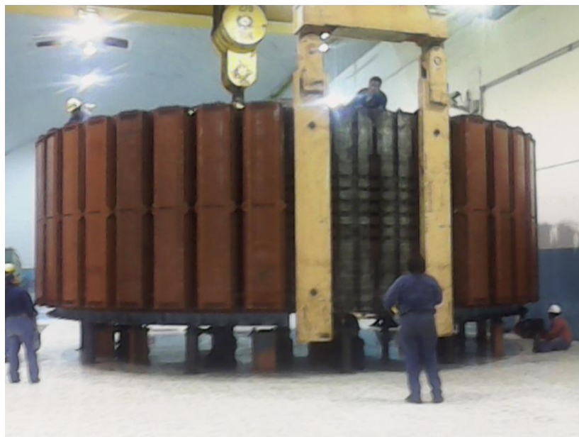
Fig.3.16 acoplamiento del rotor en soporte
