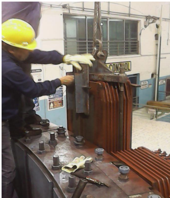
Fig.3.20 colocación de placa de fijación
