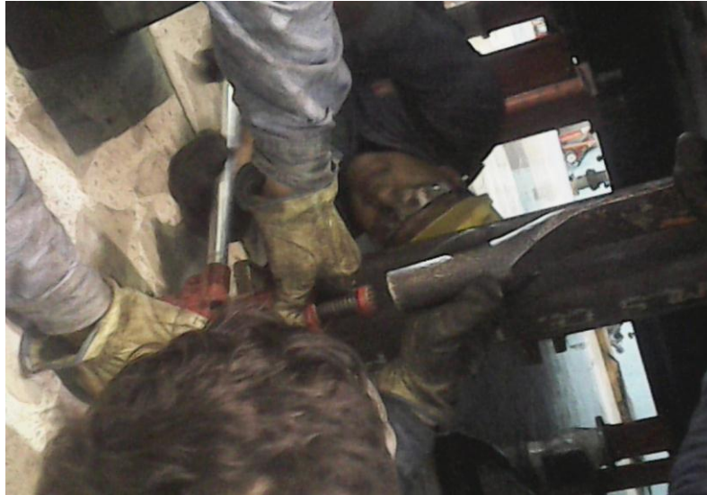
Fig.3.19 se calza cuña superior con gato hidráulico
