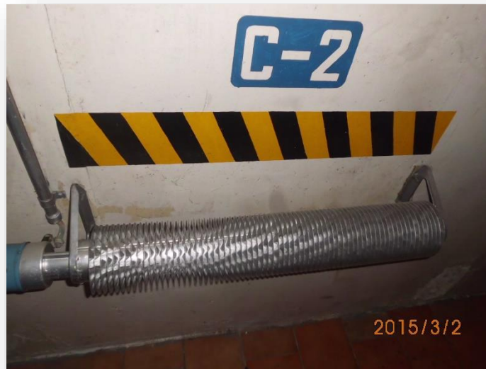
Fig. 3.6 Resistencia Calefactora.
