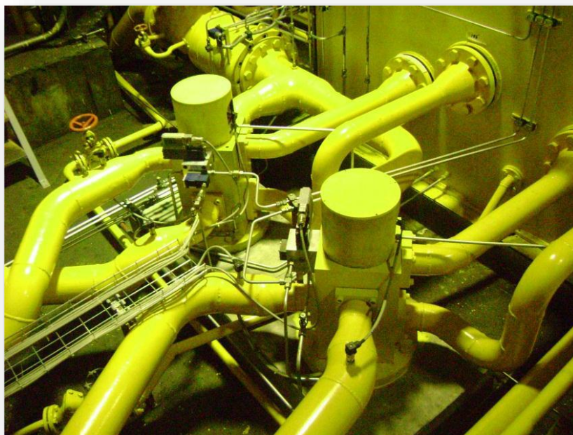
Fig. 3.22 Válvulas distribuidoras 26D y 26R.
