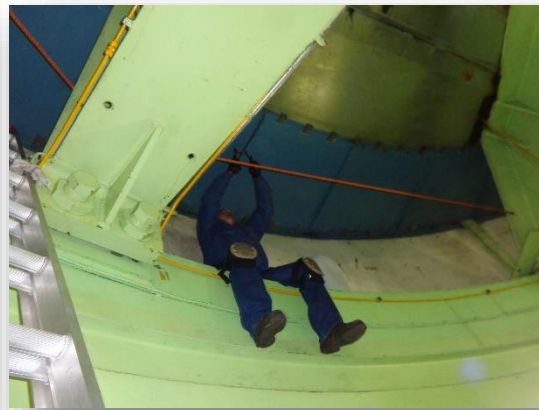
Fig. 3.40 Limpieza a Cabezal inferior del estator.
