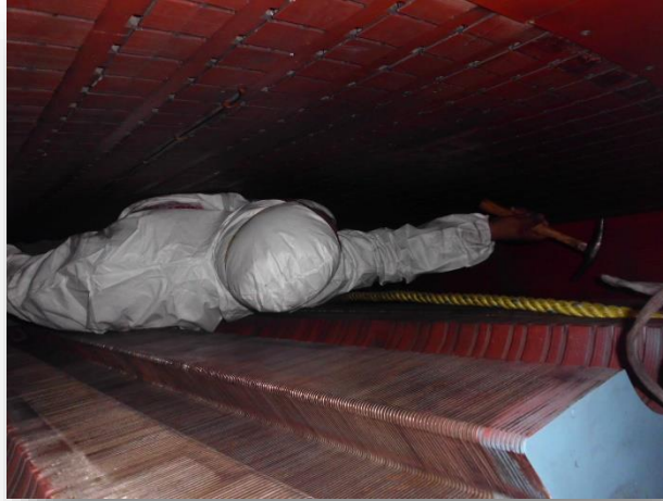
Fig. 3.39 Inspección de las cuñas del estator.
