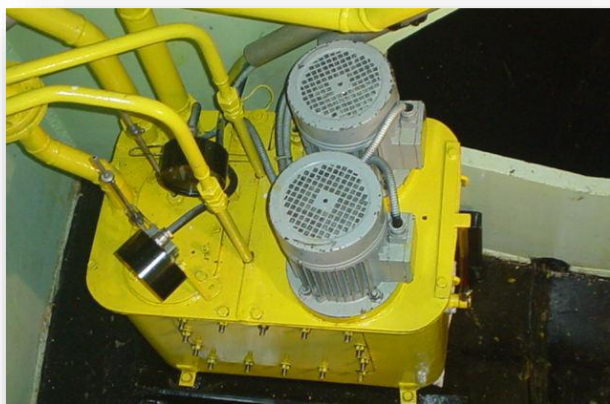
Fig. 3.26 Bombas de aceite infiltrado M-371, M-372.
