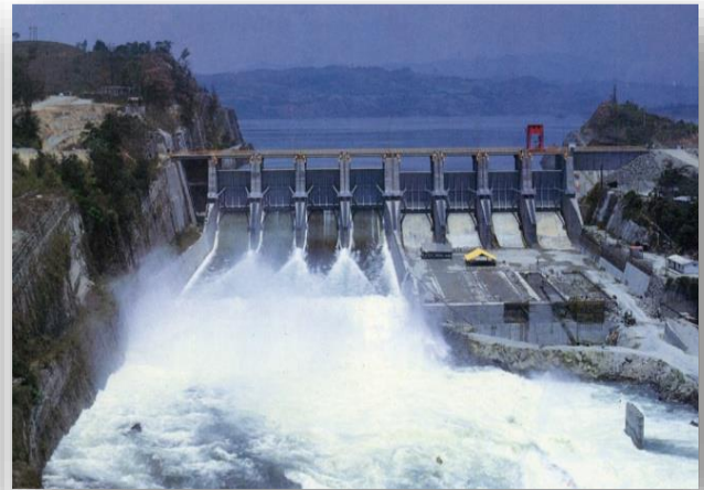
Figura 2.12 Perfil del vertedor de la Presa Peñitas.
