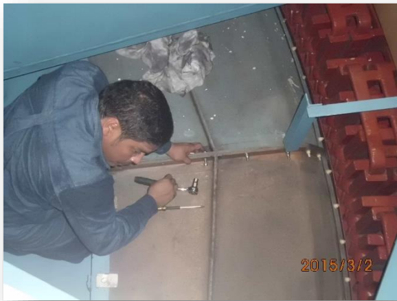
Fig. 3.41 Retiro de tolvas.
