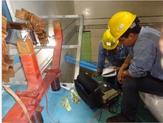
Fig. 3.53 Prueba de R.A al conjunto.
