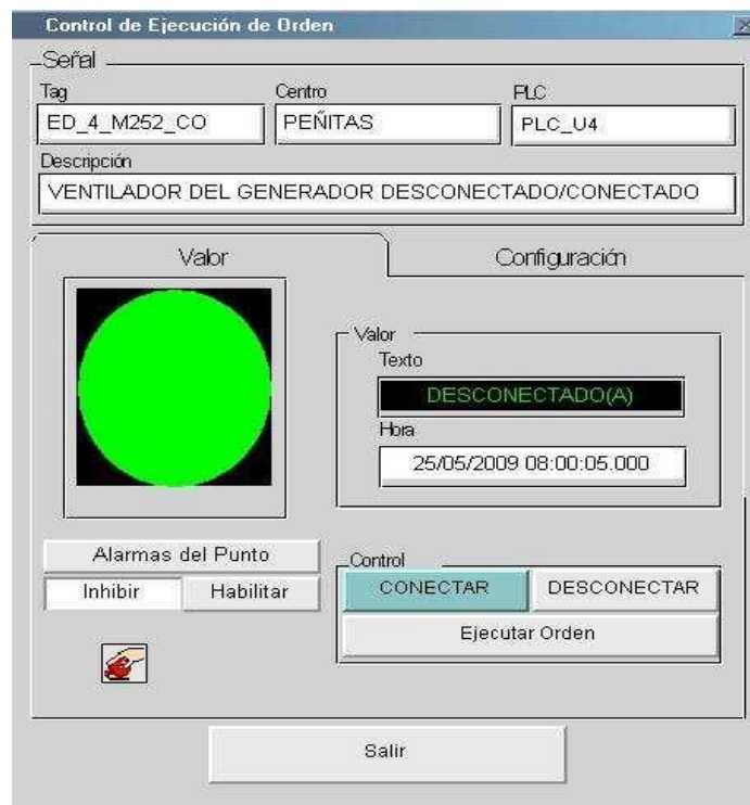
Fig. A2.16 Conectar y desconectar ventilador del generador.
