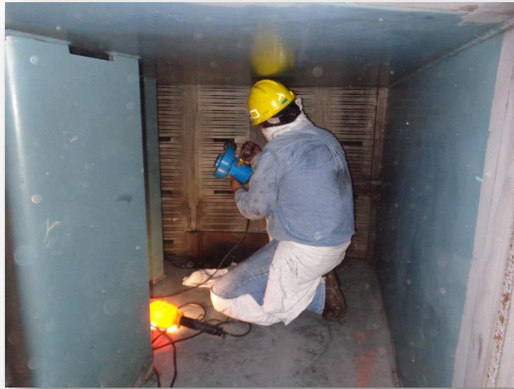
Fig. 3.46 Limpieza de ductos de ventilación.
