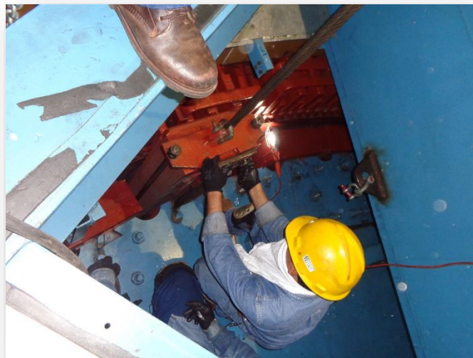
Fig. 3.45 Extracción de polos.
