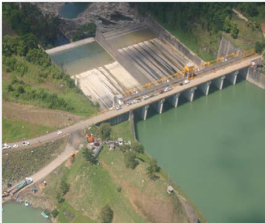
Figura 2.13 (a) Vertedor aguas arriba.
