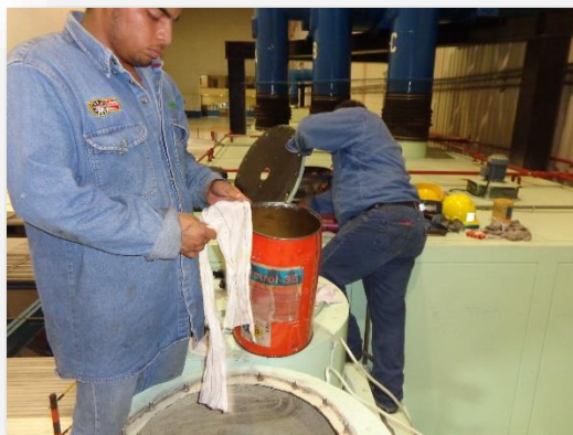
Fig. 3.50 Limpieza y prueba de R.A a los motores de Servicios Propios.
