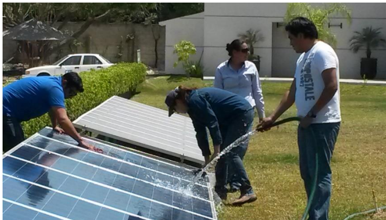
Mantenimiento de módulos fotovoltaicos.
