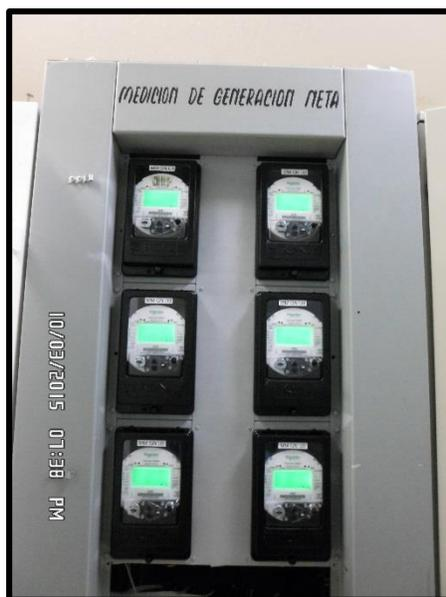
*Fig. 3.22* Transición de las Corrientes y Voltajes a los Medidores ION 8650A.
