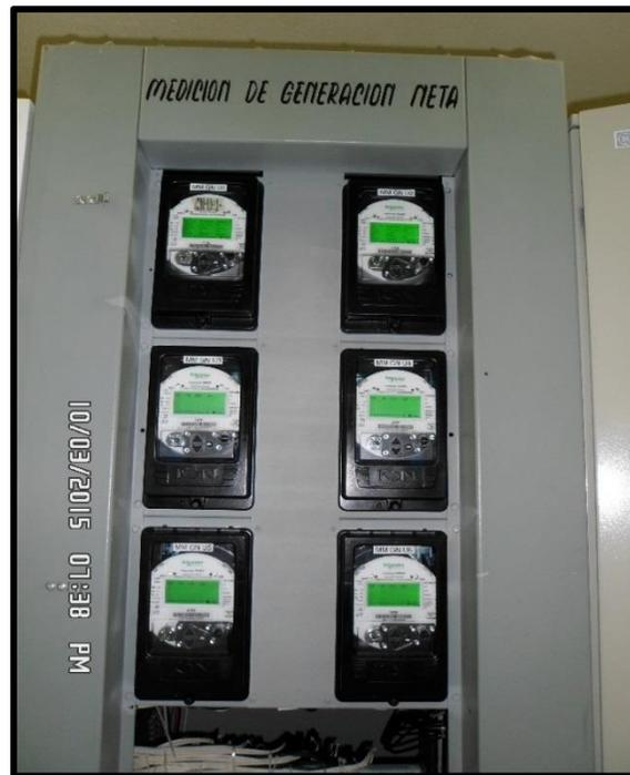
**Fig. 3.3** Gabinete de Medidores ION 8650A de Generación Neta.
