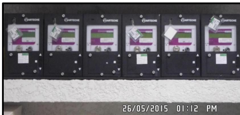
*Fig. 3.21* Desmontado de los Medidores de Energía de Generación Neta ARTECHE.
