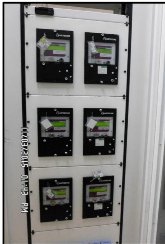
**Fig. 3.5** Gabinete de Medidores ARTECHE de Generación Neta.
