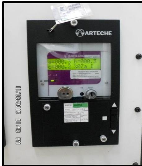
**Fig. 3.6** Medidor ARTECHE de Generación Neta.
