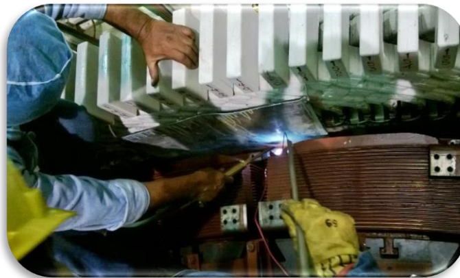
Fig.3.14 Retiro de conexiones eléctricas con soplete
