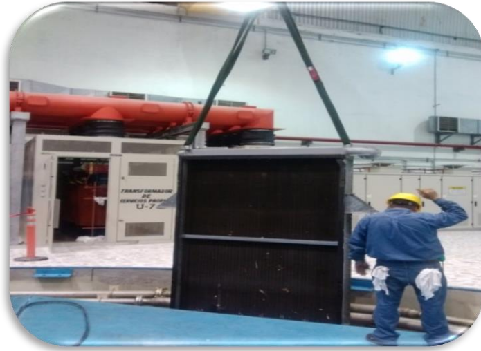
Fig.3.32 extracción de radiadores
