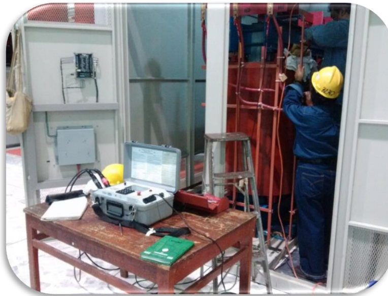
Fig.4.2 prueba resistencia de aislamiento TSP
