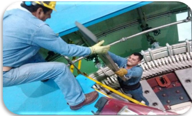
Figu.3.8 Retiro de tolvas superiores
