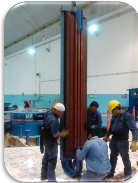
Fig.3.18 Colocación de placa de apoyo
