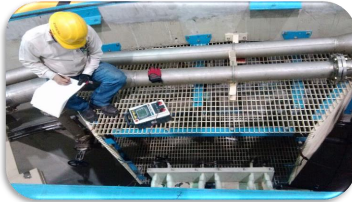
Fig.3.33 Prueba de resistencia de aislamiento LAPEM
