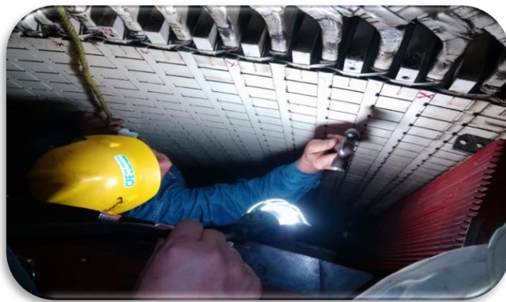
Fig.3.23 sondeo de las cuñas
