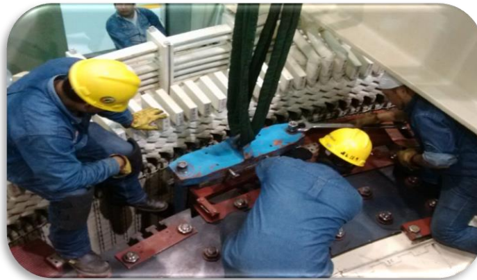
Fig. 3.35 Montado de los polos
