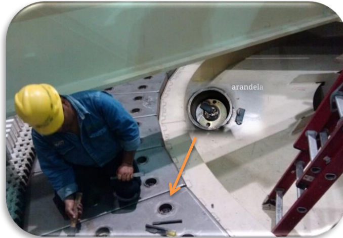
Fig.3.7 Extracción de seguros soldados
