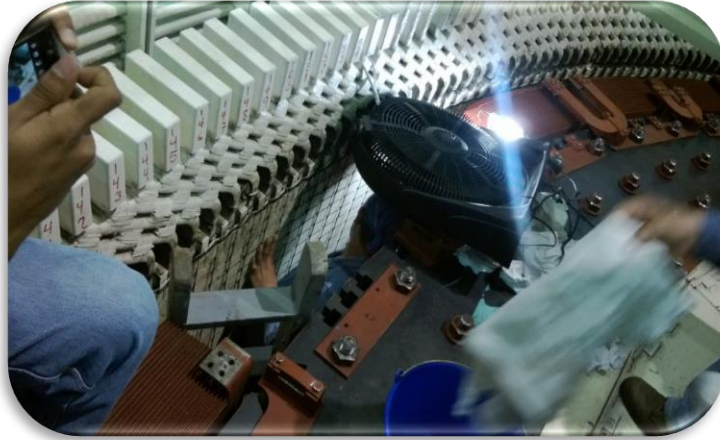
Fig.3.30 limpieza del laminado
