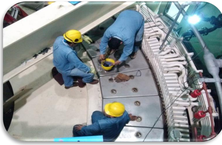
Fig. 3.38 Colocación de tolvas superiores
