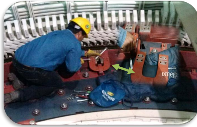
Fig. 3.13 Extracción de las conexiones eléctricas superiores omegas
