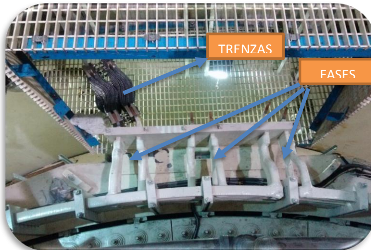
fig.3.40 conexión fases del lado neutro del generador
