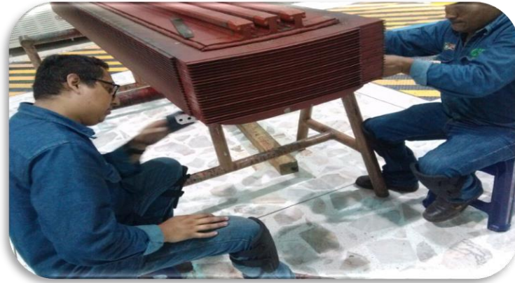
Fig.3.22 Limpieza y limado de conexiones eléctricas
