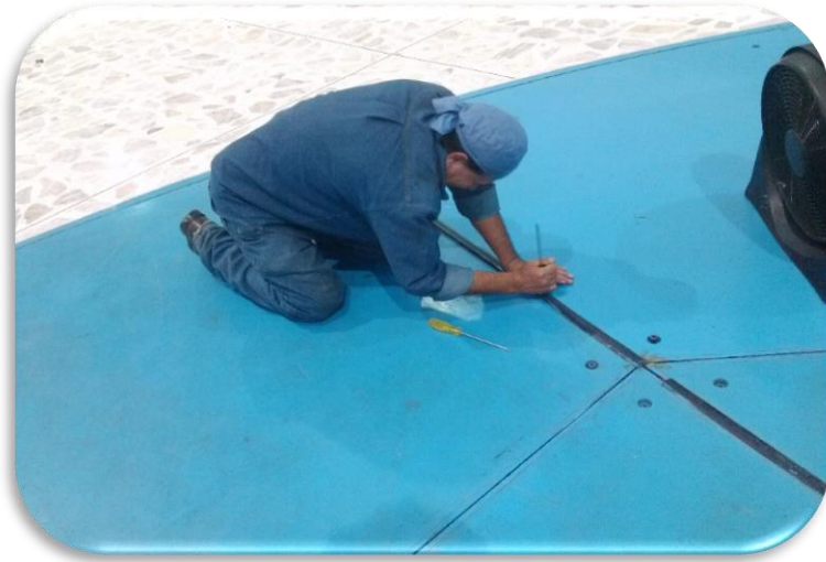
Fig.3.41 Colocación de tiras de empaque
