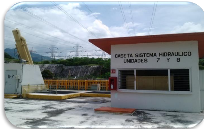
Fig. 3.1 Caseta sist. Hidráulico de obra de toma unidades 7 y 8
