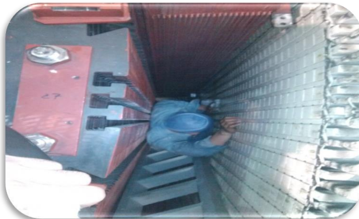
Fig.3.25 Aplicación de resina epoxi final de la cuña núm. 16
