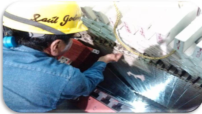
Fig.3.24 Aplicación de resina epoxi inicio de la cuña núm. 1
