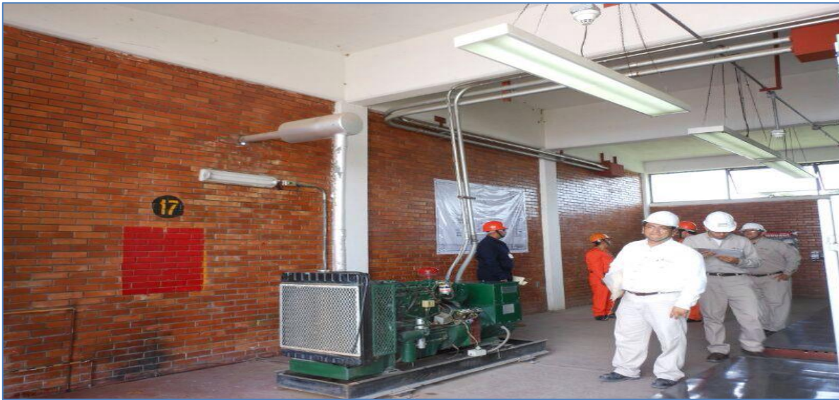
foto.1 Reunión que sostuvieron en las instalaciones de la subestación
