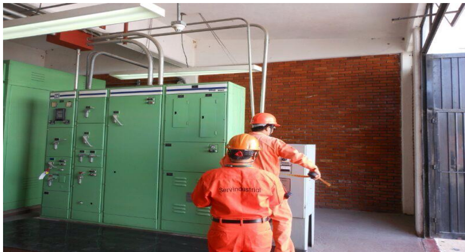
Foto.4 Medidas para la colocación del nuevo equipo
