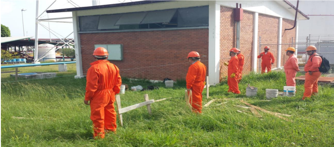
Foto. 2 Se observa el trazado de la obra
