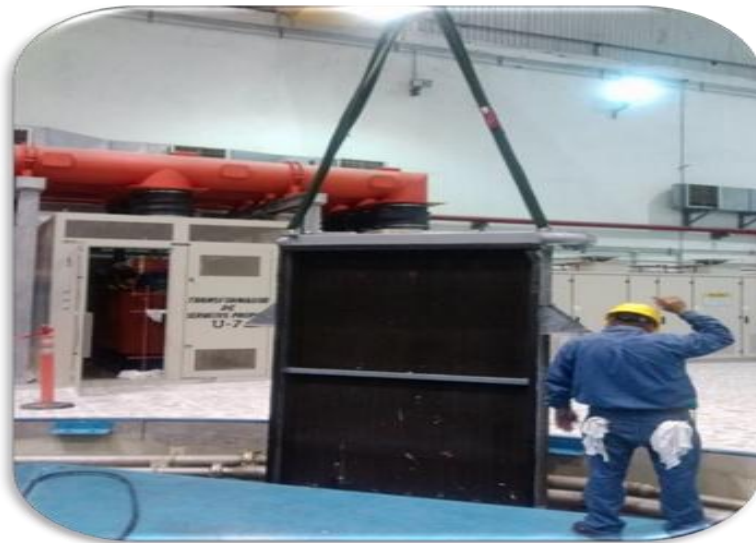
Extracción de radiadores
