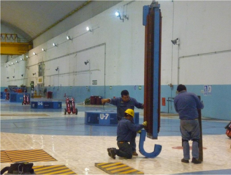
Colocación de placa de apoyo
