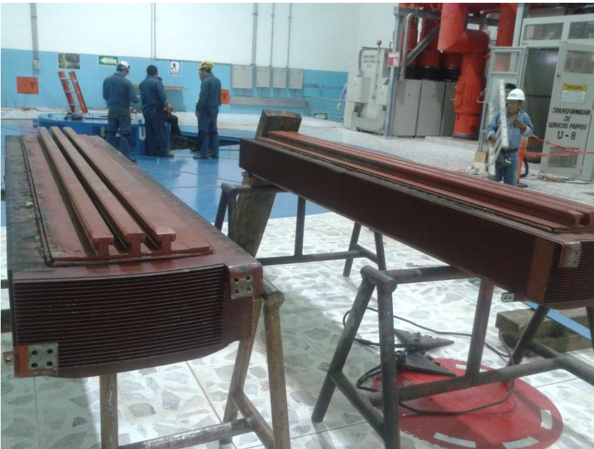
Colocación del polo en 2 burros
