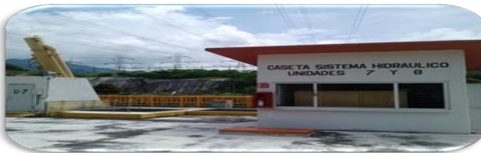
Compuerta obra de toma
