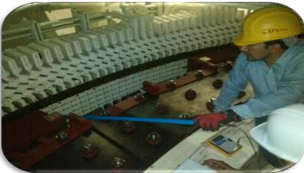
Prueba de descargas a la ranura
