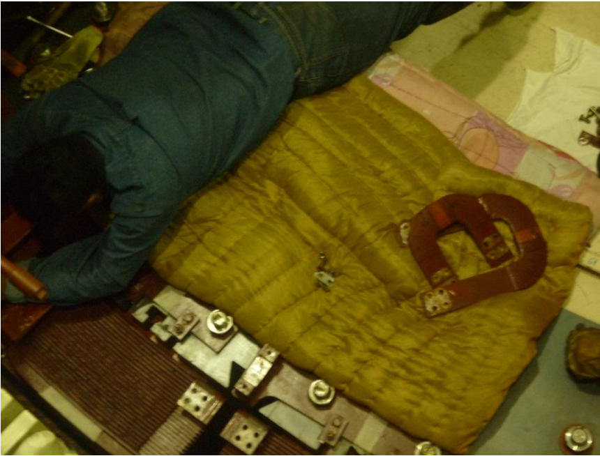
Extracción de las conexiones eléctricas superiores omegas
