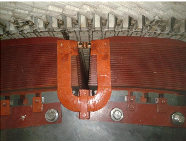
Extracción de las conexiones eléctricas superiores omegas
