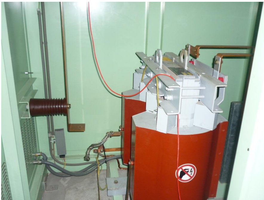
Transformador Neutro
