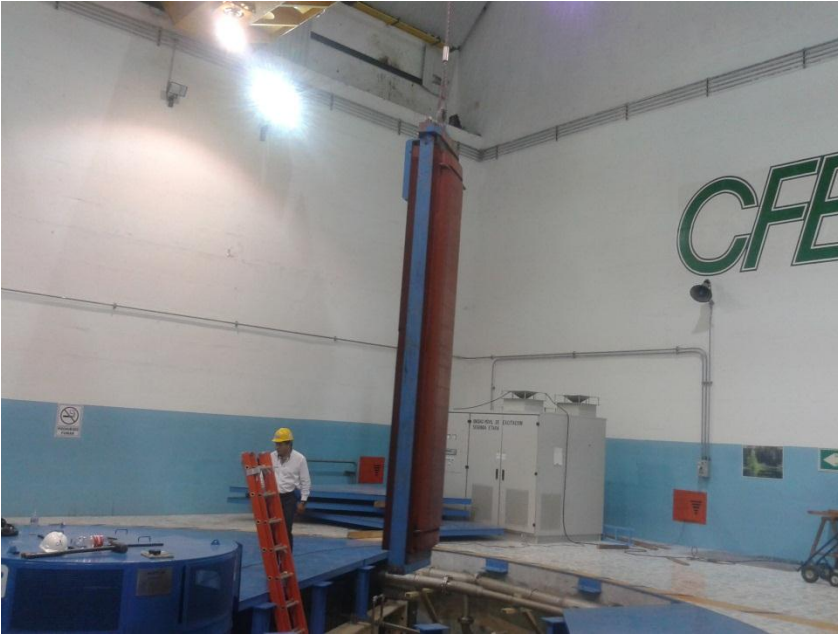
Extracción de los polos
