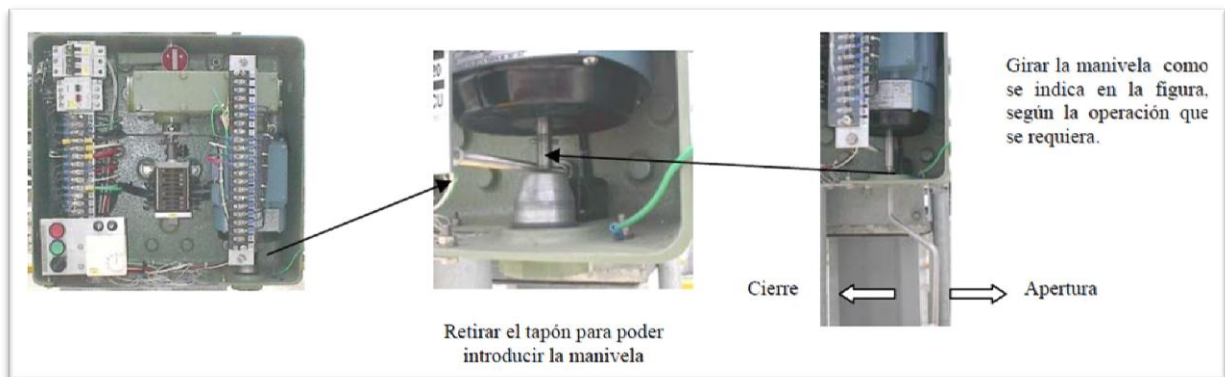
Fig. 1.15 OPERACIÓN DE CUCHILLAS DE FORMA MANUAL.
