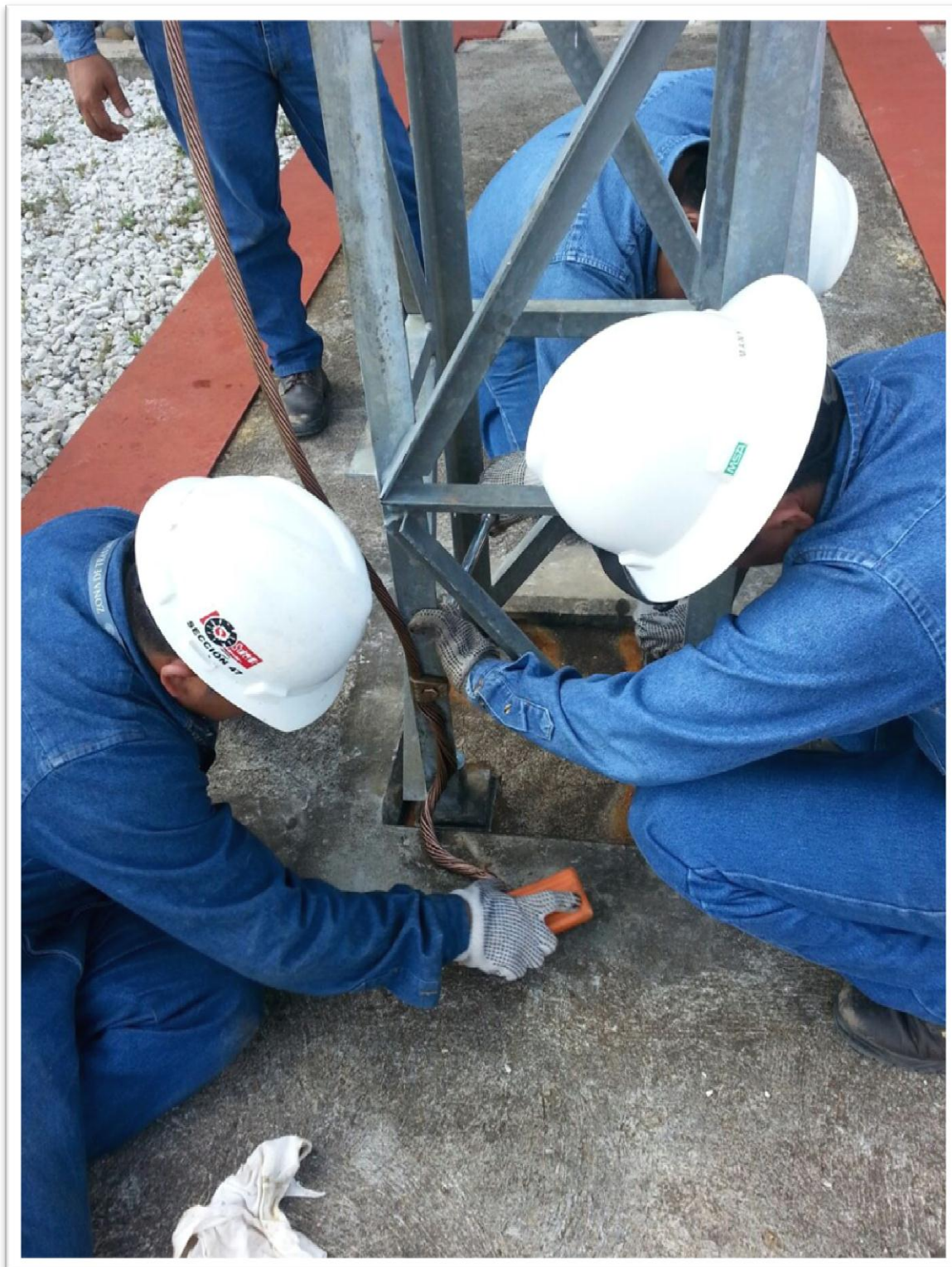
Fig. A6 LIMPIEZA DE SISTEMA A TIERRA DE UN APARTARRAYO DE 400 KV. CON LA HERRAMIENTA REQUERIDA.
