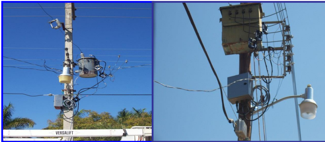
Fig. 27 Instalación de equipos de medición en la red de baja tensión.
