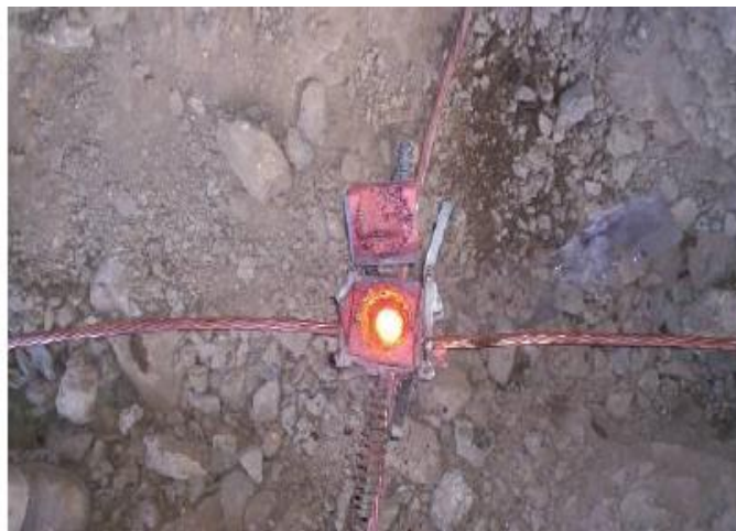
Fig.3.5 Soldadura para cobre.
