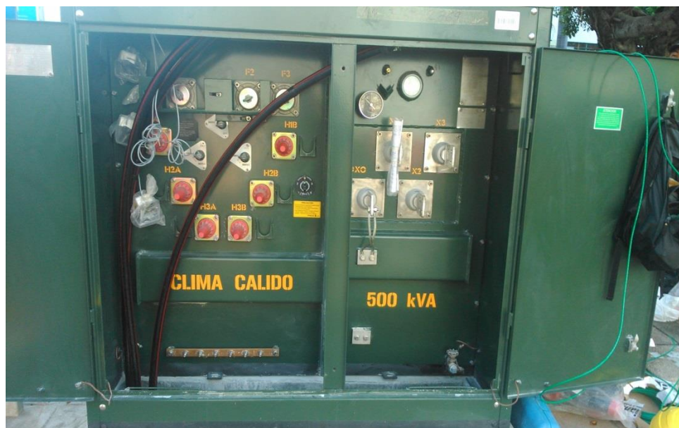
Fig. 4.5 Instalación del Transformador Trifásico de 500 KVA.
