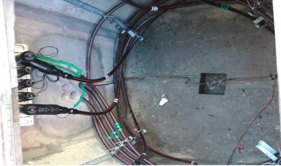
Fig. 4.6 Instalación del Sistema de Tierra.
