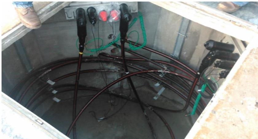
Fig. 4.3 Instalación de la caja Derivadora.
