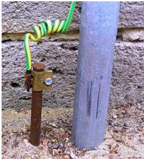
FIG. 10 CONEXION DE PUESTA A TIERRA SERVICIO DOMICILIARIO
