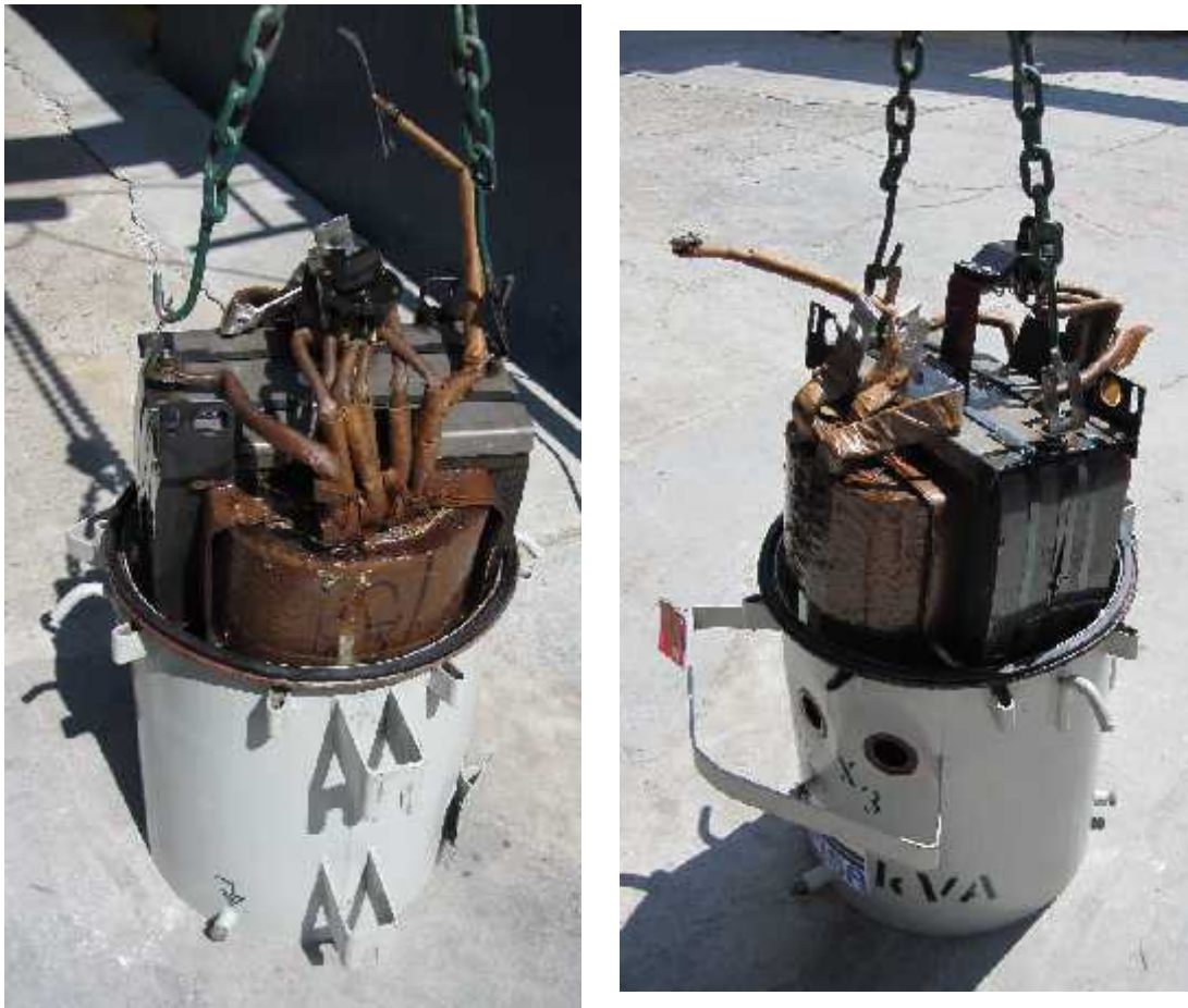
Figura 3.1.5. Proceso de extracción y escurrimiento del transformador (bobinas, núcleo, herraje).
