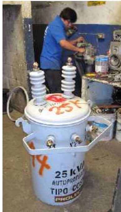
Figuras 3.1.12. Personal de la empresa E.I.M.S.A. realizando el proceso de ensamble.
