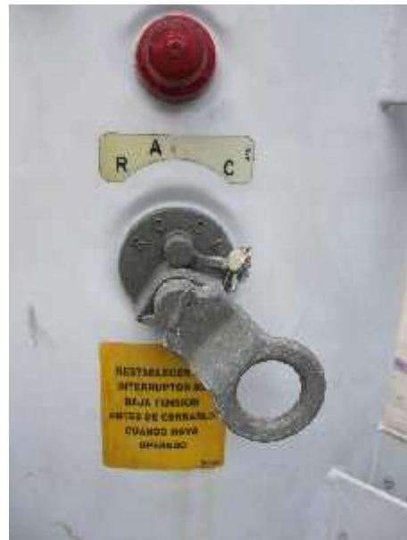
Figura 3.10. Muestra del interruptor e indicador de sobretensión:
