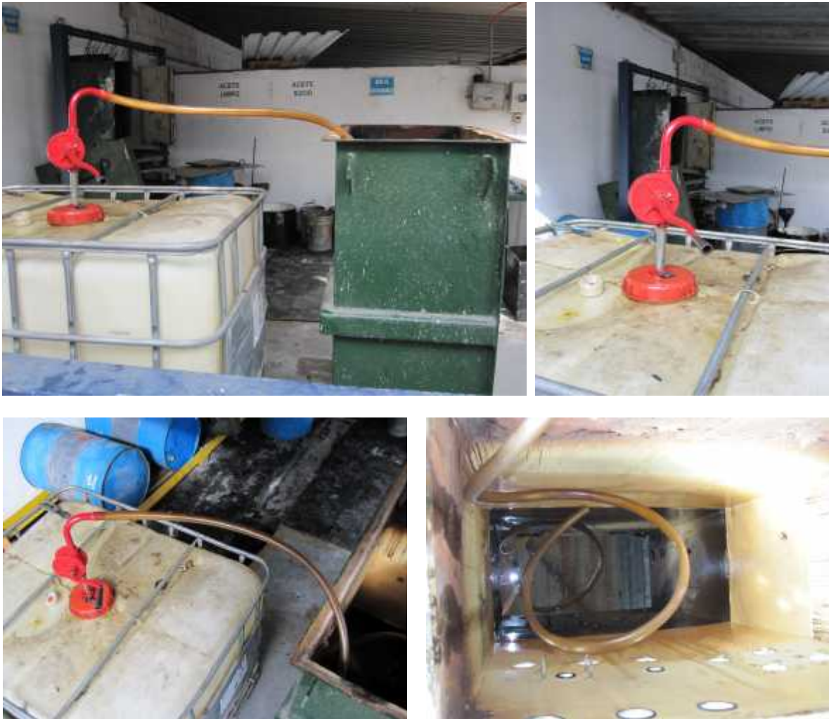
Figuras 3.1.3. Proceso de extracción del aceite dieléctrico.
