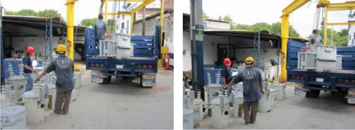
Figuras 3.1.2. Personal de la empresa E.I.M.S.A realizando labores de descarga de transformadores.
