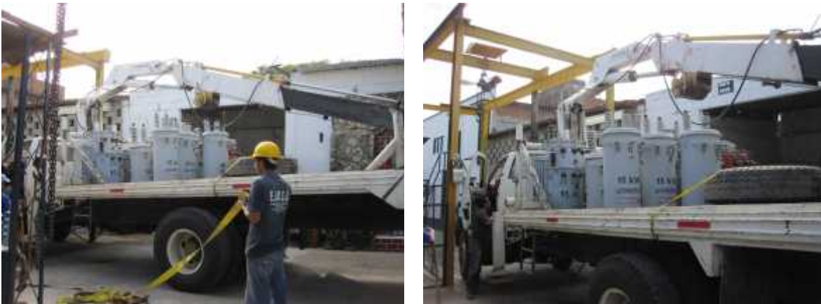
Figuras 3.1.1. Proceso de descarga de transformadores.
