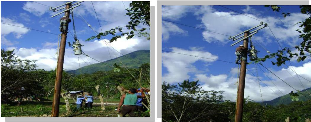
**Figura 3.12 Montaje de transformador.**
