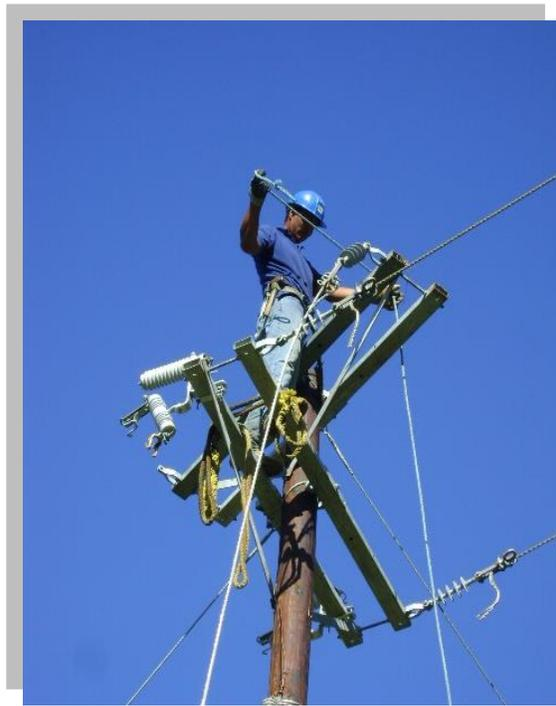
**Figura 3.8** *Vestido de estructura de poste en MT.*
