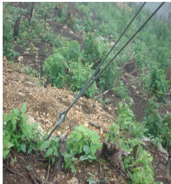
**Figura 3.9** Instalación de perno ancla.
