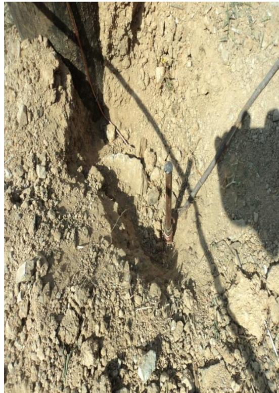
**Figura 3.11** *Instalación de electrodo de tierra.*
