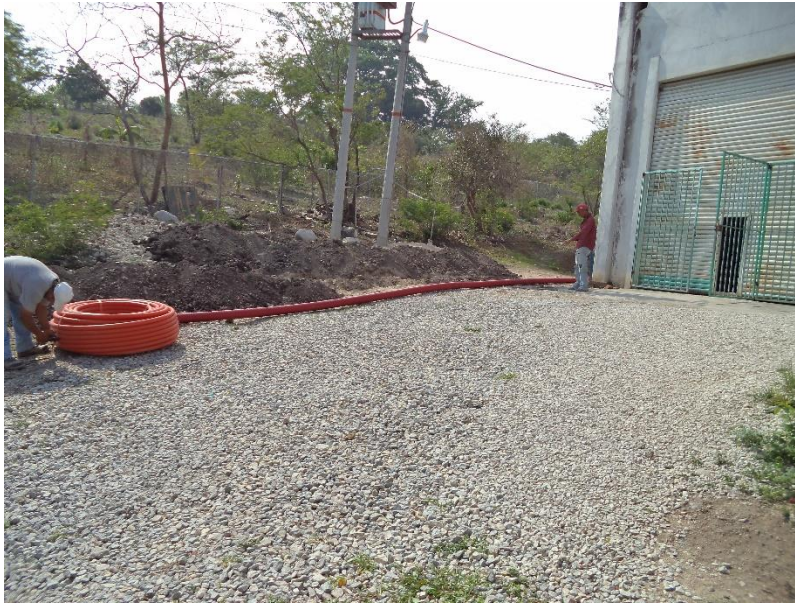
Fig. 4.11 Excavación para puesta de registros y tuberías del RBTB-1 01 al RBTB-1 02.
