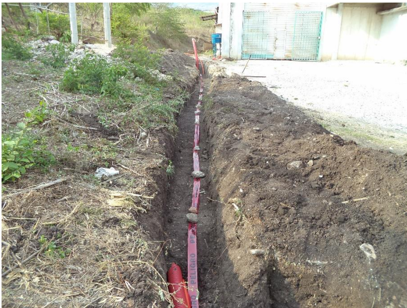
Fig. 4.16 Señalización con banda de “peligro”, después de puesta de tubos y compactado de suelo RBTB-1 01 a RBTB-1 02.
