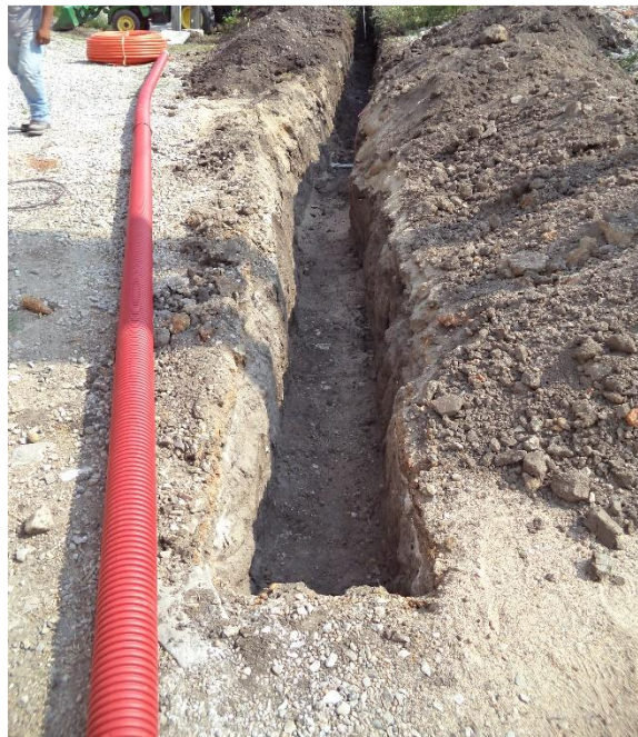
Fig. 4.12 Zanja del RBTB-1 01, para compactado y nivelado de suelo e instalación del 02.
