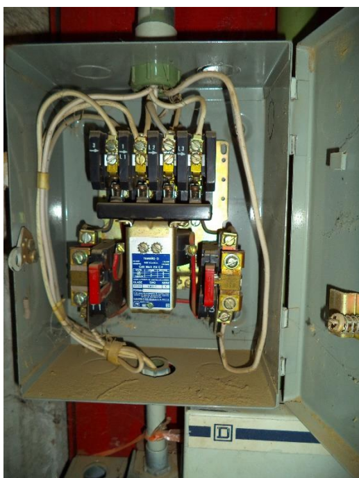
Fig. 3.15 Square D Clase 8536 LBO-2 Serie C Arrancador de 3HP, 600 VCA, 18 Amperes parte del tablero de control de línea 1.
