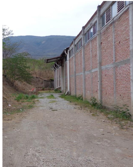
Fig. 3.18 Ausencia de luminarias en toda el área lateral izquierda de bodegas y nave de procesos (vista desde la entrada).
