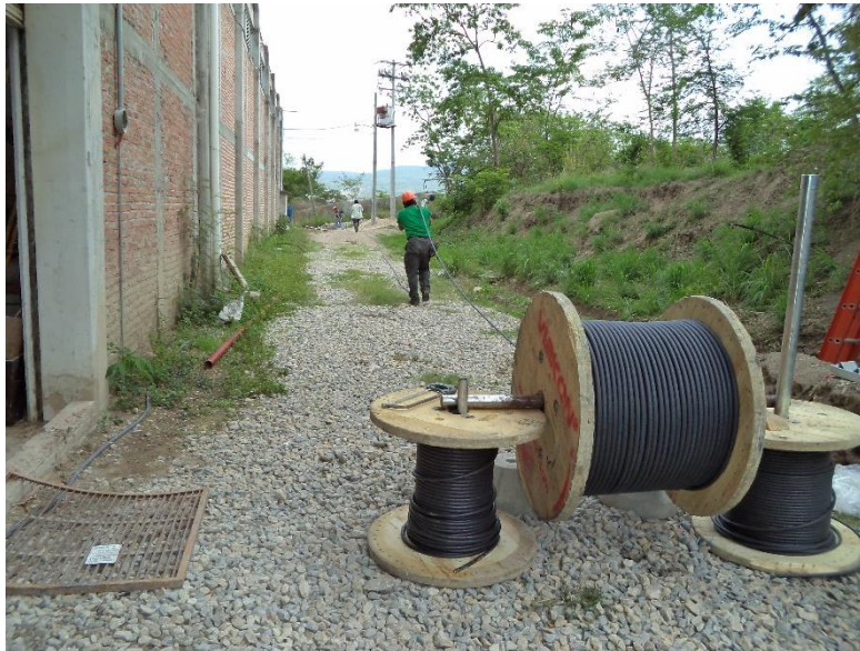
Fig. 4.42 Desenrollando el conductor del circuito alimentador del CCM y banco de capacitores.
