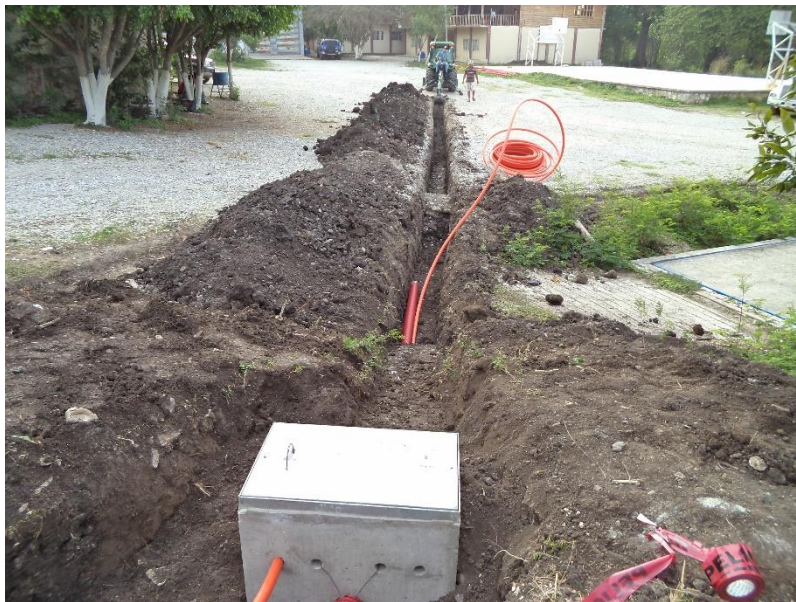
Fig. 4.18 Inserción de tubería del RBTB-1 02 para el RBTB-1 03.
