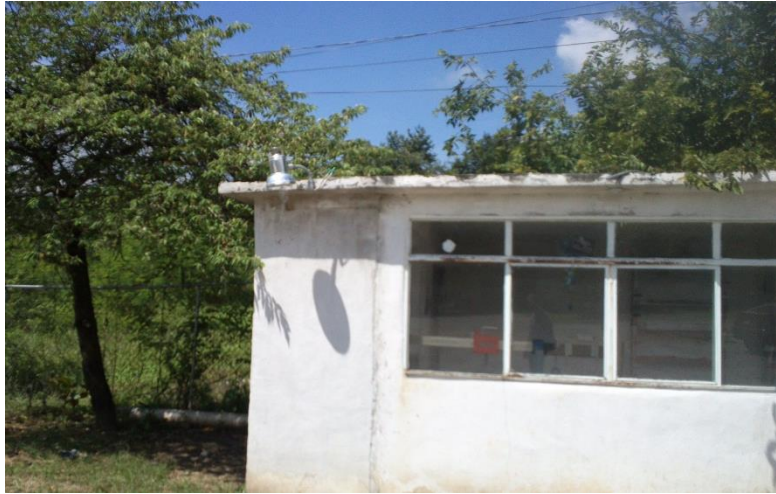
Fig. 3.20 Luminaria instalada sobre la caseta de báscula.
