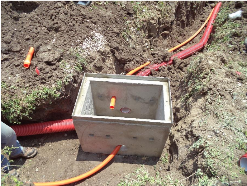
Fig. 4.23 Compactado, nivelado de suelo y puesta de tubería en RBTB-1 03
