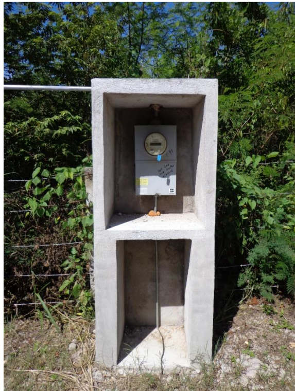
Fig. 4.6 Murete de medición terminado con medidor en función.
