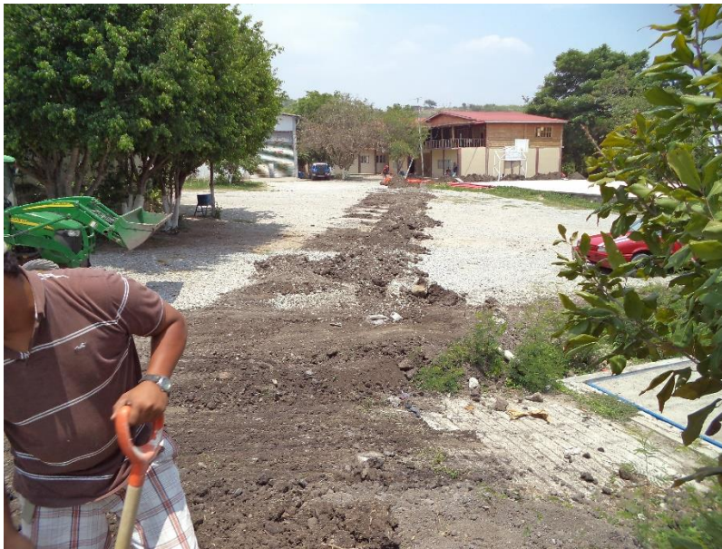
Fig. 4.24 Relleno de zanjas, compactado y nivelado de suelo.
