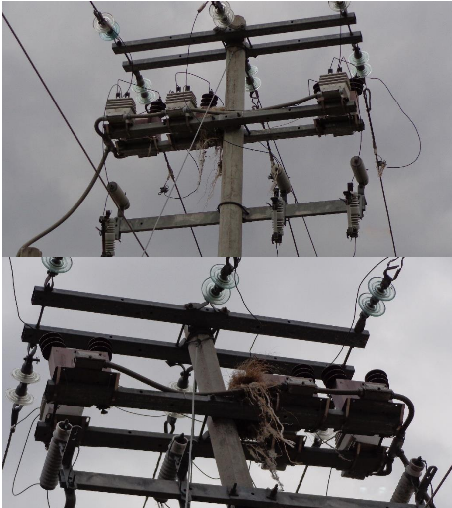
Fig. 3.5 S.E.1, vista frontal y trasera de los equipos de medición (TC's y TP's), se observa la saturación de equipos y falta de limpieza.
