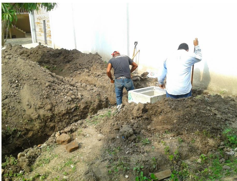
Fig. 4.28 Excavación para puesta de RBTB-1 05 derivado del RBTB-1 04.
