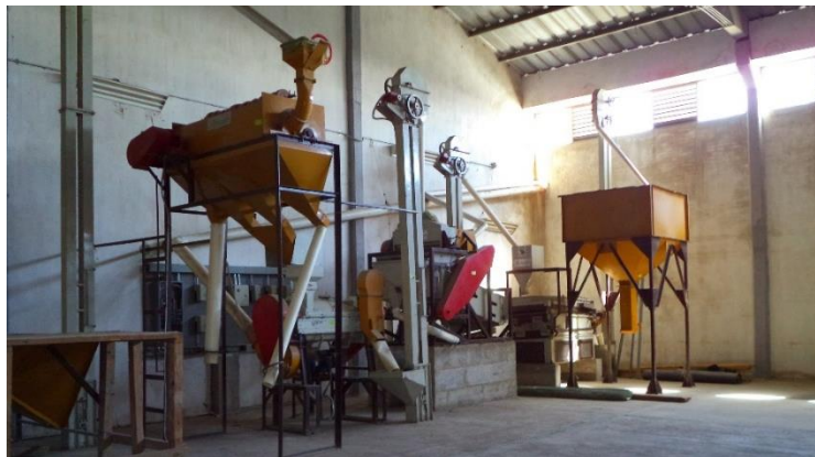
Fig. 3.26 Nave de procesos línea 2, el proceso es más corto.
