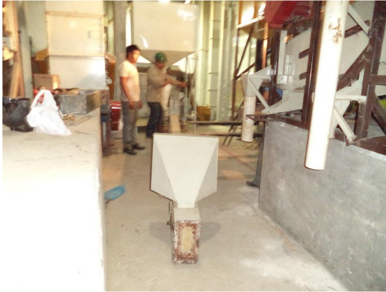
Fig. 4.35 Elevador próximo a montar de acuerdo al nuevo diseño.
