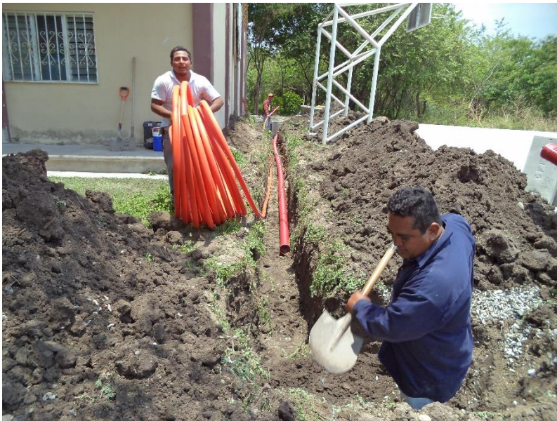
Fig. 4.22 Excavación para intersección de tuberías RBTB-1 03 (Intersectan el RBTB-1 02 y RBTB-1 04).
