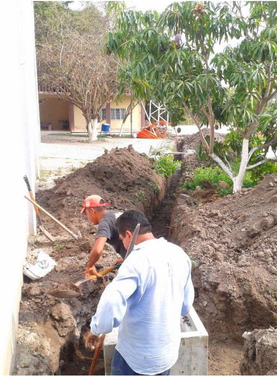
Fig. 4.29 Nivelado y compactado de suelo para puesta de RBTB-1 05.
