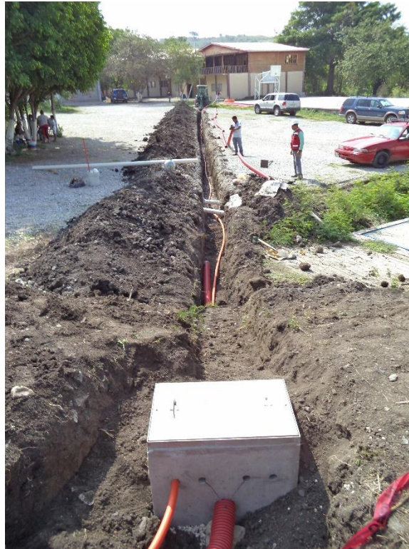
Fig. 4.19 Inserción de tubería en zanja del RBTB-1 02 para el RBTB-1 03.
