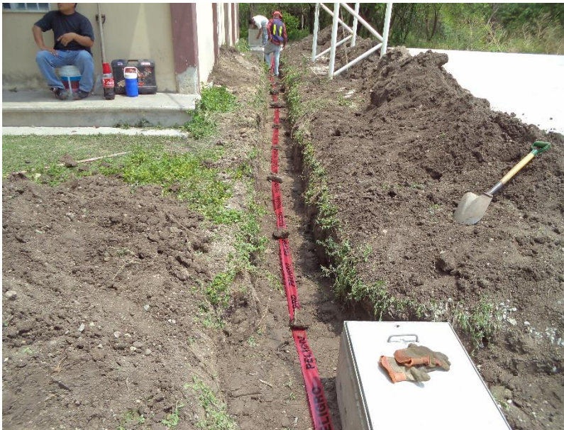
Fig. 4.26 Señalización con banda “peligro”, después de puesta de tubos y compactado de suelo tramo RBTB-1 03 a RBTB-1 04.
