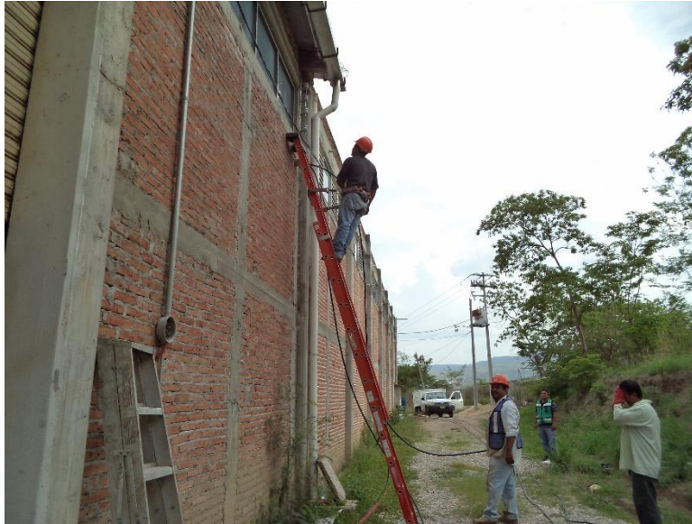
Fig. 4.43 Inserción de conductores en mufa y posteriormente acomodo en charolas de 9 pulgadas.
