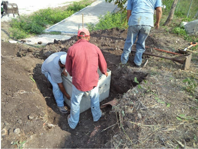
Fig. 4.13 Colocación del RBTB-1 02, angulación para puesta de tubería.
