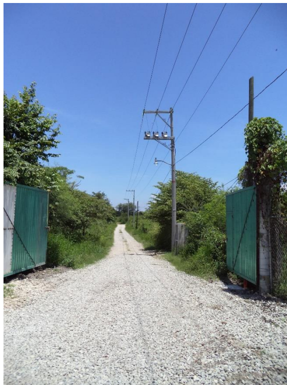
Fig. 4.4 Poste 3, estructura tipo VS3N con equipos de medición tp's y tc's a 55m del poste
