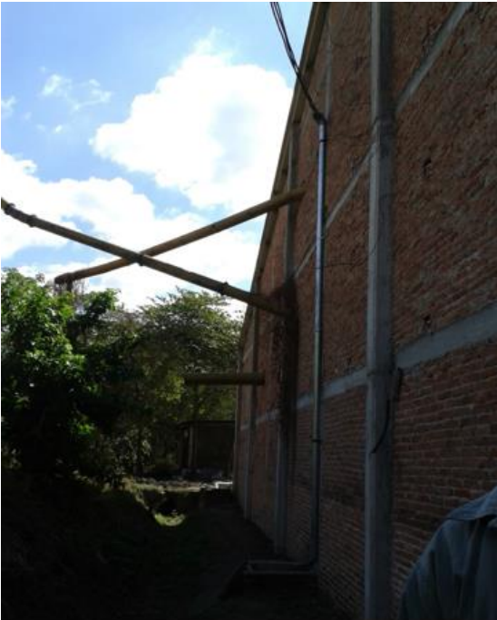
Fig. 3.8 Mufa y registro del circuito alimentador que procede de la S.E.2
