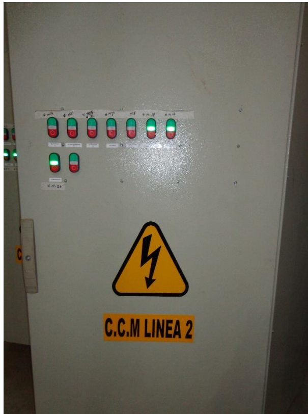
Fig. 4.53 CCM Línea 2 con 8 pulsadores arranque / paro.
