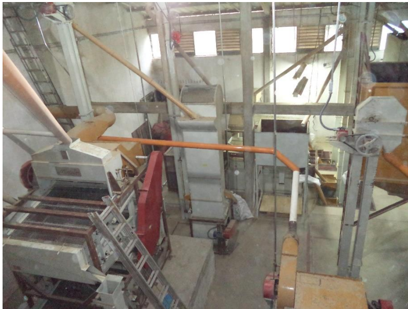
Fig. 4.36 Vista aérea del reacomodo de equipos en la nave de procesos.
