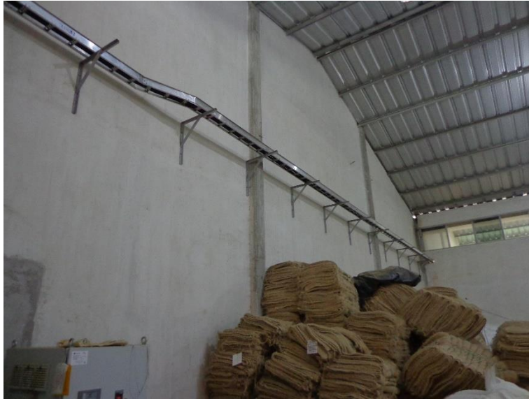
Fig. 4.47 Charolas que provienen de la mufa con alimentadores para CCM y banco de capacitores.
