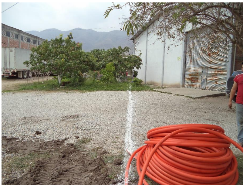
Fig. 4.27 Trazado para excavación de zanja y puesta de RBTB-1 05, 25m.
