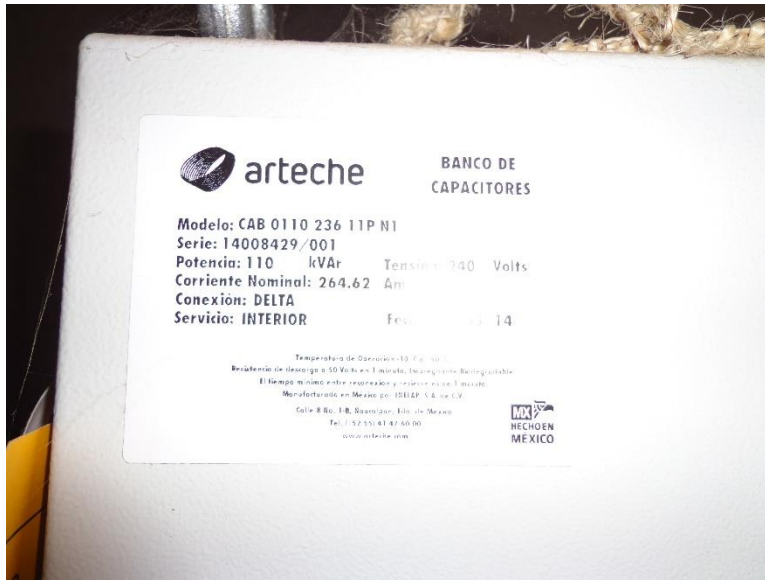
Fig. 4.57 Características del banco de capacitores entre ellas el modelo, serie, potencia, corriente nominal y conexión.
