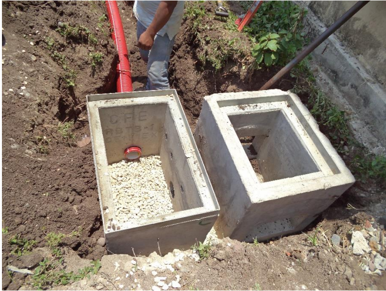
Fig. 4.21 RBTB-1 04 (11.5 m) con tubo PADC al lado registro para Telmex.
