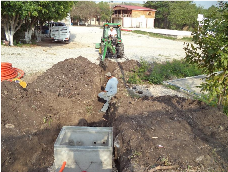
Fig. 4.17 Excavación del RBTB-1 02 para el RBTB-1.
