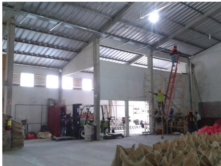
Fig. 4.44 Puesta de tuberías y conductores para alimentación de motores y equipos.
