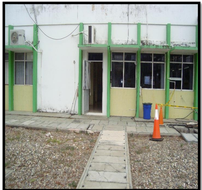
FIG. 70 CABLEADO EN HOTS
