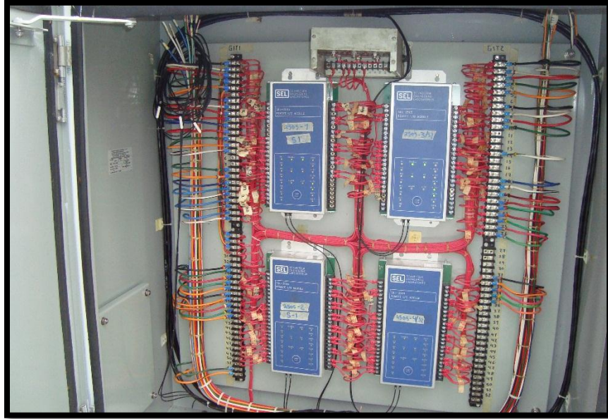
FIG. 73 CONVERTIDOR DE SAÑALES ANALOGICAS A DIGITALES
