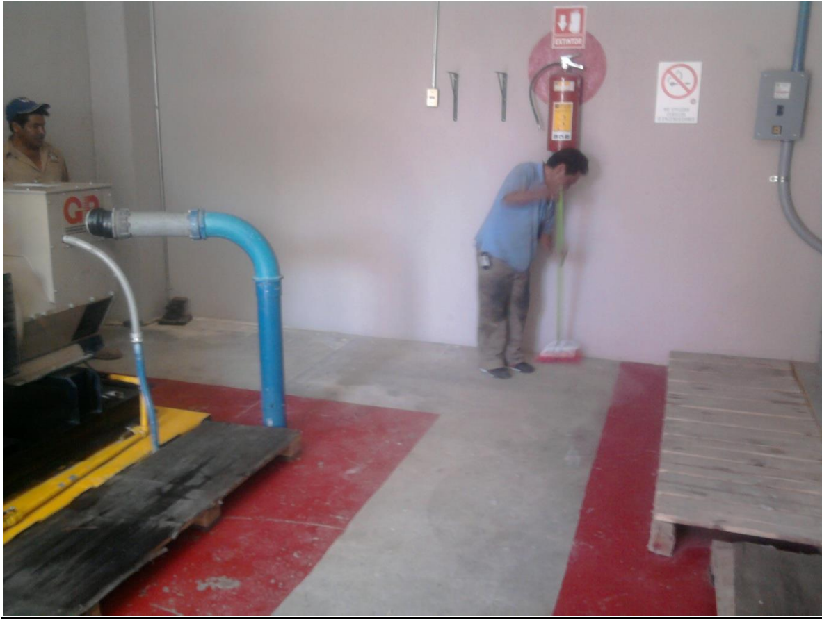
FIG 3.18 LIMPIEZA DEL AREA DONDE SE TRABAJO.
