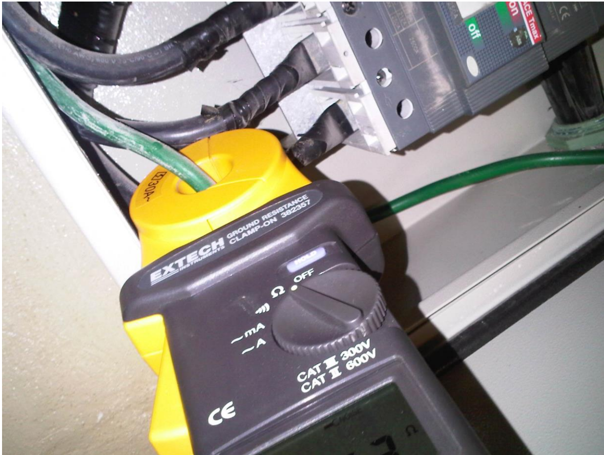
FIG 4.5 MIDIENDO LA LINERA DE TIERRA DEL TABLERO DE CONTROL
