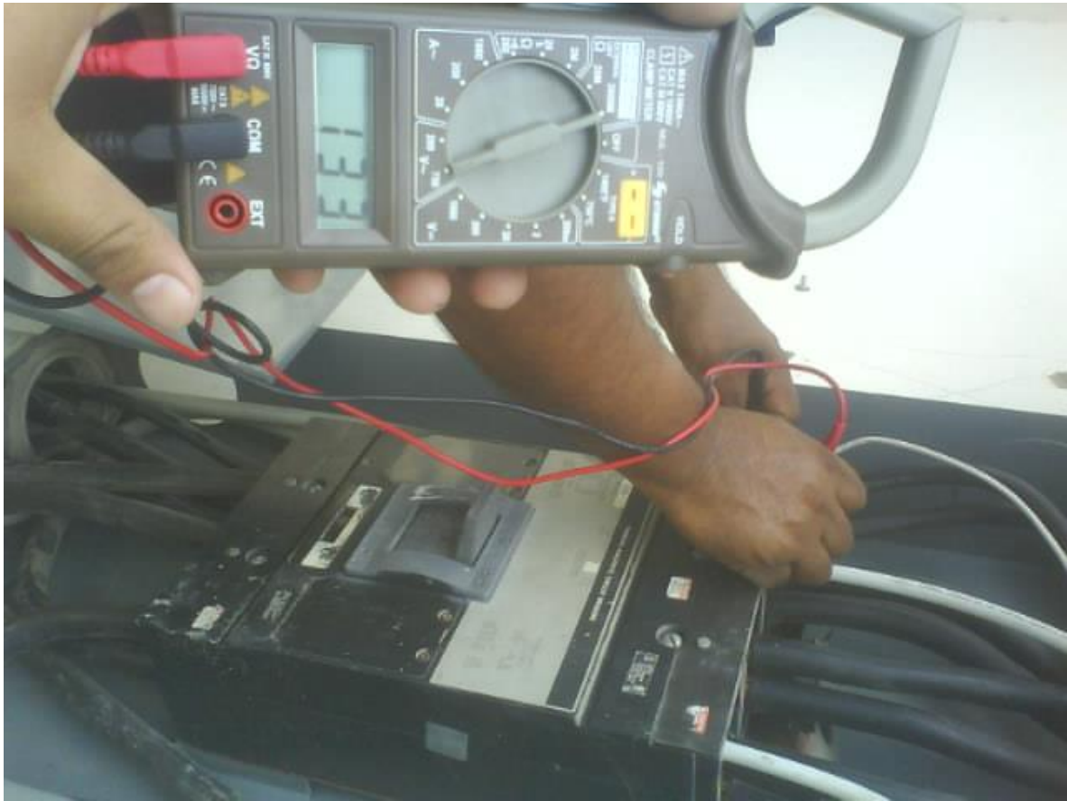
FIG 1.8 CHECANDO VOLTAJE DE LINEA A 110.
