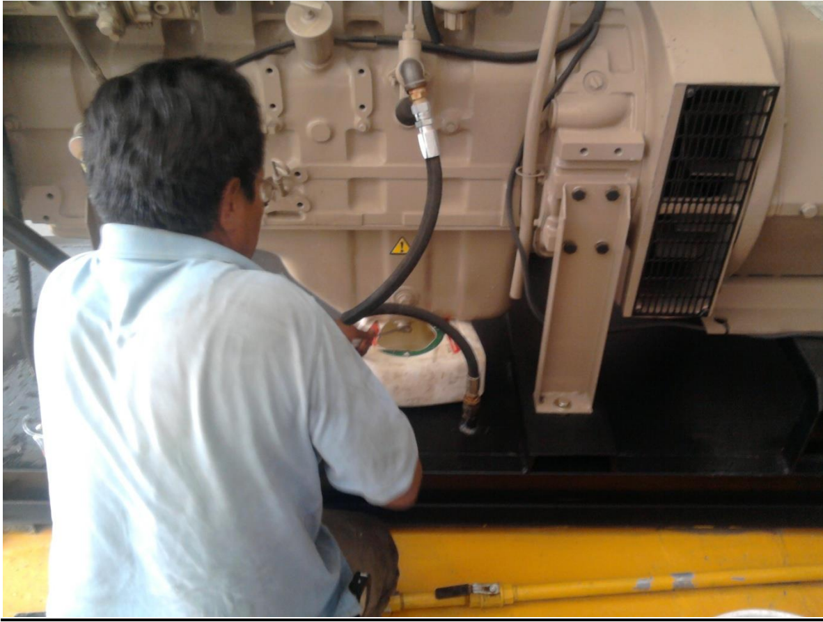
FIG 3.14 INSTALANDO EL FILTRO DE GASOLINA.
