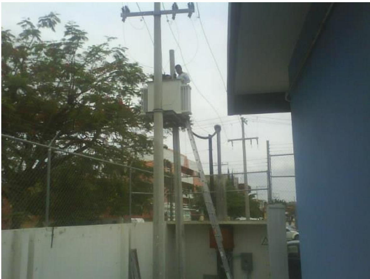
FIG. 1.4 LIMPIEZA Y VERIFICACION DEL TRANSFORMADOR.
