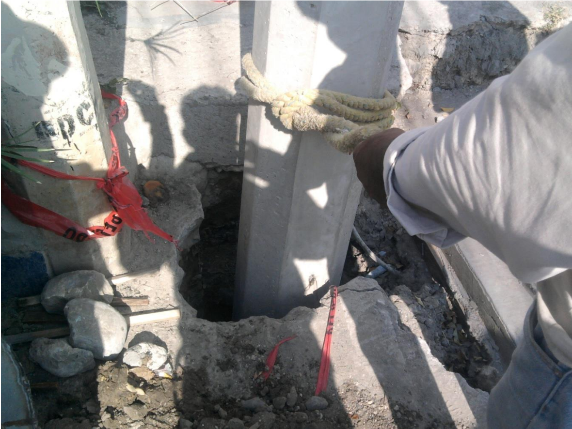
FIG 2.9 JALANDO EL POSTE DE TAL MANERA QUE LA CARA QUEDE CONFORME A LA NORMA DE CFE.
