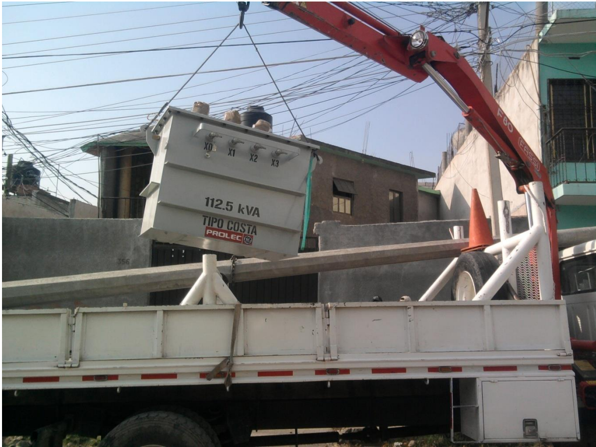
FIG 2.10 MANIOBRANDO CON EN TRANSFORMADOR.
