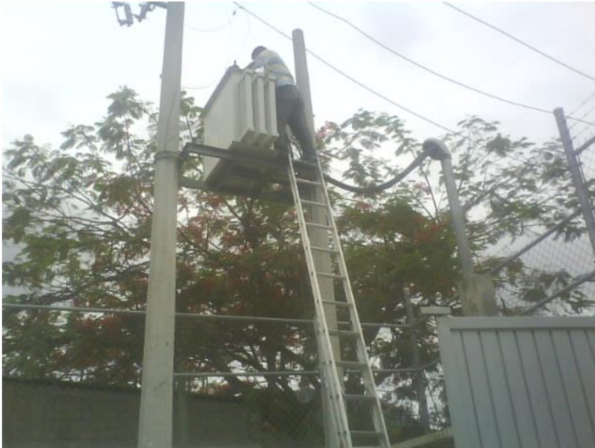
FOTO 1.1 COLOCACION DEL TRANSFORADOR EN MEDIO DE LOS 2 POSTES SOSTENIDO POR MEDIO DE ABRAZADERAS Y HERRAJES INDUSTRIALES MANIOBRANDO POR MEDIO DE UNA ESCALERA TELESCOPICA
