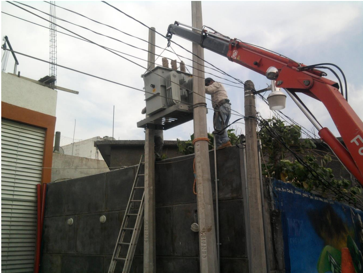
FIG 2.15 ACOMODANDO EL TRANSFORMADOR
