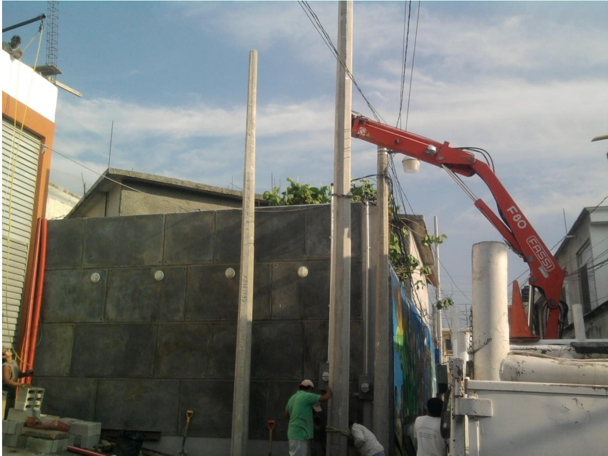
FIG 2.12 COLOCACION DEL SEGUNDO POSTE EN LA PARTE INTERIOR.
