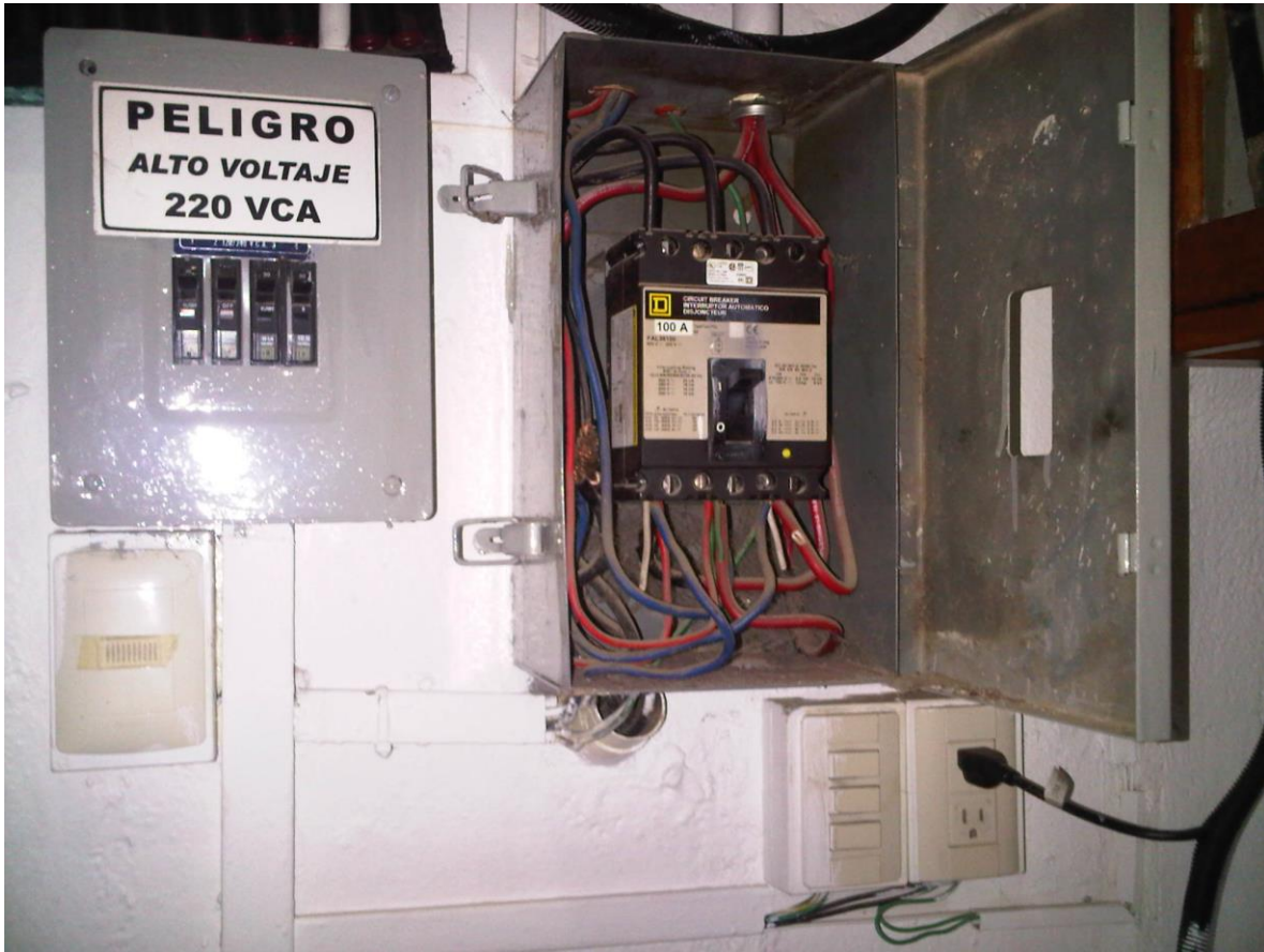
FIG 4.8 ALIMENTACION DEL EDIFICIO.
