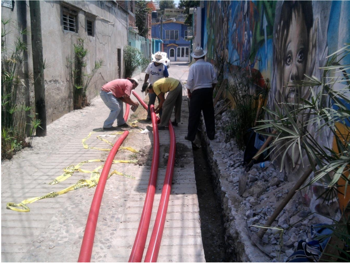
FIG 2.5 TUBERIA PAD QUE IRA DENTRO DEL REGISTRO
