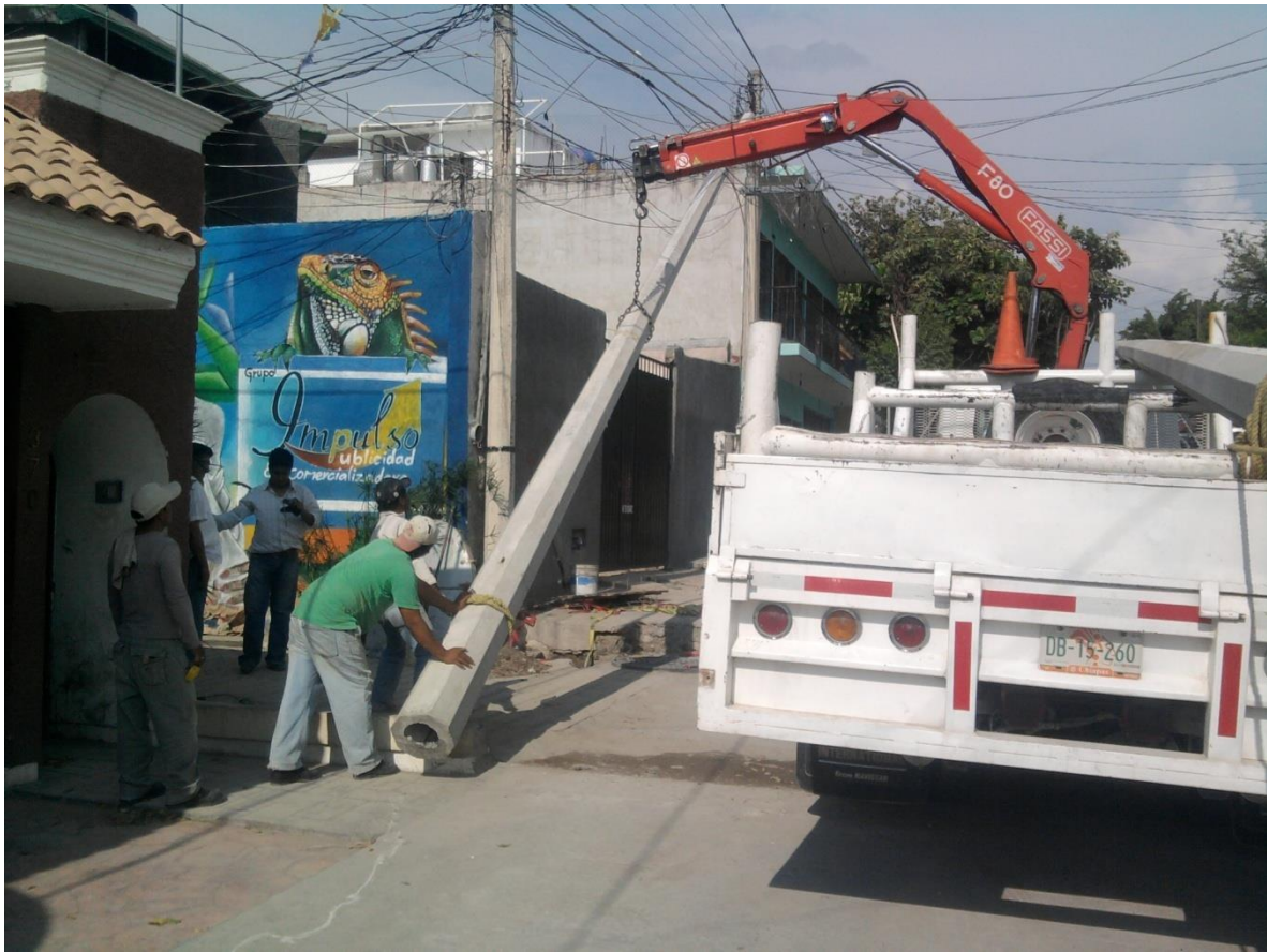
FIG 2.7 OTRA VISTA DE LAS MANIOBRAS PARA COLOCAR EL POSTE
