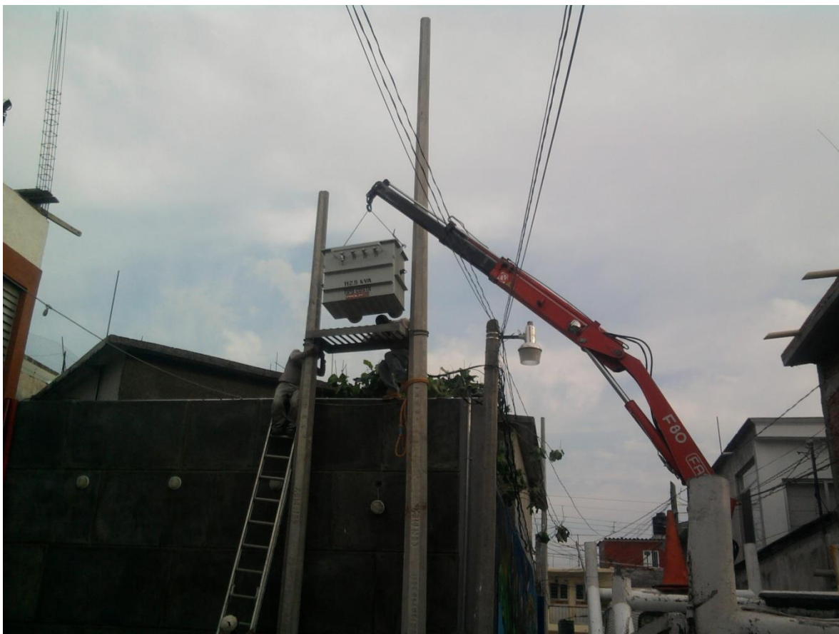
FIG 2.14 MANIOBRA Y COLOCACION DEL TRANSFORMADOR SOBRE LA REJILLA.
