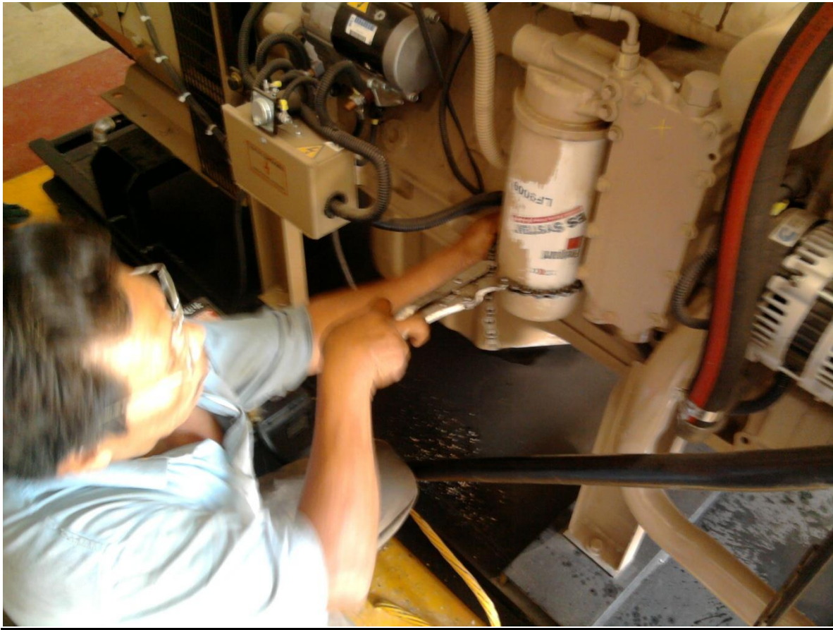
FIG 3.15 INSTALANDO EL FILTRO DE ACEITE.
