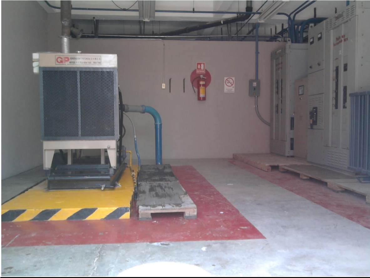
FIG 3.19 VISTA GENERAL DE LA PLANTA DE EMERGENCIA DESPUES DEL MANTENIMIENTO.
