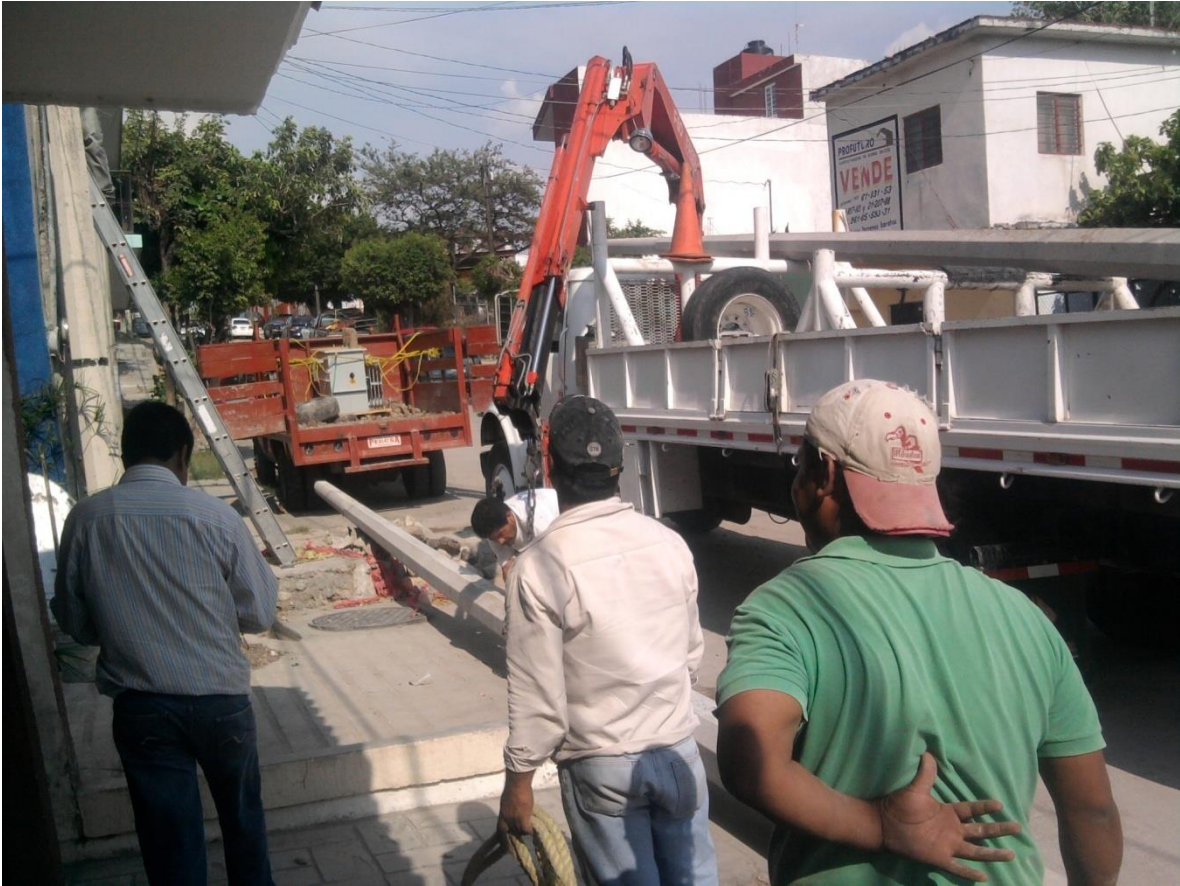
FIG 2.6 GRUA QUE REALIZARA MANIOBRAS PARA COLOCACION DEL POSTE DE 11 METROS EN LA PARTE DE AFUERA.
