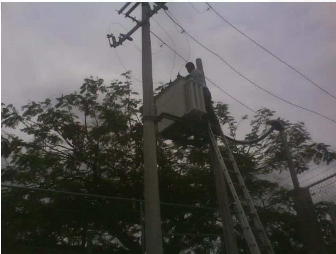
FIG. 1.2 APRIETE DE TUERCAS Y TORNILLOS DE LAS BOQUILLAS DEL TRANSFORMADOR.
