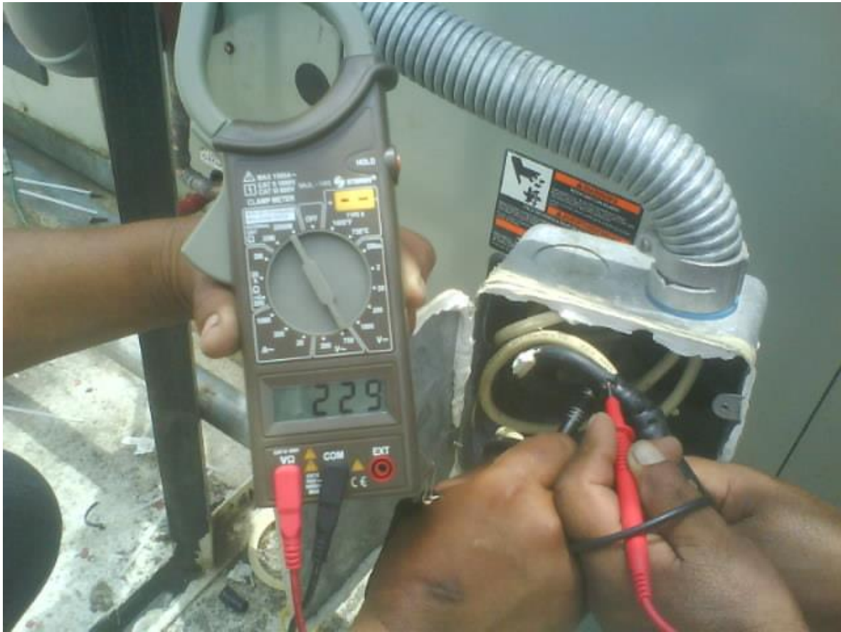
FIG 1.7 CHECANDO VOLTAJE DE LAS LINEAS A 220
