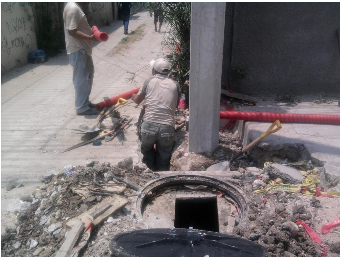
FIG 2.16 REGISTROS CASI TERMINADOS DONDE PASARAN POR AHÍ COS CABLES DE POTENCIA ALADO DEL POSTE DE AFUERA EXIGIDO POR LA CFE.
