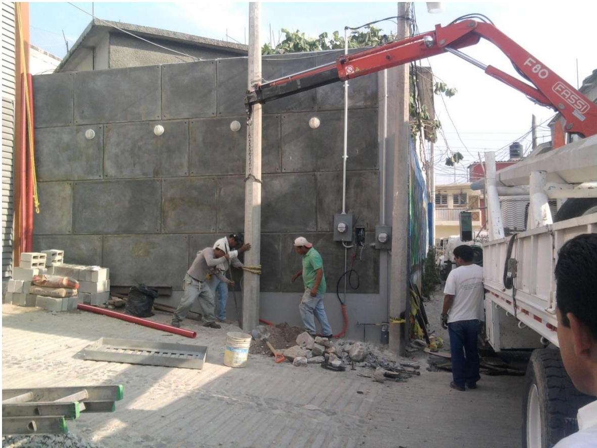
FIG 2.11 COLOCACION DE POSTES DONDE EN MEDIO IRA UNA REJILLA DONDE SE COLOCARA EL TRANSFORMADOR.
