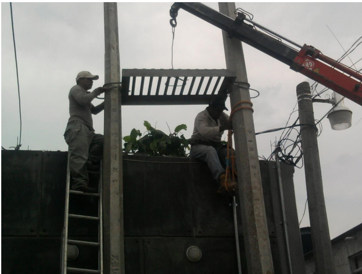
FIG 2.13 COLOCACION DE LA REJILLA POR MEDIO DE ABRAZADERAS Y TORNILLOS INDUSTRIALES.
