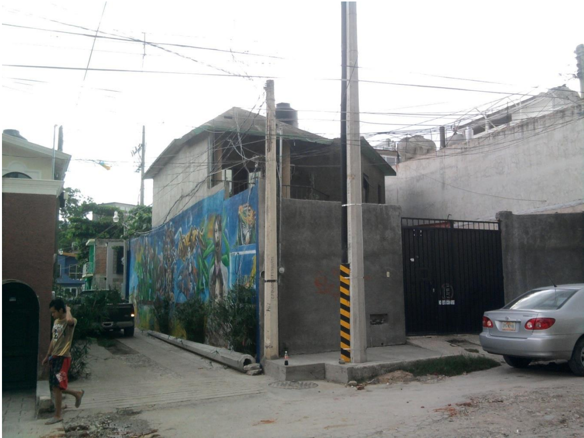
FIG 2.18 FIG EL LA PARTE DE AFUERA QUEDANDO FINALIZADA LA CONEXIÓN DE LAS LINEAS DE 13200 V.
