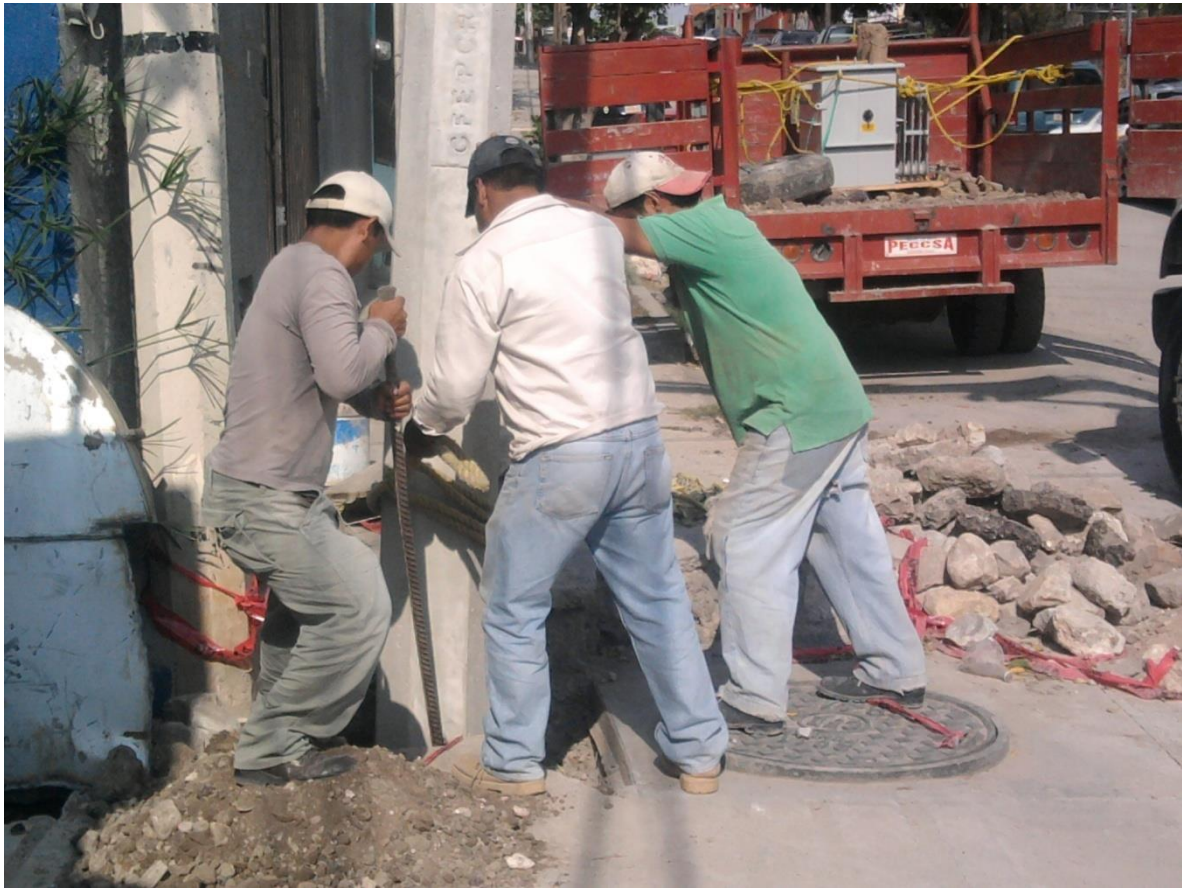
FIG 2.8 EL POSTE SE HA ENTERRADO 1.80 METROS DONDE PASARA LAS LINEAS DE MEDIA TENSION.
