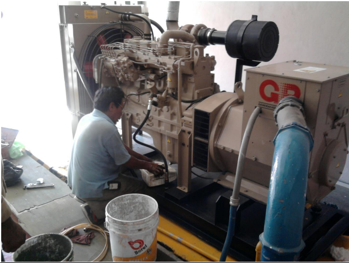
FIG 3.15 RETIRANDO EL ACEITE SUCIO DEL MOTOR.
