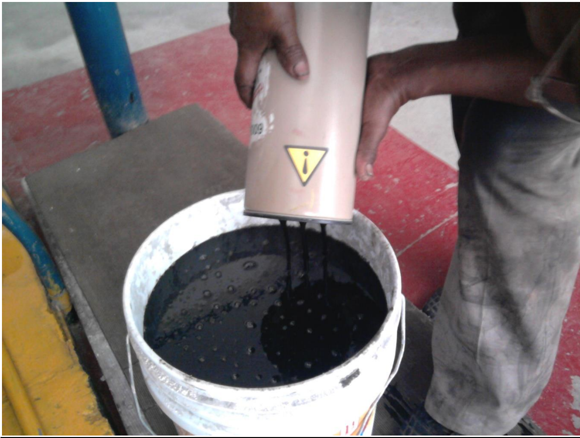
FIG 3.16 ACEITE QUEMADO EXTRAIDO DE LA PLANTA DE EMERGENCIA.
