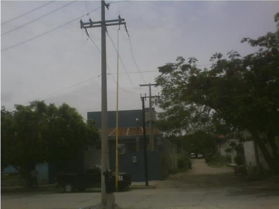
FIG. 1.5 HACIENDO LIBRANZA CON LA PERTIGA PARA DESCONECTAR LAS LINEAS DE MEDIA TENSION.
