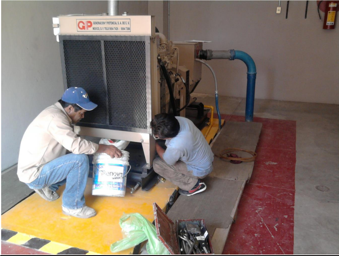
FIG 3.13 REGOGIENDO EL ANTICONGELANTE DE LA PLANTA.
