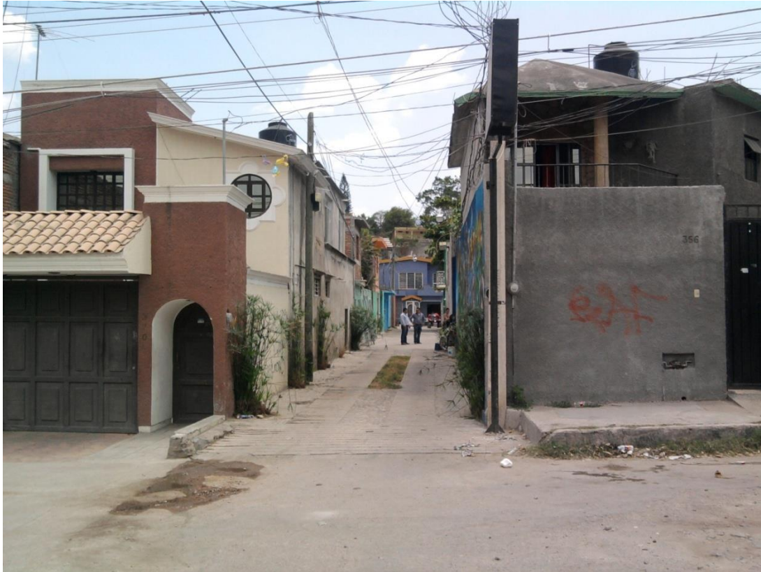
FIG 2.1 LUGAR DONDE SE INSTALARA EL TRANSFORMADOR DE 112.5 KVA UBICADO EN LA 11 NORTE ENTRE 1 Y 2 PONIENTE (IMPULSO COMERCIALIZADORA Y PUBLICIDAD S.A. DE C.V.)
