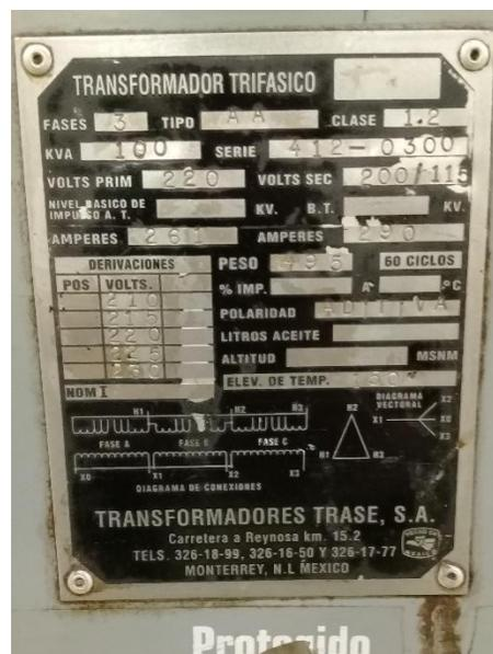
Transformador de alimentación de las maquinas bonder
