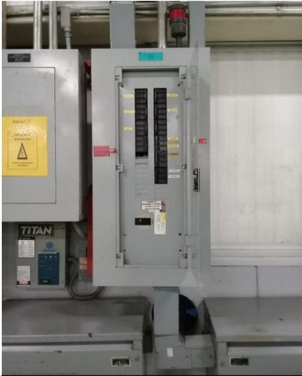
1.-Apretar terminales en el tablero de control y limpieza general con Sprite dieléctrico
