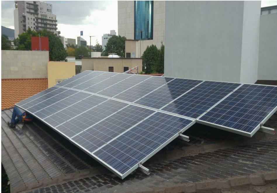
*Fig 3.13. Montaje de los paneles sobre la estructura.*
