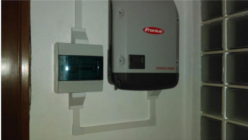
*Fig 3.19. Canalización terminada del inversor al gabinete2.*
