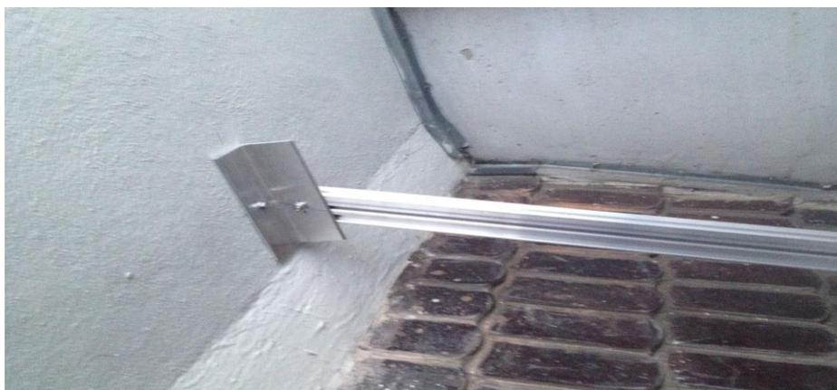
*Fig 3.12. Puntos de anclaje de la estructura.*
