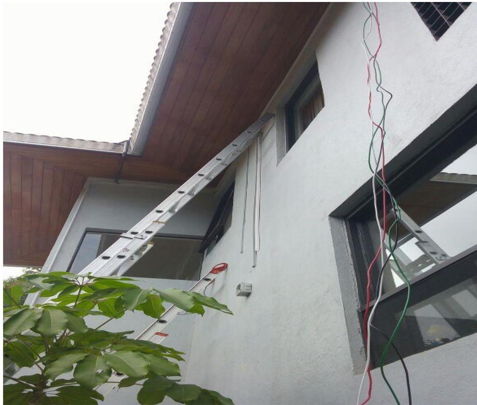
*Fig 3.16. Canalización con canaleta al inversor.*
