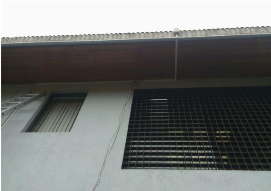
*Fig 3.17. Canalización con canaleta por debajo de la marquesina hacia el inversor.*
