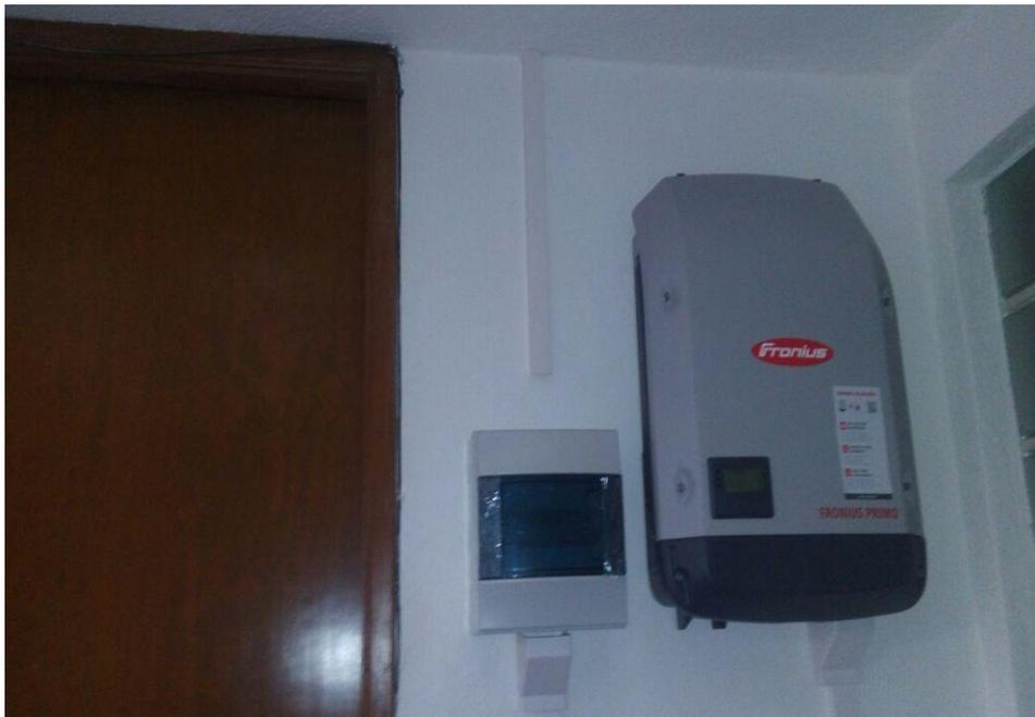
*Fig 3.18. Canalización del inversor al gabinete 2.*
