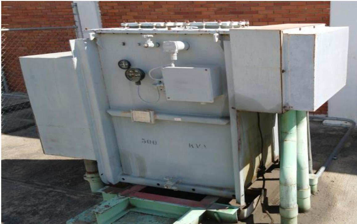
*Fig. 24. Transformador tipo pedestal. Fuente: Terminal de almacenamiento y despacho de Pemex*
