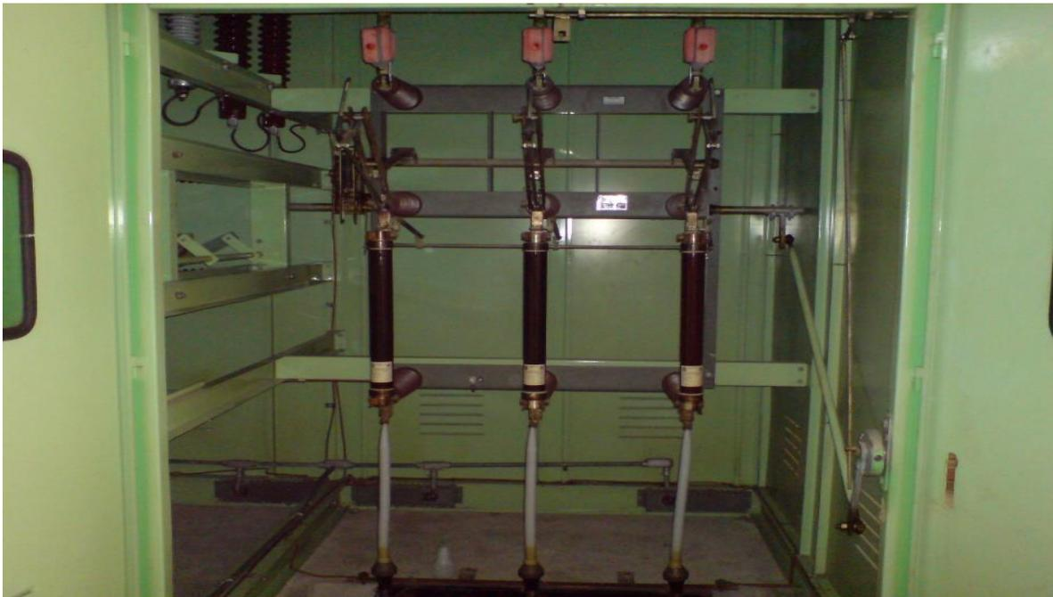
*Fig. 27. Cuchillas de alta. Fuente: Terminal de almacenamiento y despacho de Pemex*
