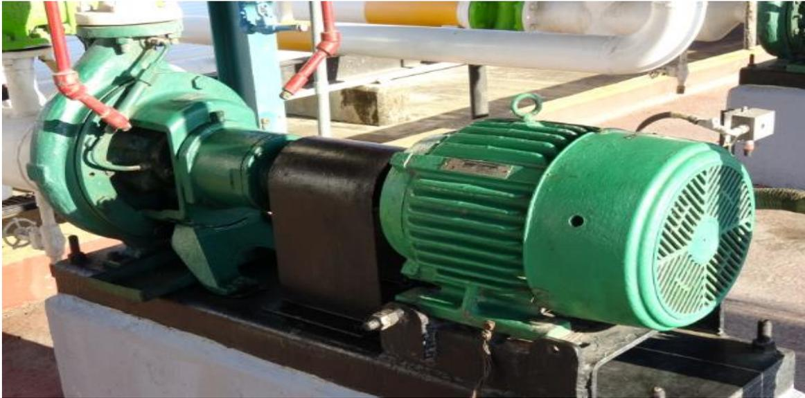
*Fig. 32. Bomba centrífuga con motor de 15hp. Fuente: Terminal de almacenamiento y despacho de Pemex*
