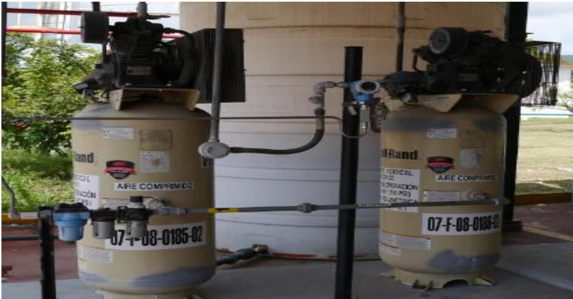
*Fig. 37. Sistema neumático con dos motores de 2hp en Cobertizo contra incendios No.1. Fuente: Terminal de almacenamiento y despacho de Pemex*
