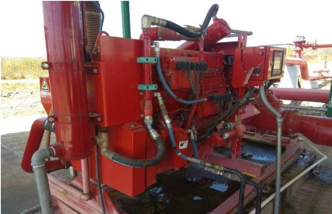
*Fig. 35. Bomba en el cobertizo contra incendios No.2 a base de Diesel. Fuente: Terminal de almacenamiento y despacho de Pemex*
