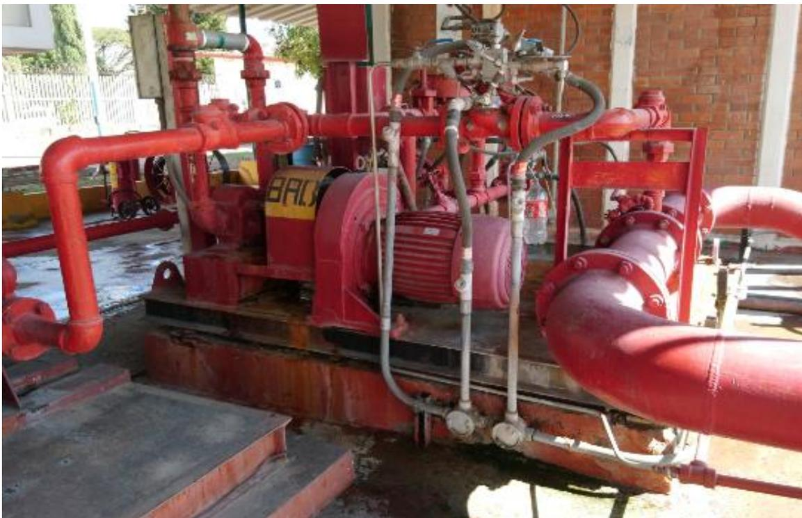
*Fig.36. Bomba con motor de 15hp en Cobertizo contra incendios No.1. Fuente: Terminal de almacenamiento y despacho de Pemex*
