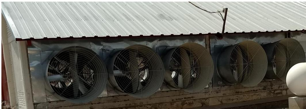
Figura 45 Extractores del sistema de ventilación.
