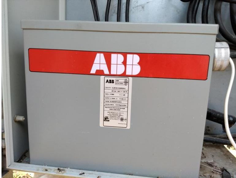
Figura 28 Banco de capacitores de 25 kVAR.
