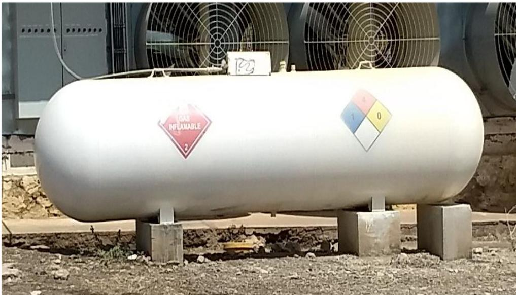
Figura 42 Tanque de almacenamiento de gas.
