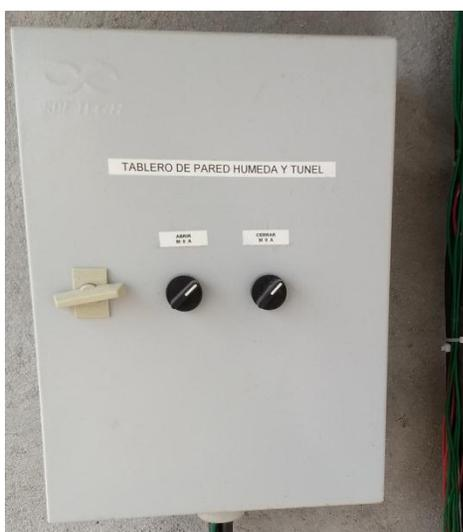
Figura 34 Tablero de pared húmeda y túnel.
