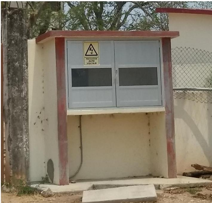
Figura 25 Murete de medición.
