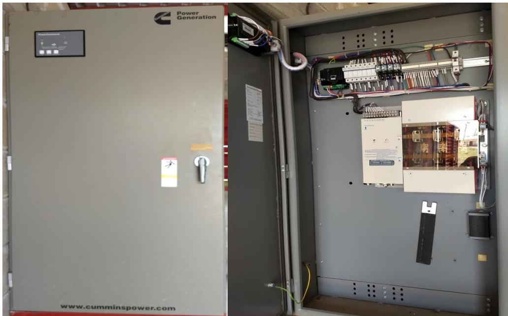
Figura 30 Módulo de transferencia automática.
