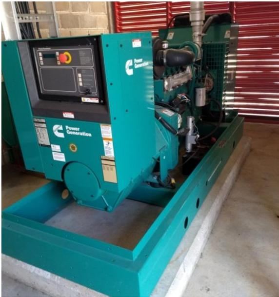
Figura 29 Planta de emergencia de 125 kW.
