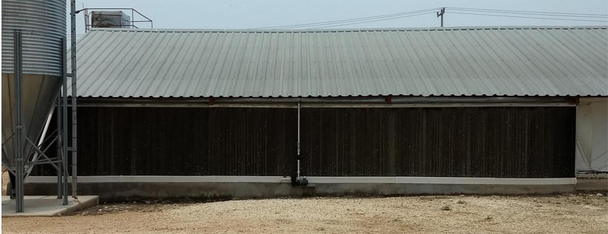
Figura 46 Pared húmeda del sistema de ventilación.
