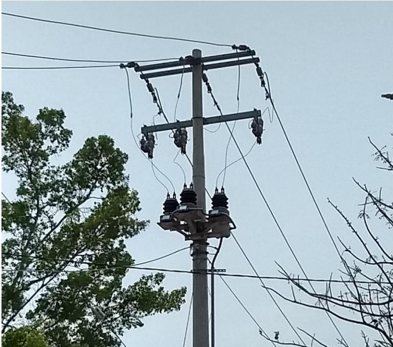
Figura 26 Transformadores de corriente para la medición en media tensión.
