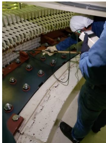
Imagen 25 - Pruebas de descargas a armadura.
