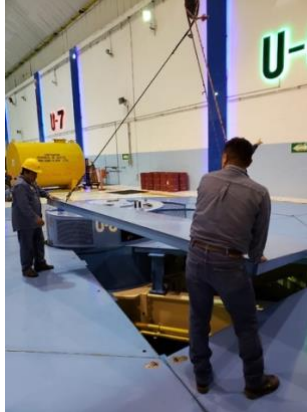
Imagen 36 – Cierre del generador síncrono.
