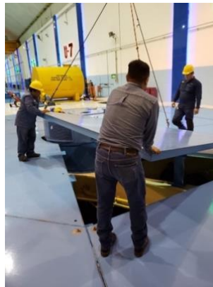
Imagen 12 - Maniobra para el destape del generador.
