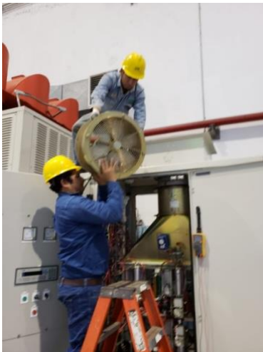
Imagen 22 - Extracción de ventilador del AVR.
