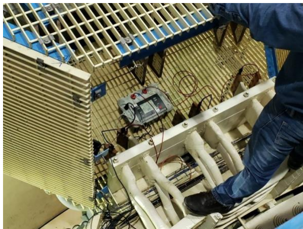
Imagen 23 - Pruebas de aislamiento con ayuda de un óhmetro megger.
