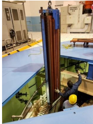
Imagen 13 – Extracción de polos para su mantenimiento.
