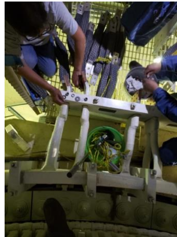
Imagen 33 - Colocación de trenzas de las salidas y neutro del generador síncrono.
