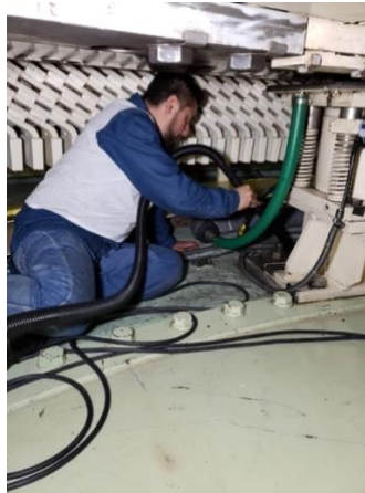
Imagen 16 - Limpieza de la segunda etapa del generador.
