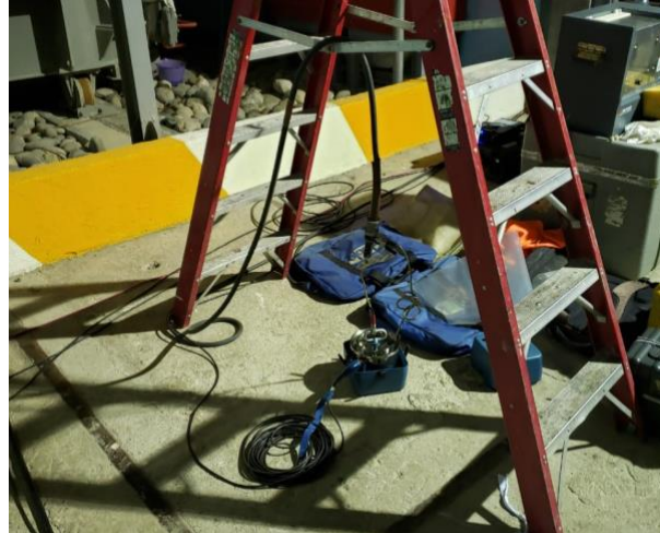
Imagen 30 - Prueba de factor de potencia del aceite de los transformadores.
