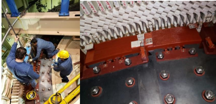
Imagen 32 - Colocación de polos al rotor.
