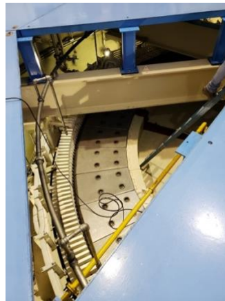
Imagen 35 - Colocación de tolvas.
