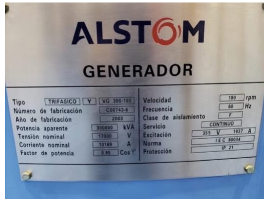
Imagen 11 - Placa de datos del generador sincrónico.
