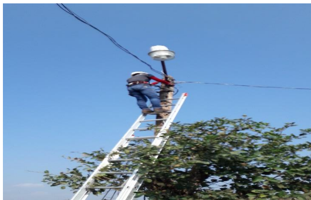
Fig. 44. Verificación de soportes del alumbrado publico
