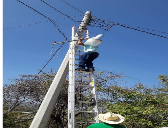
Fig. 48. Desmonte de alumbrado publico
