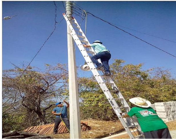
Fig. 50. Colocación de alumbrado publico
