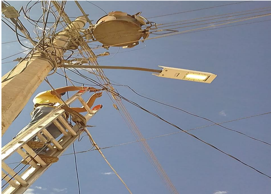
Fig. 46. Inspección de encendido de lámpara led
