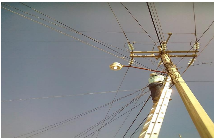
Fig. 47. Inspección de encendido lámpara ahorradora
