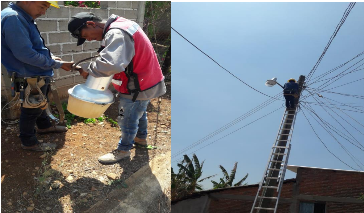
Fig. 54. Colocación de lámparas aditivo metálico 1
