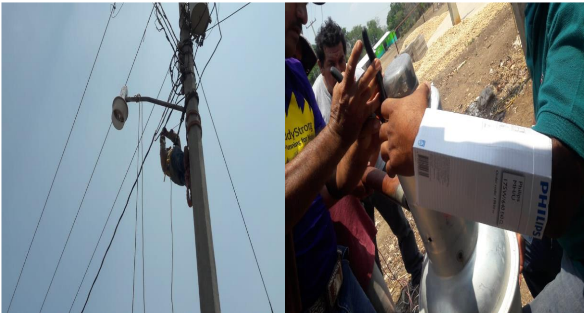
Fig. 57. Colocación de lámparas aditivo metálico 4
