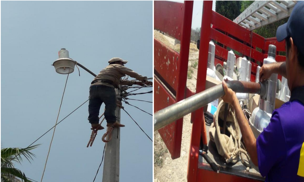
Fig. 56. Colocación de lámparas aditivo metálico 3
