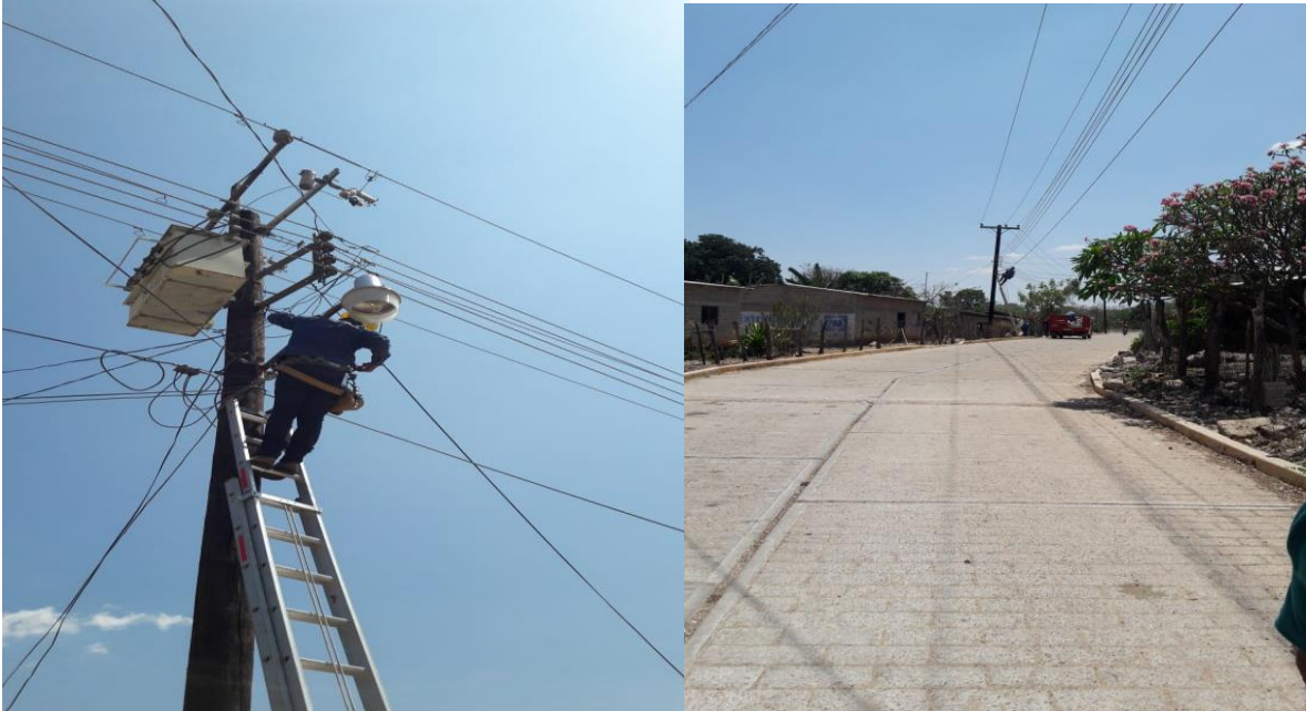
Fig. 55. Colocación de lámparas aditivo metálico 2
