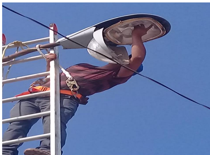
Fig. 45. Revisión de las lámparas
